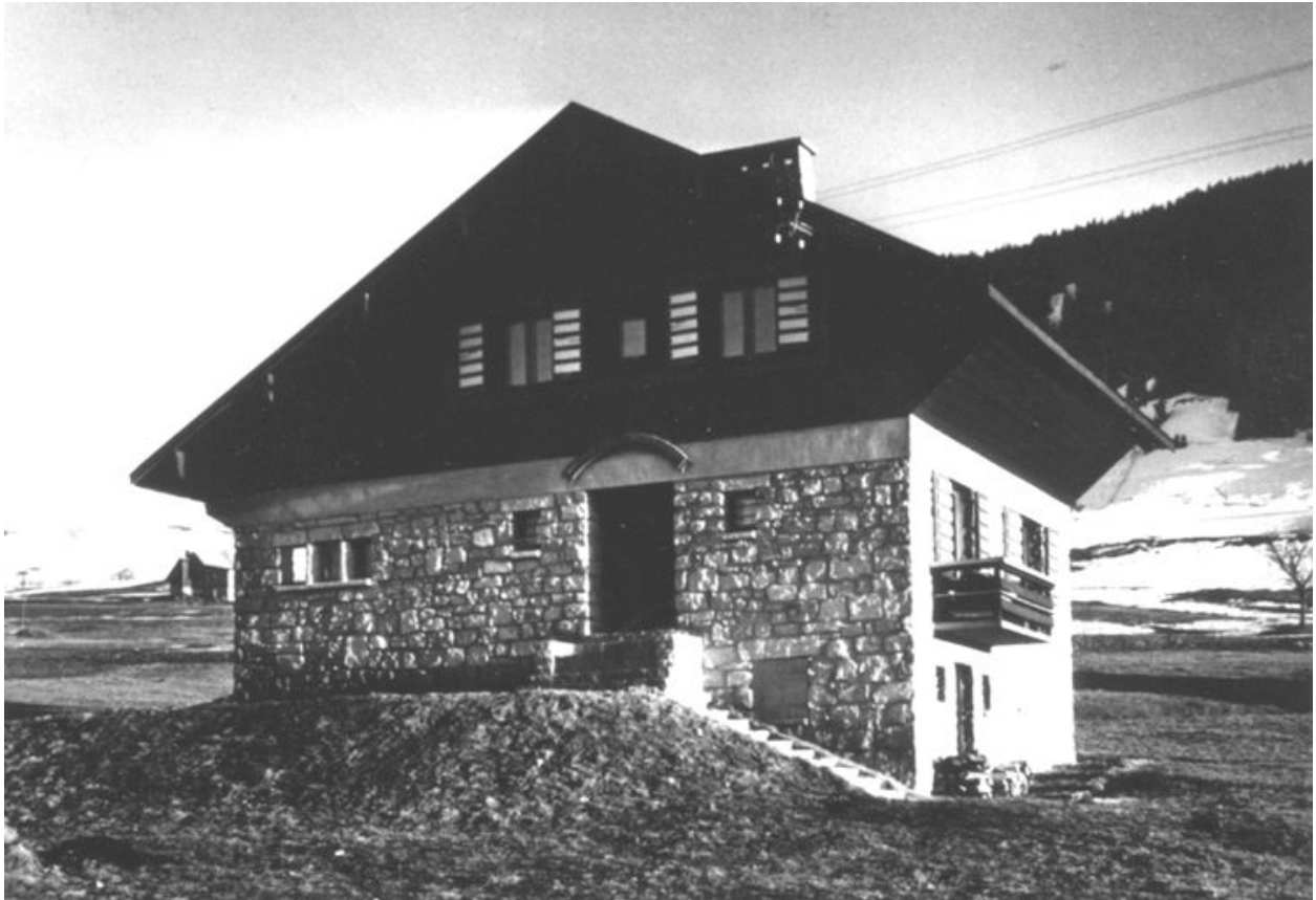
Élévation nord. Photogr. Vers 1945 (Dossier agence n° 362)
