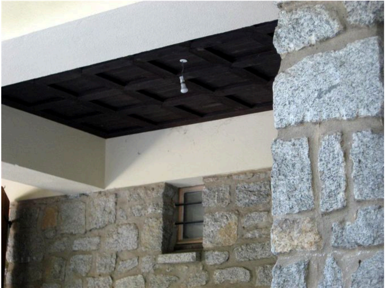
Détail du plafond du porche
