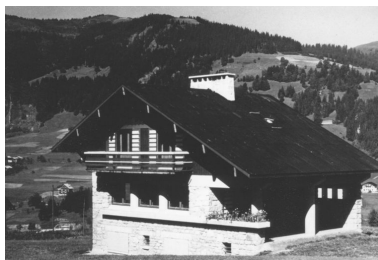
Vue depuis le sud-est. Photogr., vers 1945 (Dossier agence n° 362) Phot. F. Véry IVR82_20127401972NUCB
