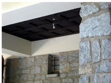
Détail du plafond du porche Phot. Mairie de Megève- Service Urbanisme IVR82_20127401977NUCA
