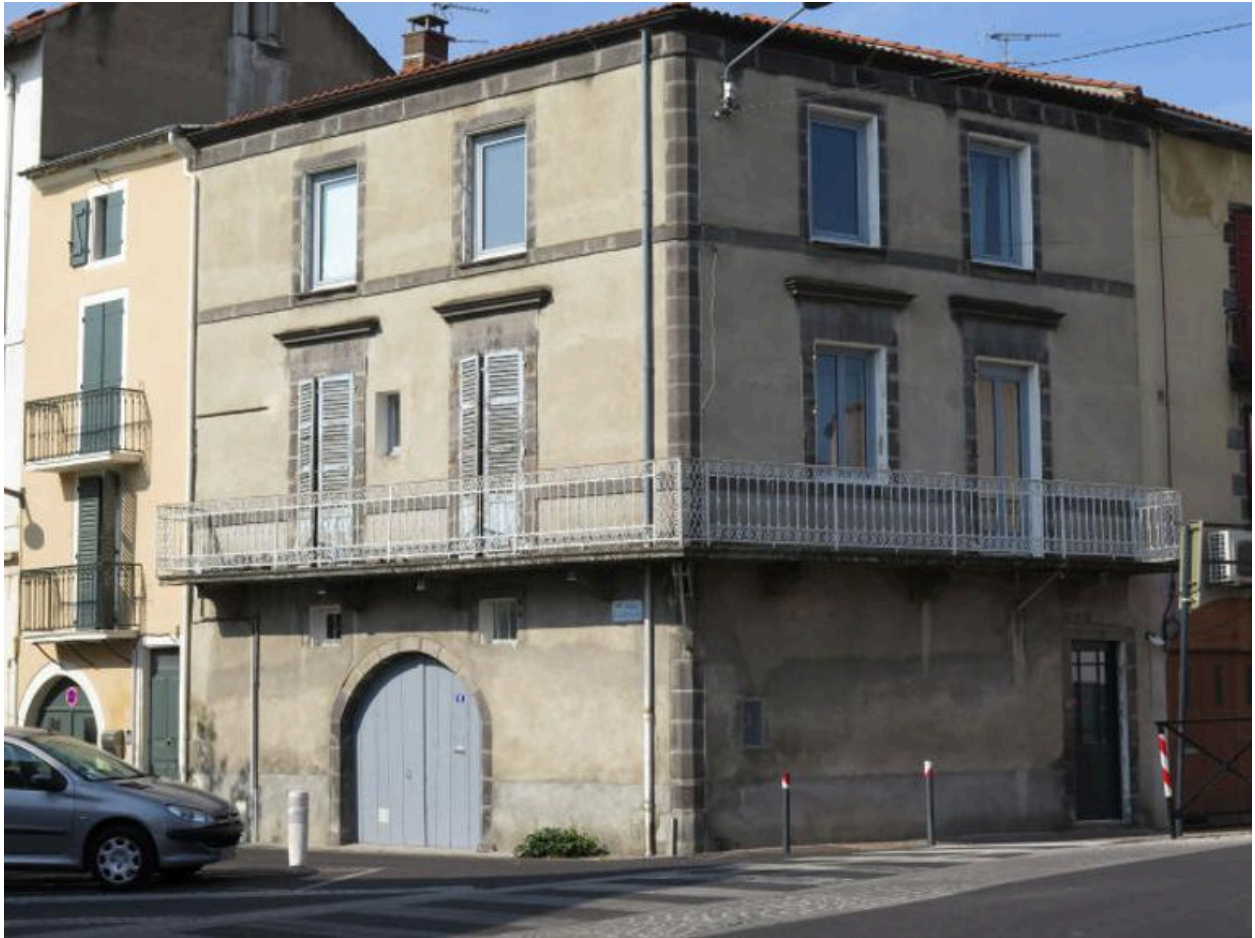
Vue générale façades principale et latérale
