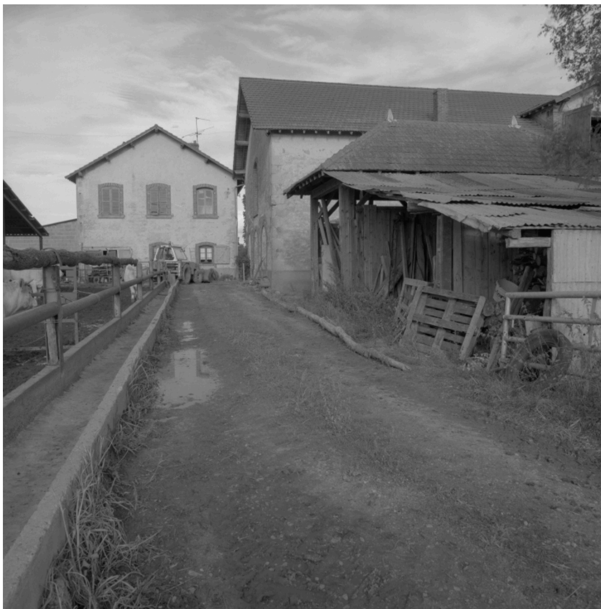
Vue du pignon du logis et de l'arrière de la grange-étable, depuis l'ouest.
