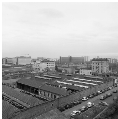
Vue du central téléphonique dans le paysage en 2002 Phot. Didier Gourbin IVR82_20026904457X
