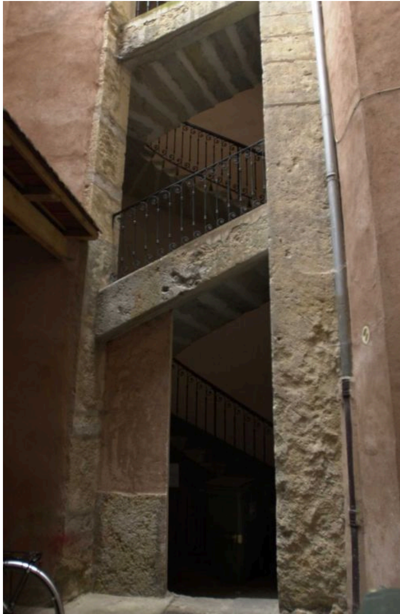
Départ de l'escalier depuis la cour
