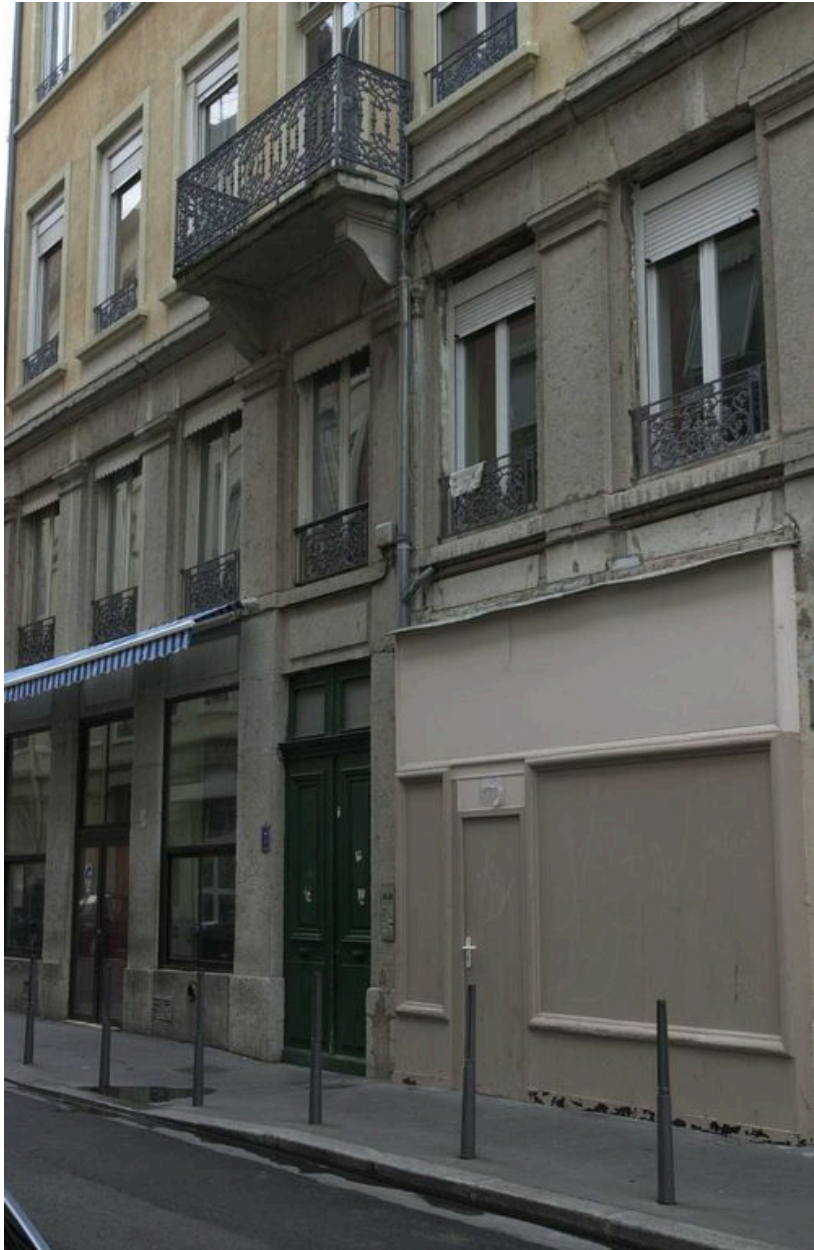
Elévation principale, rue Bèchevelin
