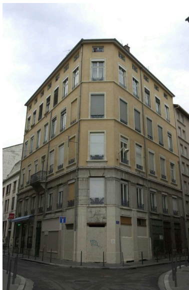
Vue générale depuis le sud-est, angle des rues des Trois-Rois et Bèchevelin IVR82_20026902760NUCA
