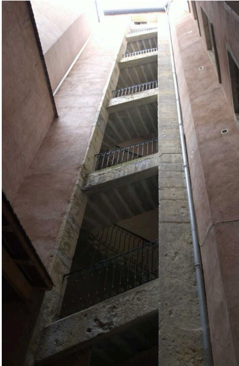
Vue générale de l'escalier depuis la cour
