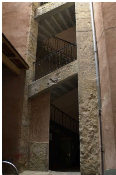
Départ de l'escalier depuis la cour IVR82_20026902766NUCA
