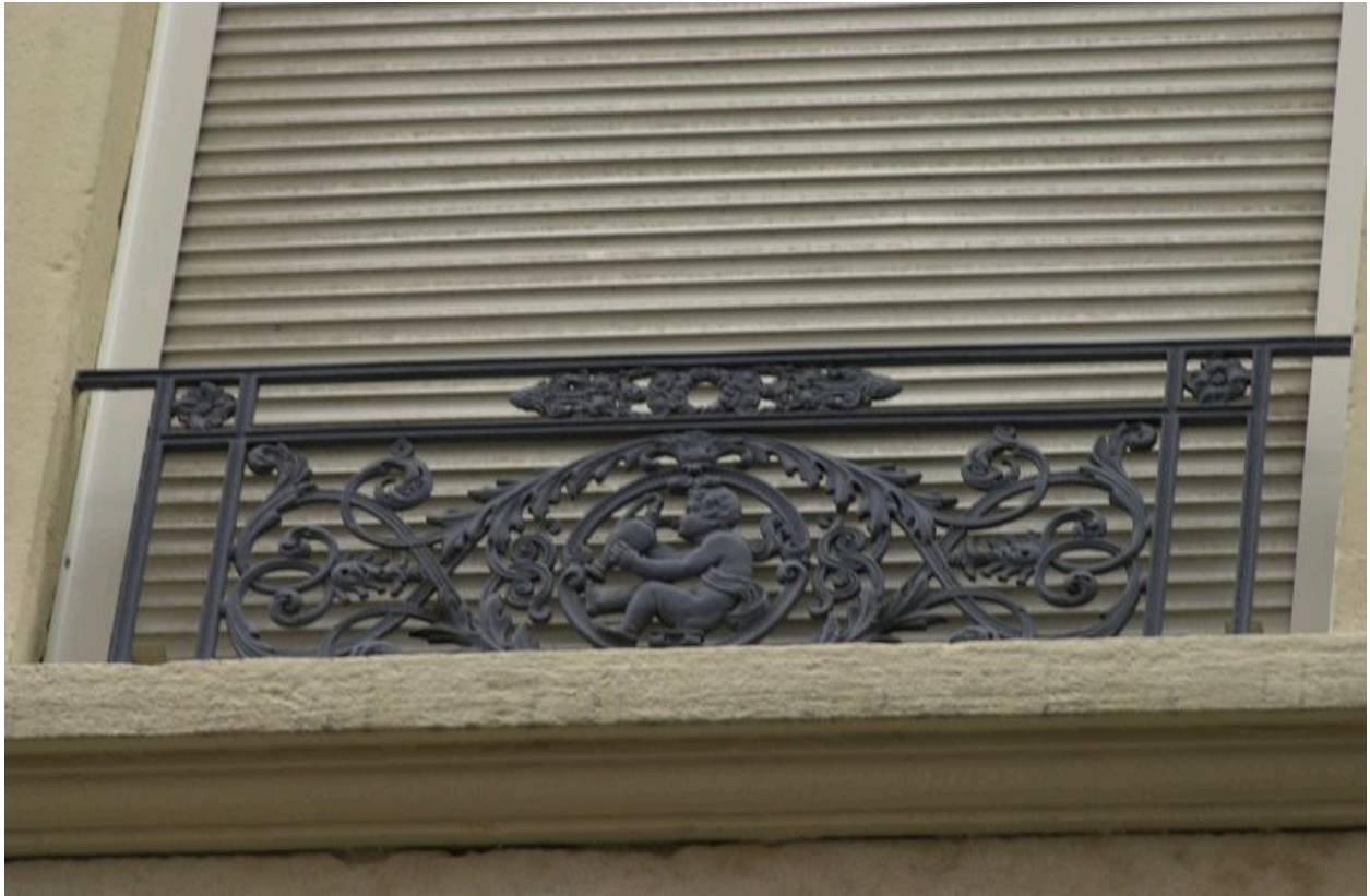
Détail d'un garde corps, 1er étage, rue des Trois-Rois
