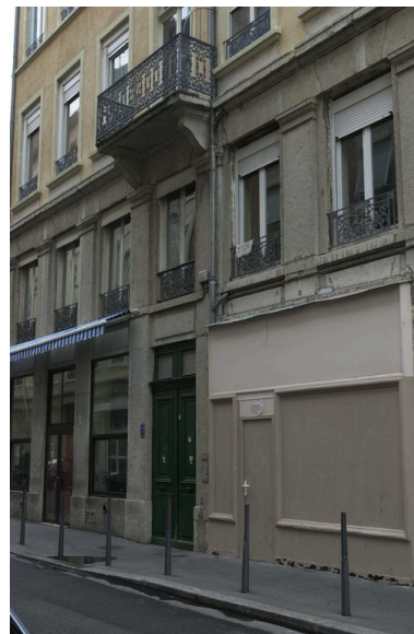
Elévation principale, rue Bèchevelin IVR82_20026902762NUCA
