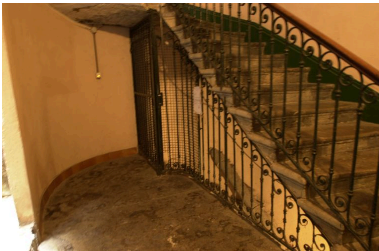
Vue de la rampe d'escalier
