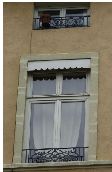
Fenêtres des 2e et 3e étages, rue des Trois-Rois IVR82_20026902777NUCA
