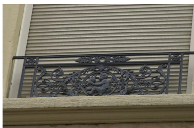
Détail d'un garde corps, 1er étage, rue des Trois-Rois IVR82_20026902763NUCA
