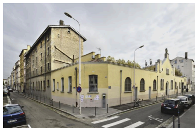
Vue du croisement avec la rue Sébastien-Gryphe, au niveau du couvent du Prado Phot. Franck Trabouillet IVR84_20186901179NUCAQ
