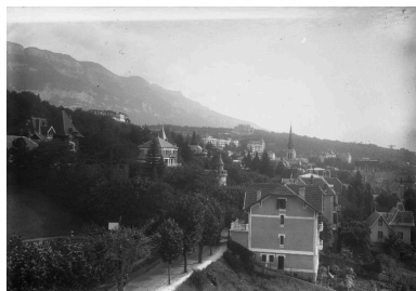
Vue vers le sud, vers 1930 Repro. Denys Harreau IVR82_20137301155NUCB
