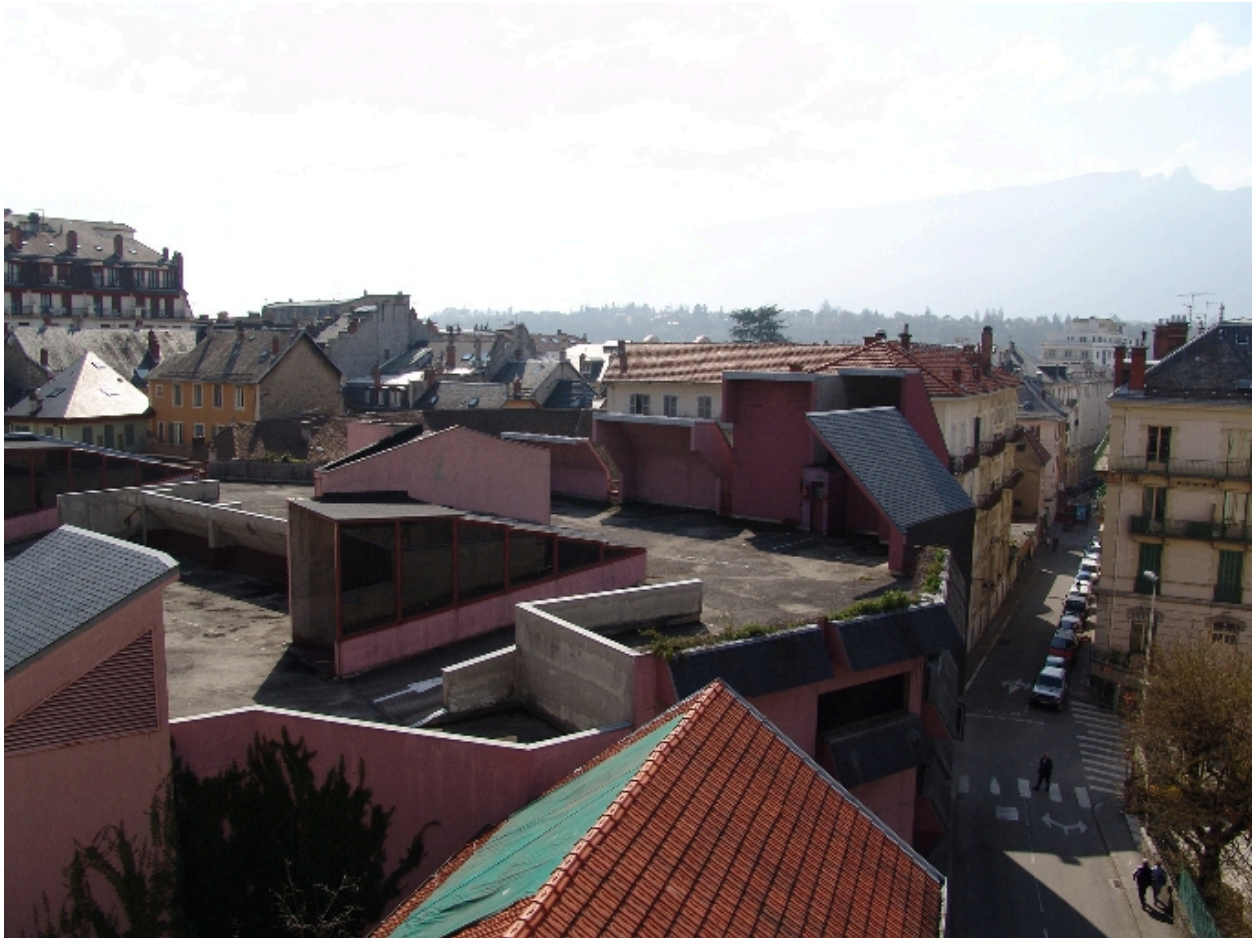
Vue des toits
