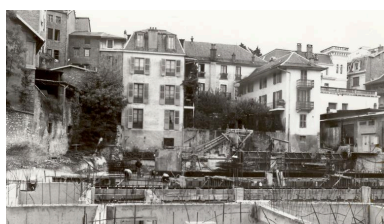
Construction des fondations du parking, 1979 Repro. Denys Harreau IVR82_20147300062NUCB
