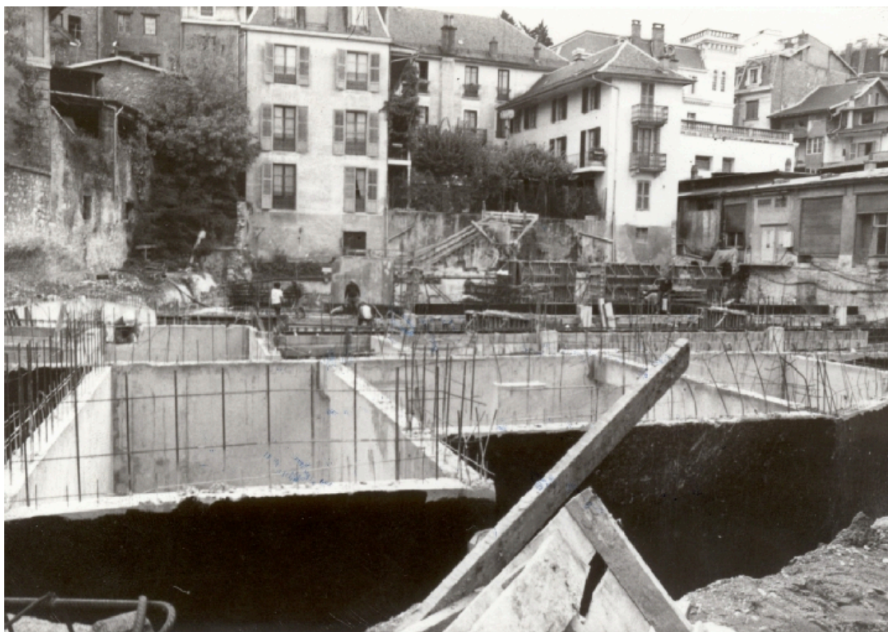
Construction des fondations du parking, 1979
