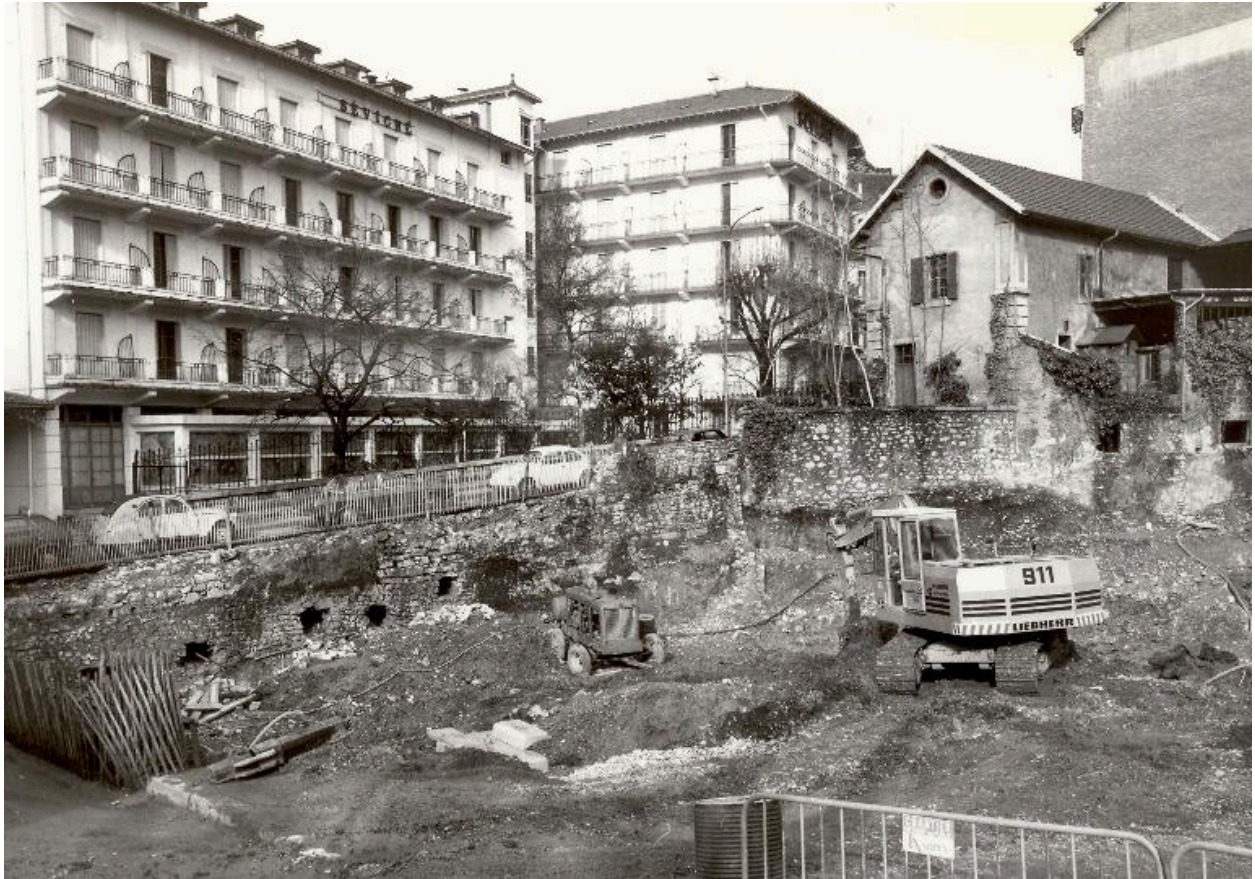
Préparation du terrain pour la construction des fondations du parking, 1979
