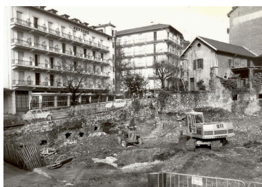
Préparation du terrain pour la construction des fondations du parking, 1979 Repro. Denys Harreau IVR82_20147300061NUCB
