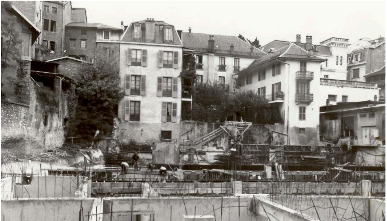
Construction des fondations du parking, 1979
