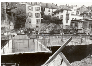
Construction des fondations du parking, 1979 Repro. François Fouger IVR82_20057300749NUCB
