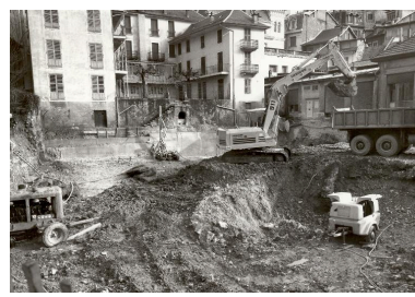
Préparation du terrain pour la construction des fondations du parking, 1979 Repro. Denys Harreau IVR82_20157301197NUCB
