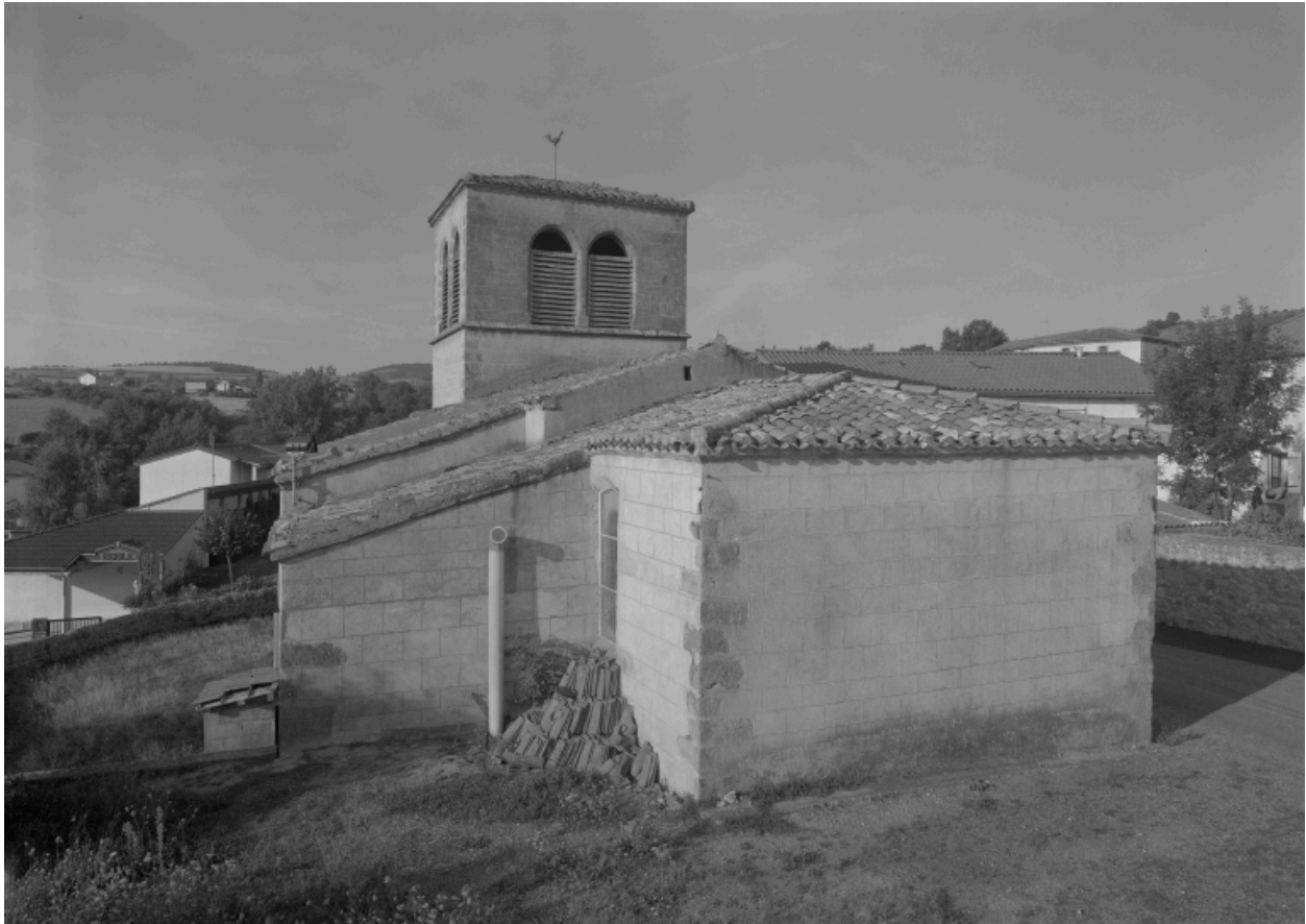
Vue d'ensemble du chevet, de trois-quarts gauche.
