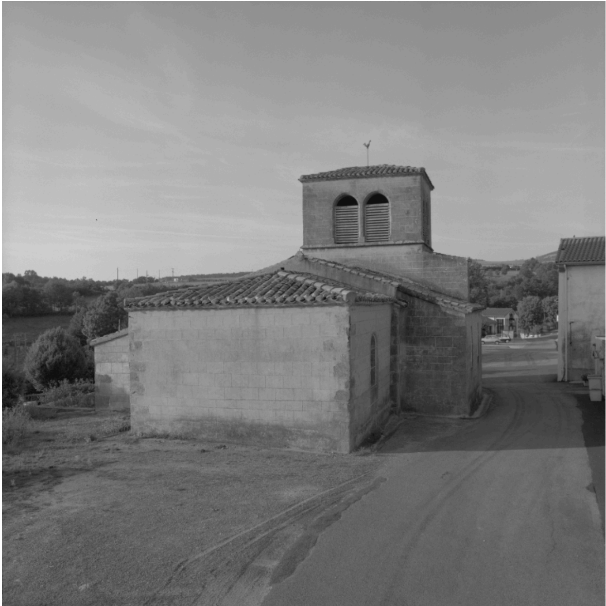
Vue d'ensemble du chevet, de trois-quarts droite.
