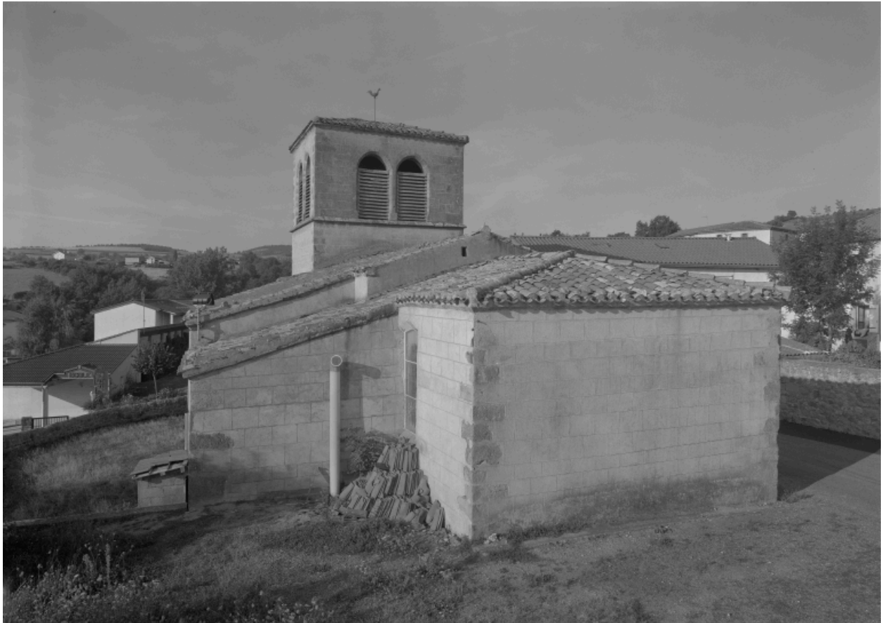
Vue d'ensemble du chevet, de trois-quarts gauche.
