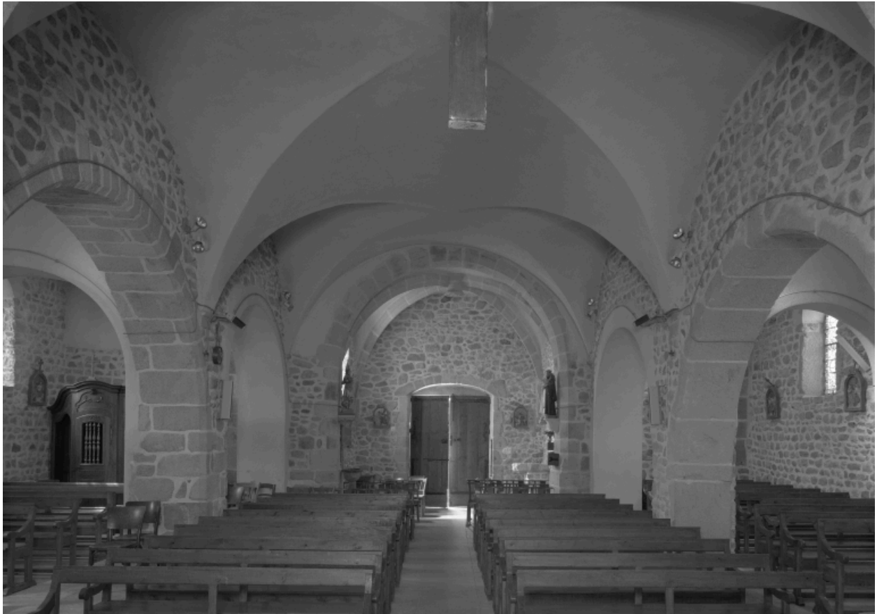
Vue intérieure de la nef, vers l'ouest.
