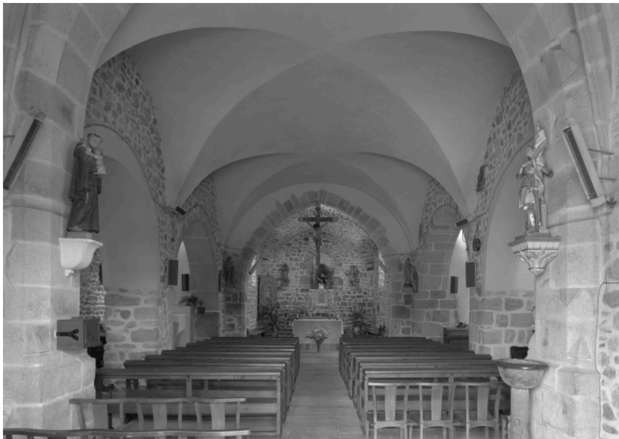
Vue intérieure de la nef, vers le chœur.
