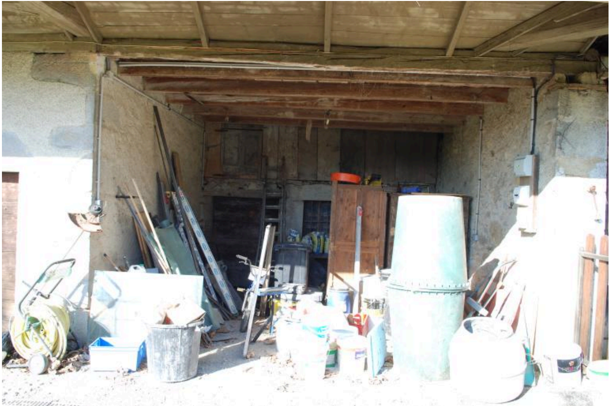
Détail de l'espace latéral droit de la façade principale, avec l'espace en retrait.
