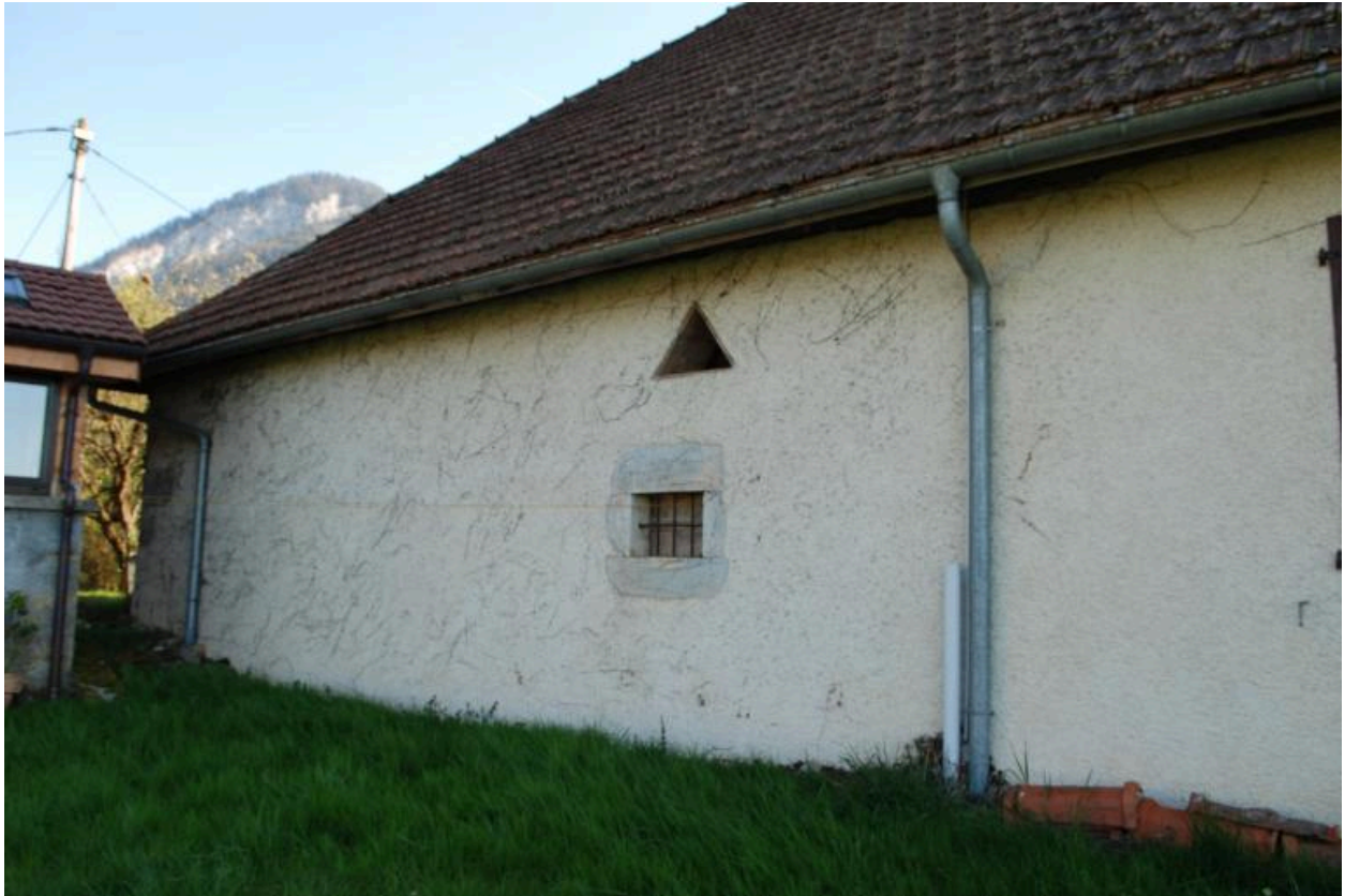
Vue partielle de la façade arrière de la ferme, avec une ouverture de forme triangulaire de la grange.
