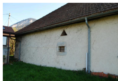
Vue partielle de la façade arrière de la ferme, avec une ouverture de forme triangulaire de la grange. Phot. Thierry Monnet IVR84_20187400145NUCA
