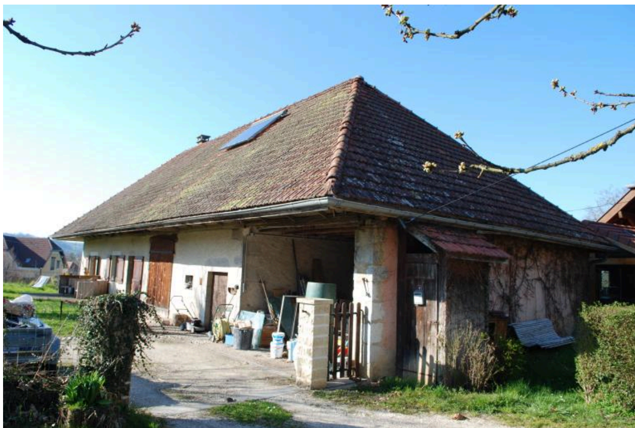
Vue d'ensemble de trois-quarts avant droit
