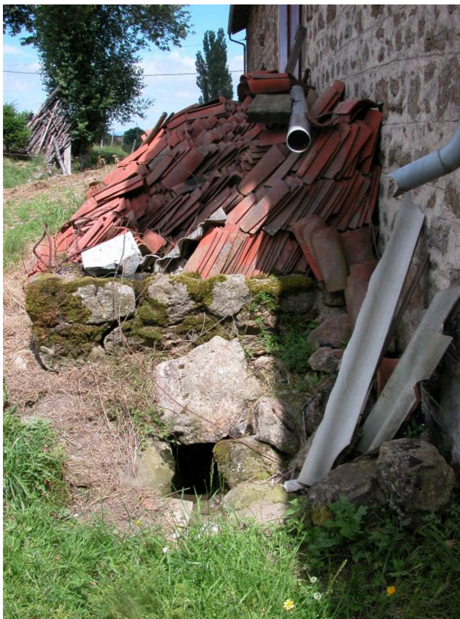
Arrière de la ferme, détail du drain passant sous le montoir.
