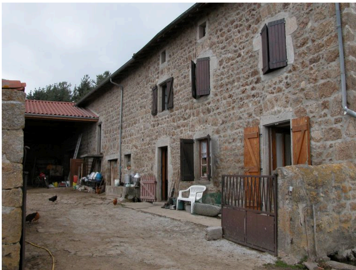
Vue d'ensemble de la façade sur cour.
