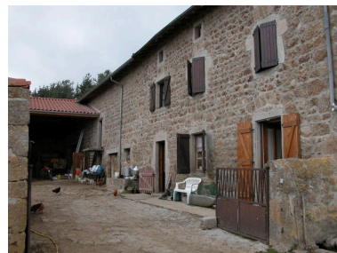
Vue d'ensemble de la façade sur cour. Phot. Thierry Monnet IVR82_20124200569NUCA
