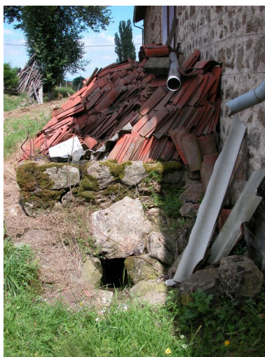
Arrière de la ferme, détail du drain passant sous le montoir. Phot. Thierry Monnet IVR82_20134200186NUCA
