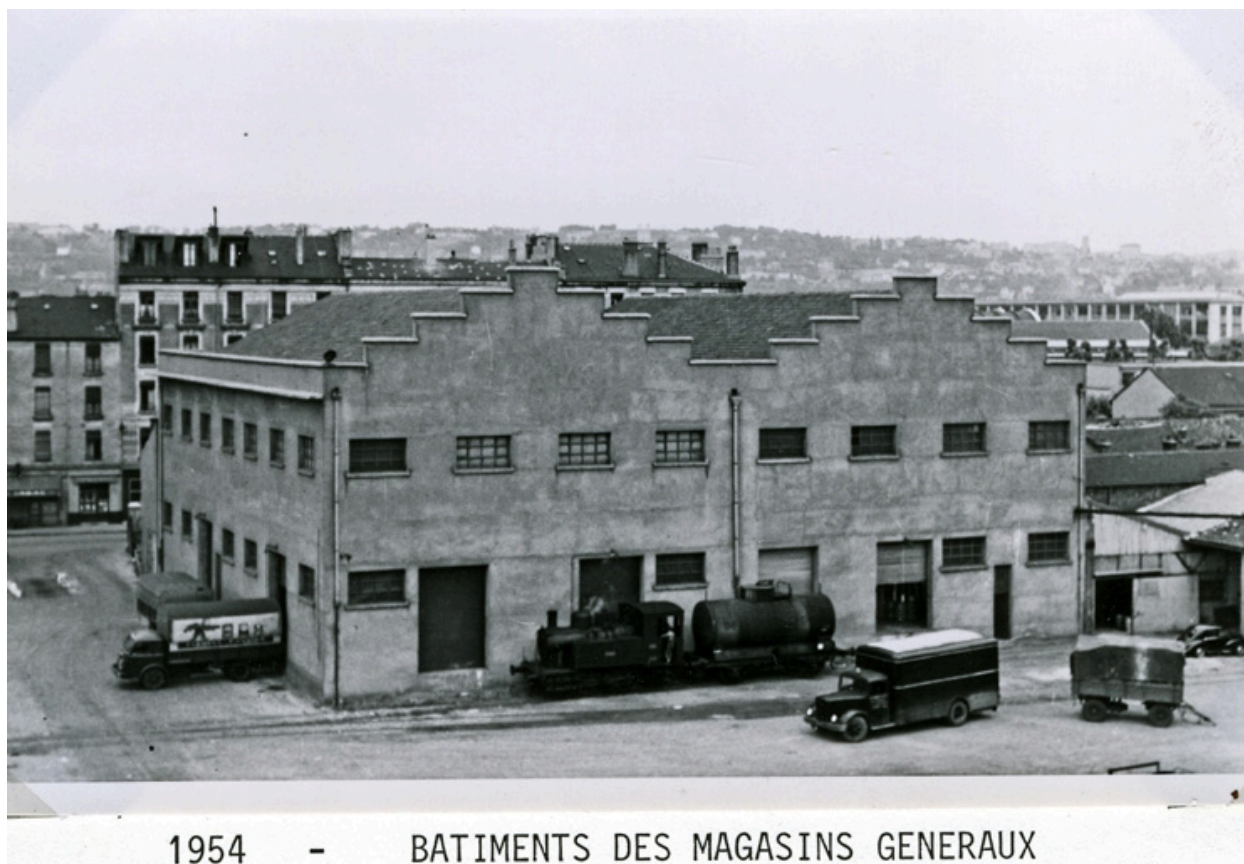
Bâtiments des magasins généraux
