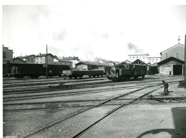
Magasins Généraux vers 1964, (Cuy1) Repro. Didier Gourbin IVR82_20126900215NUCB
