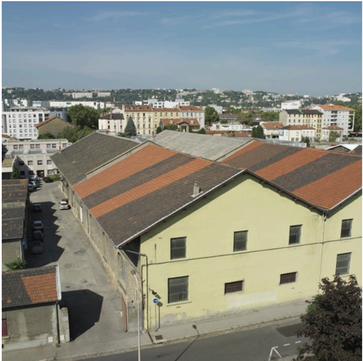
Vue d'ensemble des entrepôts de la rue Massimi
