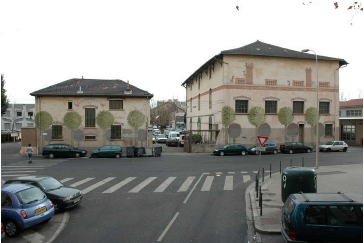
Vue générale ouest, façade rue de Gerland.
