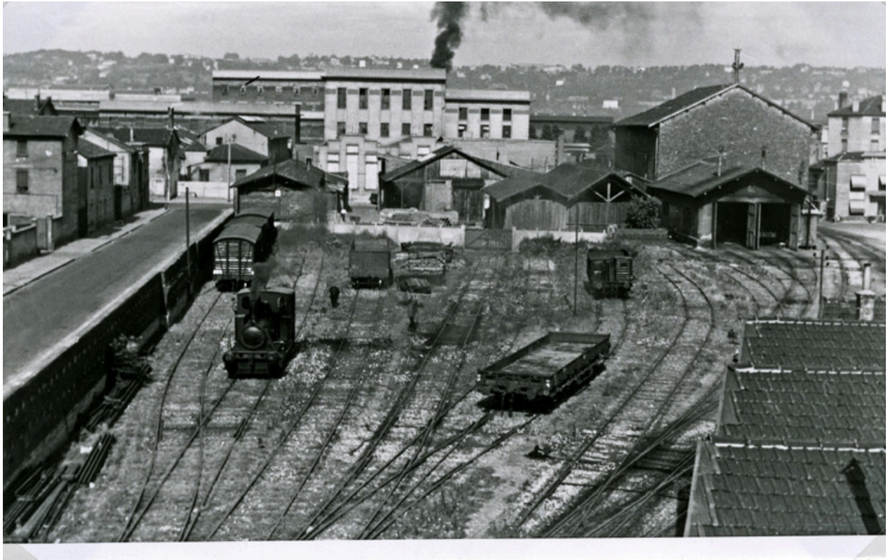
1954 - FAISCEAU DE TRIAGE des MAGASINS GENERAUX
