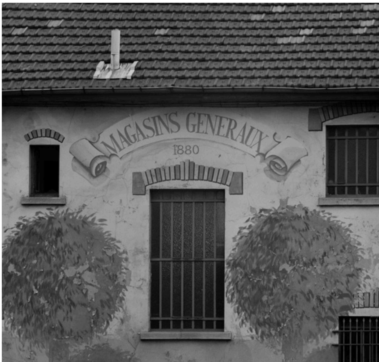
Enseigne et date portée
