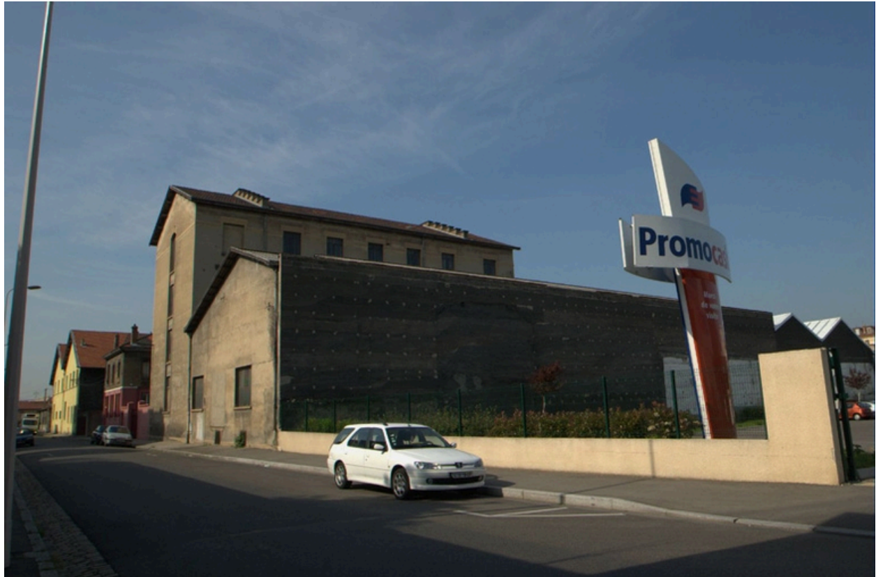
Vue nord-est des entrepôts généraux (rue Paul Massimi)
