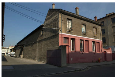
Détail bâtiment 24, 26 rue Paul Massimi Phot. Nadine Halitim-Dubois IVR82_20086900409NUCA
