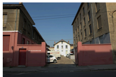
Entrée du 24, 26 rue Paul Massimi Phot. Nadine Halitim-Dubois IVR82_20086900410NUCA
