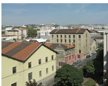
Vue d'ensemble sud de la rue Massimi Phot. Eric Dessert IVR82_20066902803NUCA
