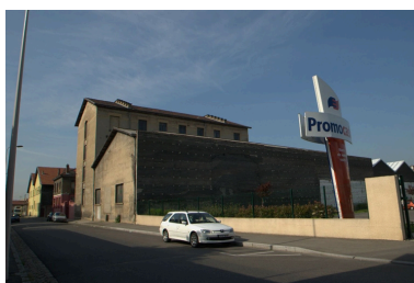
Vue nord-est des entrepôts généraux (rue Paul Massimi) Phot. Nadine Halitim-Dubois IVR82_20086900406NUCA
