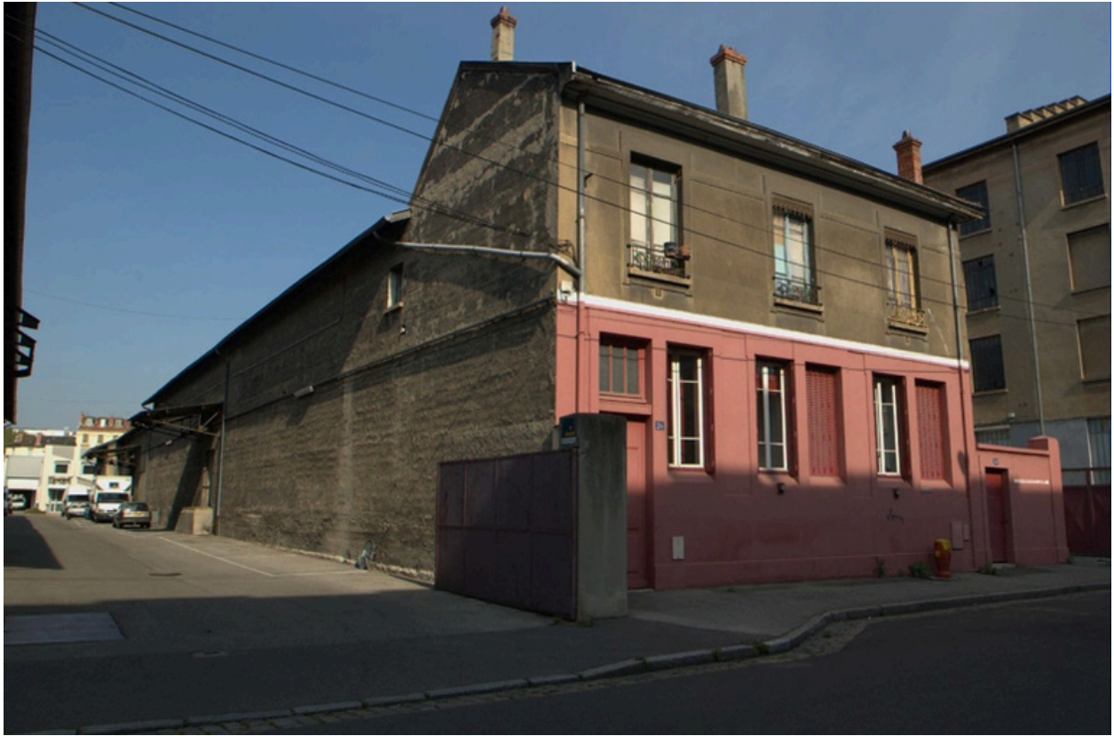
Détail bâtiment 24, 26 rue Paul Massimi
