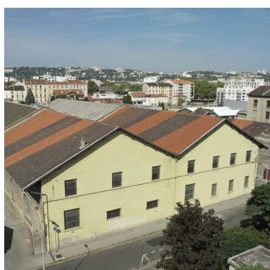
Vue d'ensemble de la double halle rue Massimi (sud-est) Phot. Eric Dessert IVR82_20066902802NUCA
