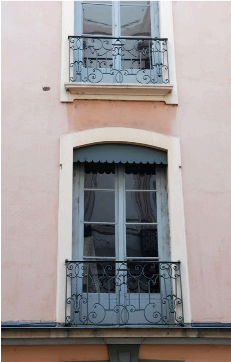
Elevation antérieure, baie du premier étage
