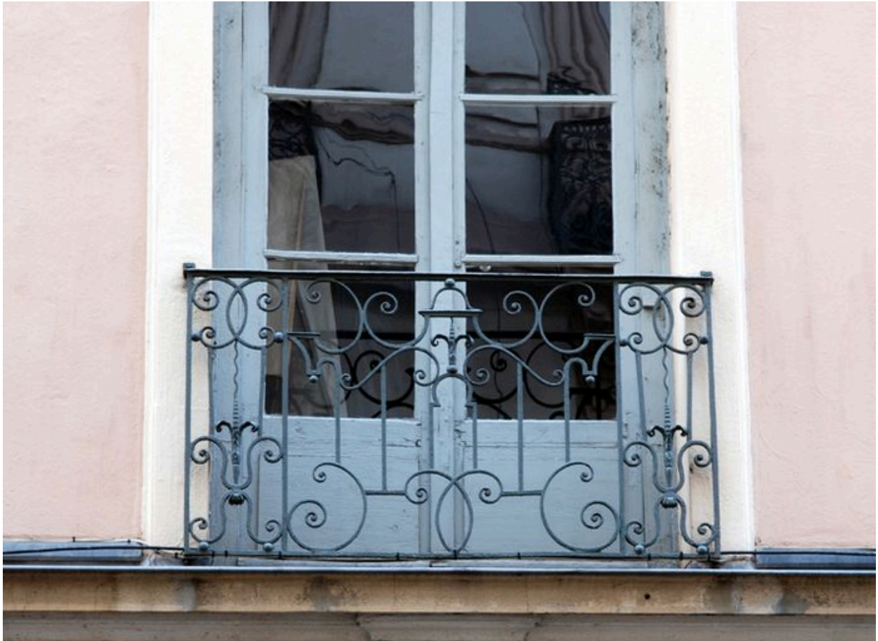
Elévation antérieure, détail d'un garde-corps en ferronnerie.
