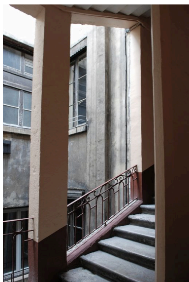
Cage d'escalier, repos entre le deuxième et le troisième étage avec baies sur cour. Phot. Catherine Guégan IVR82_20096900593NUCA
