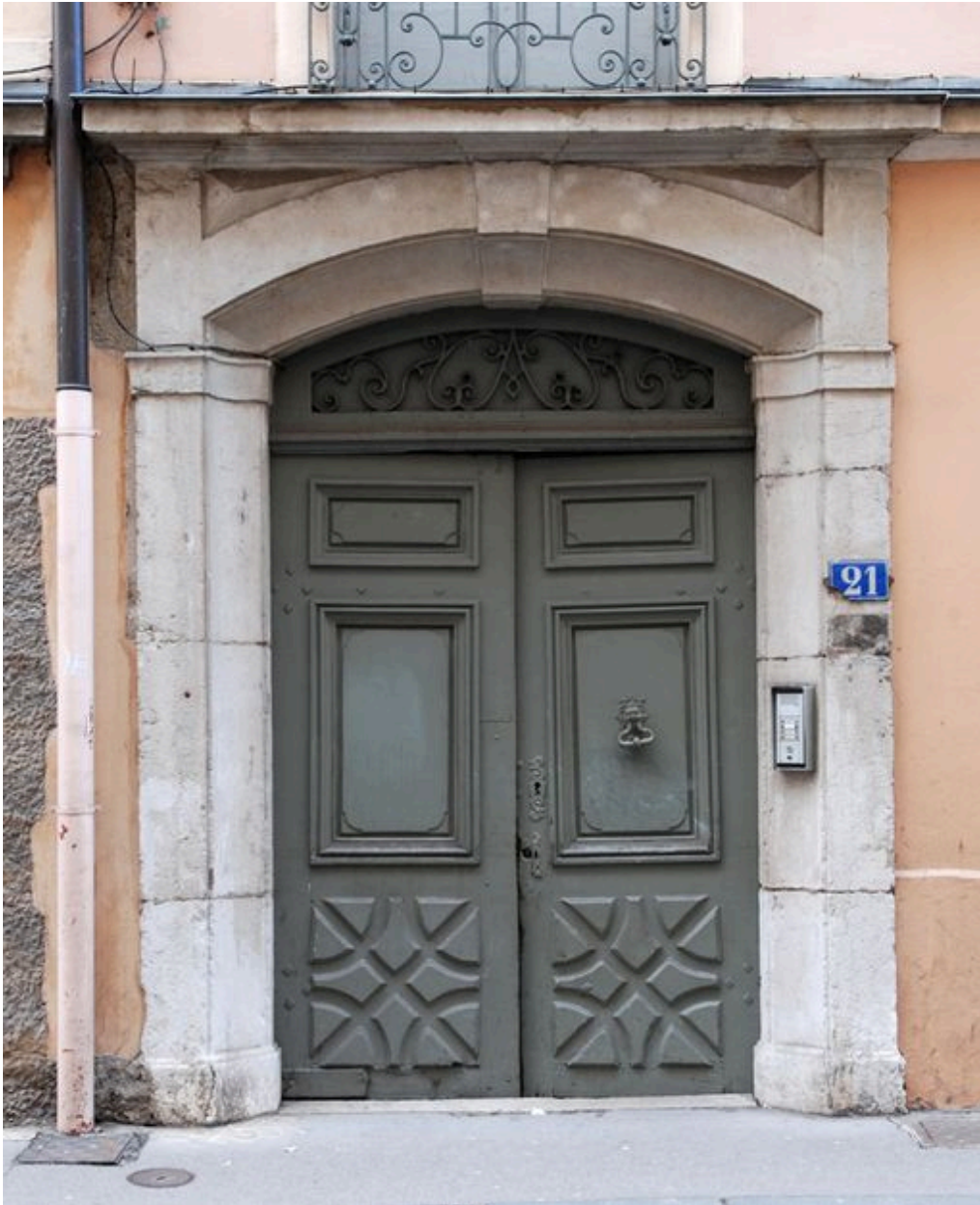
Elévation antérieure, porte du rez-de-chaussée
