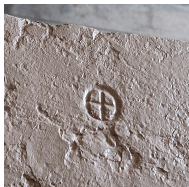
Cage d'escalier, marque de tâcheron. Phot. Catherine Guégan IVR82_20096900640NUCA
