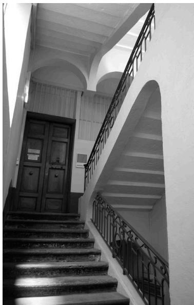
Cage d'escalier, palier du deuxième étage. Phot. Catherine Guégan IVR82_20096900591NUC
