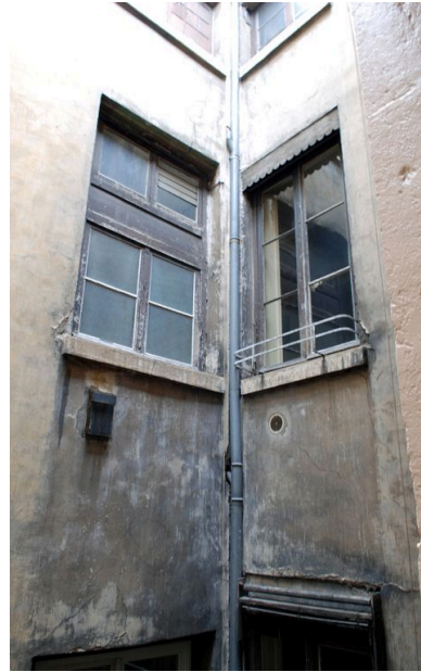
Vue sur cour, détail de deux baies. Phot. Catherine Guégan IVR82_20096900639NUCA
