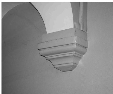
Cage d'escalier, détail de l'arcade : culot mouluré Phot. Catherine Guégan IVR82_20096900586NUC
