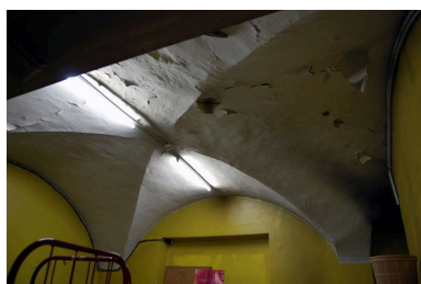
Voûte en croisée d'arrêtes d'une pièce au rez-de-chaussée, accessible depuis la cour. Phot. Catherine Guégan IVR82_20096900644NUCA
