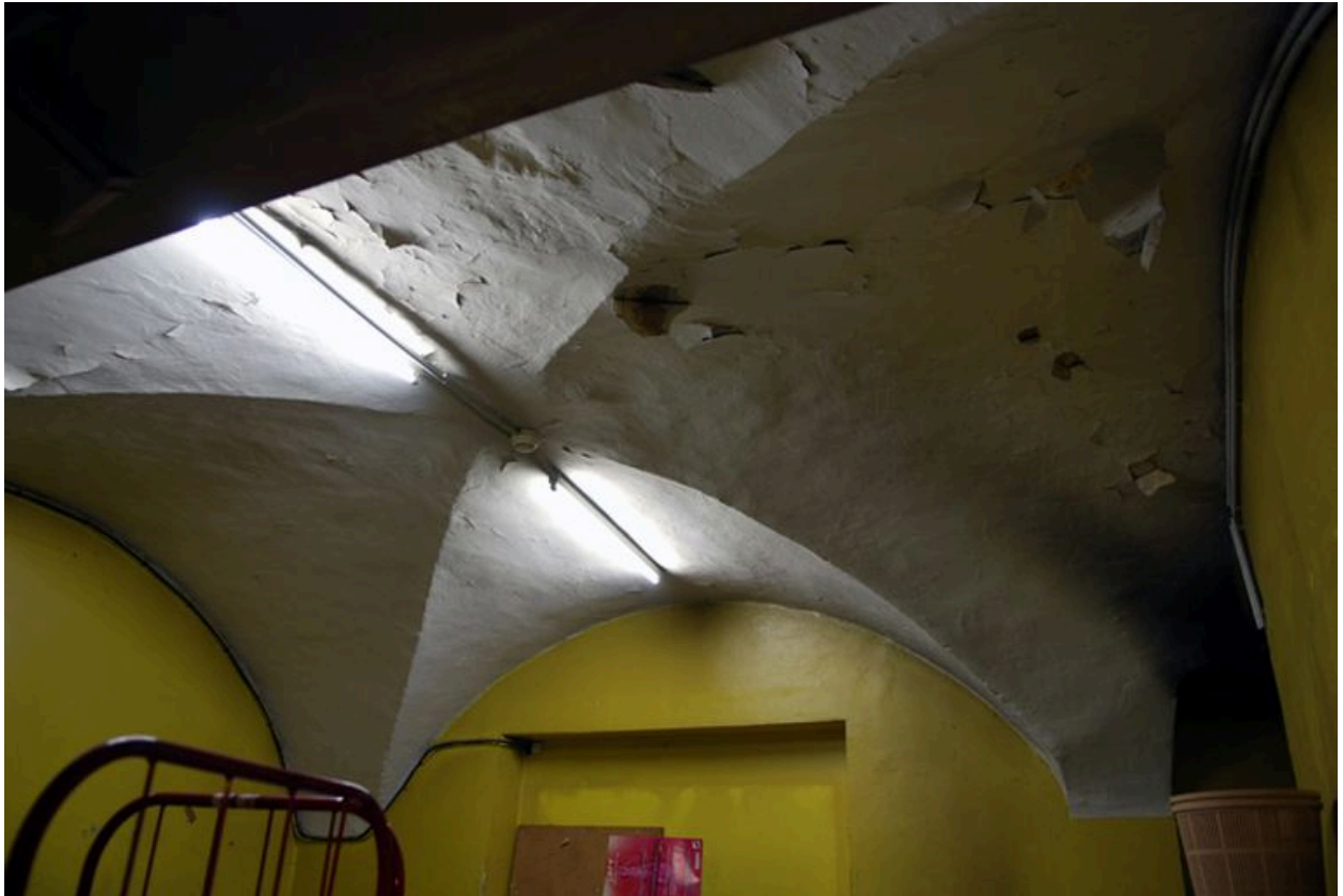
Voûte en croisée d'arrêtes d'une pièce au rez-de-chaussée, accessible depuis la cour.
