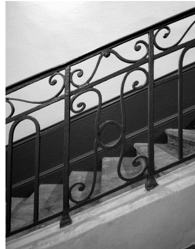
Escalier, détail de la rampe. Phot. Catherine Guégan IVR82_20096900585NUC
