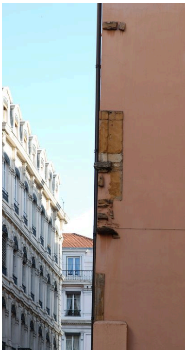
Elévation latérale, détail de l'arrachement Phot. Catherine Guégan IVR82_20096903424NUCA
