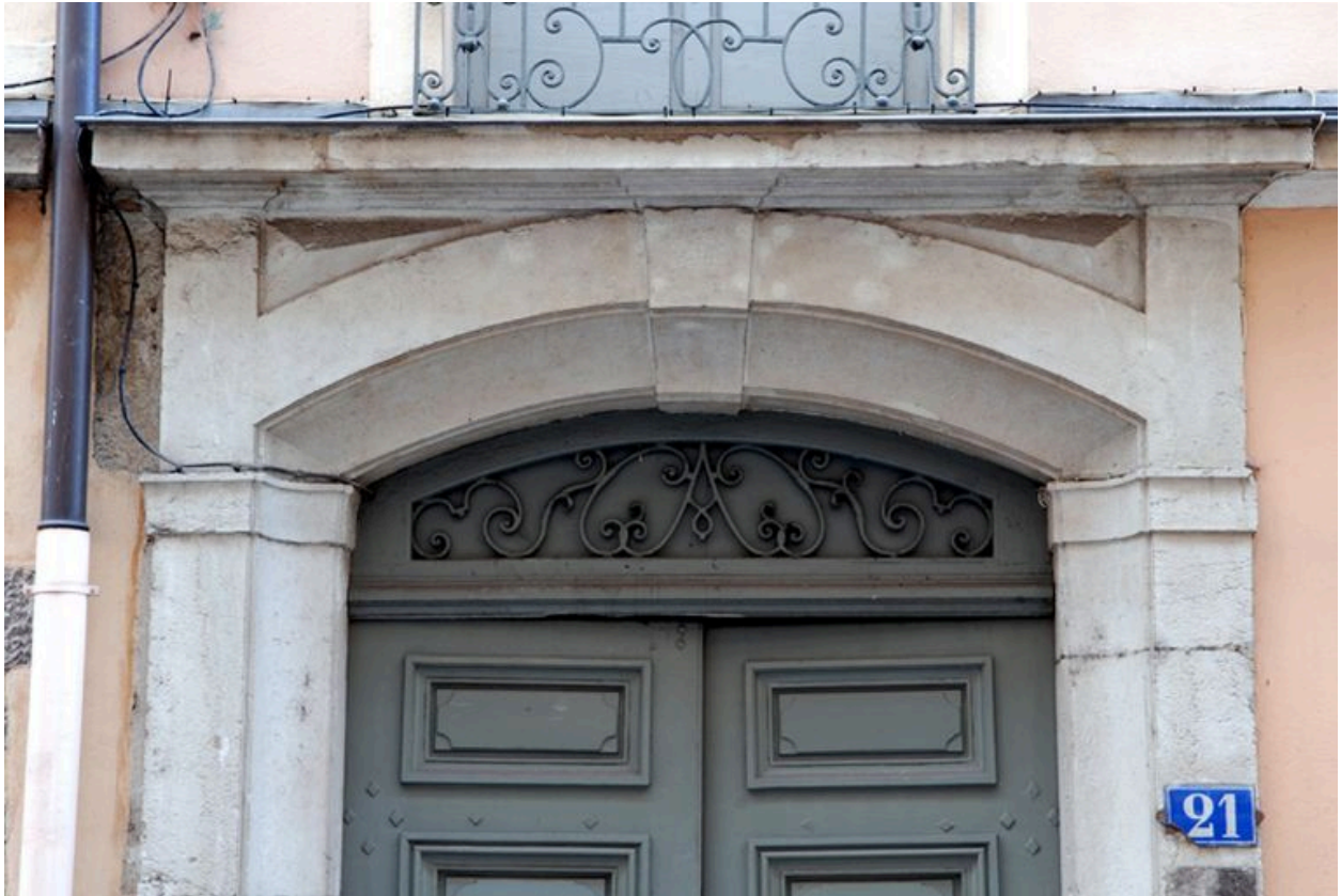
Elévation antérieure, détail de la porte : imposte
