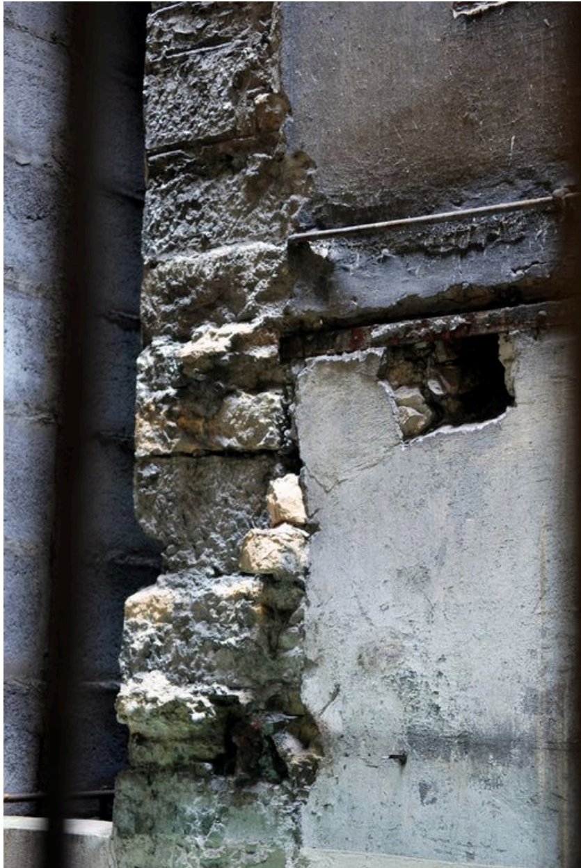
Vue sur cour, détail de chaînage.
