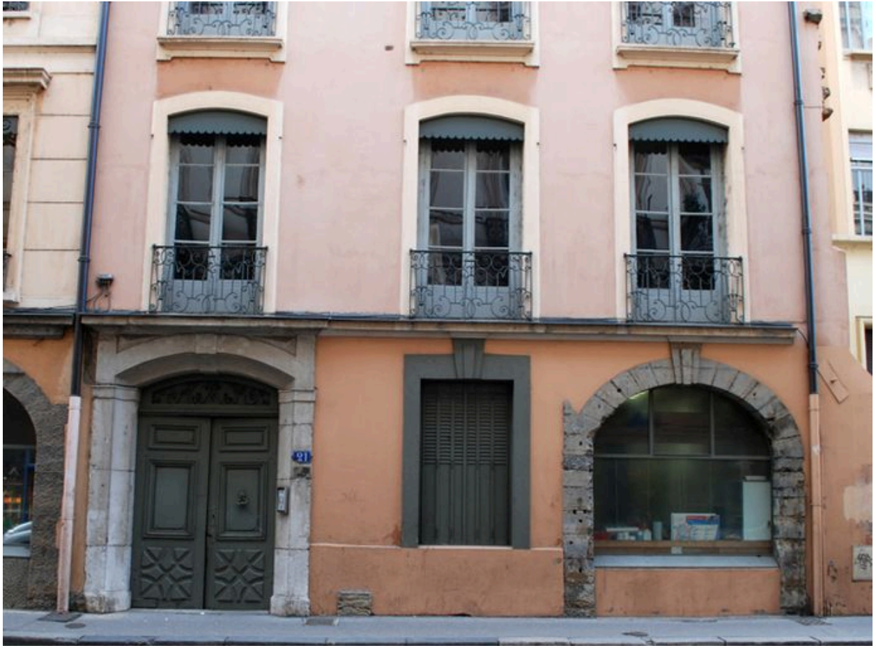
Elevation antérieure, vue du rez-de-chaussée et du premier étage
