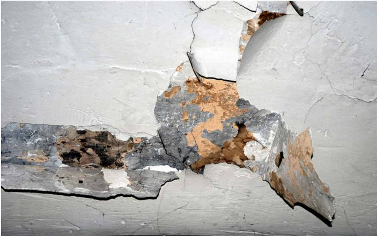
Pièce accessible depuis la cour, détail de la voûte.
