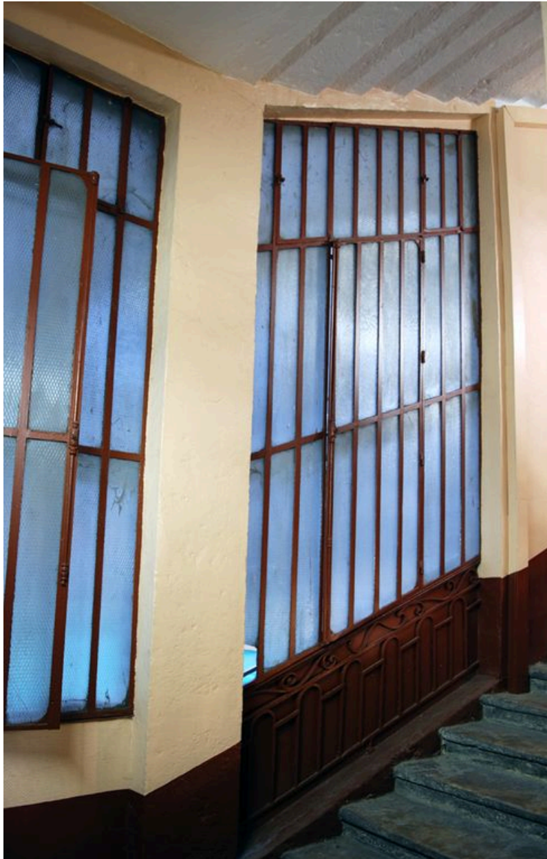
Cage d'escalier, baies sur cour entre le premier et le deuxième étage.
