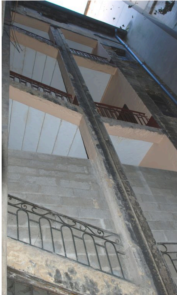
Baies de la cage d'escalier depuis la cour.
