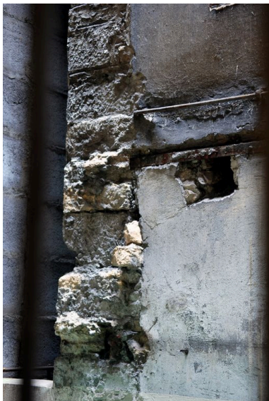
Vue sur cour, détail de chainage. Phot. Catherine Guégan IVR82_20096900641NUCA
