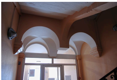
Cage d'escalier, rez-de-chaussée, double croisée d'arrêtes reposant sur culots moulurés et clés pendantes. Phot. Catherine Guégan IVR82_20096900587NUCA
