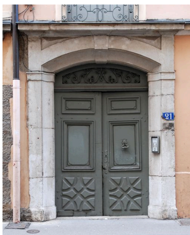
Elévation antérieure, porte du rez-de-chaussée Phot. Catherine Guégan IVR82_20096900580NUCA
