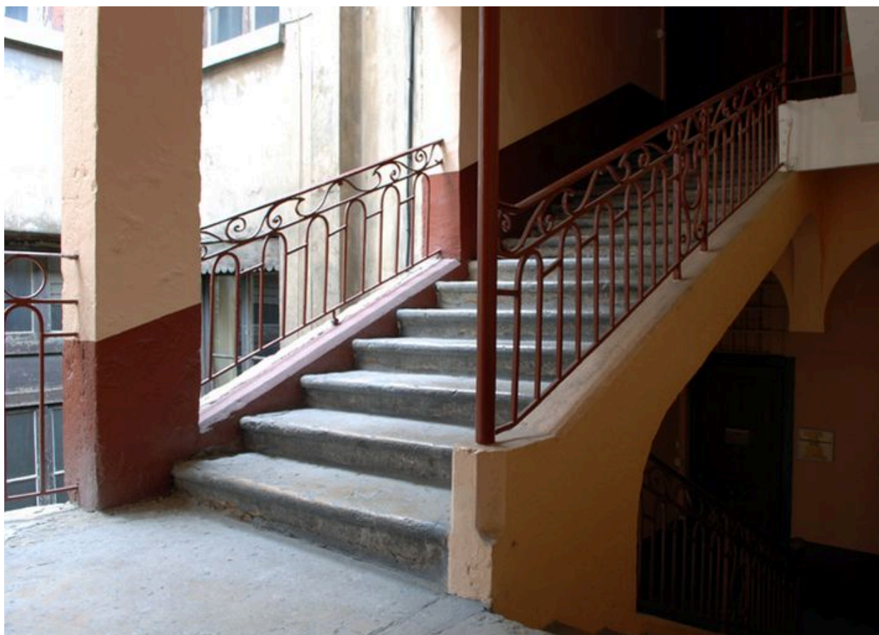
Cage d'escalier, volée entre repos et troisième étage.
