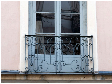
Elévation antérieure, détail d'un garde-corps en ferronnerie. Phot. Catherine Guégan IVR82_20096900579NUCA
