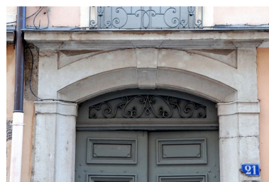
Elévation antérieure, détail de la porte : imposte Phot. Catherine Guégan IVR82_20096900581NUCA
