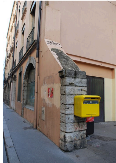
Elévation latérale : arrachement Phot. Catherine Guégan IVR82_20096903430NUCA
