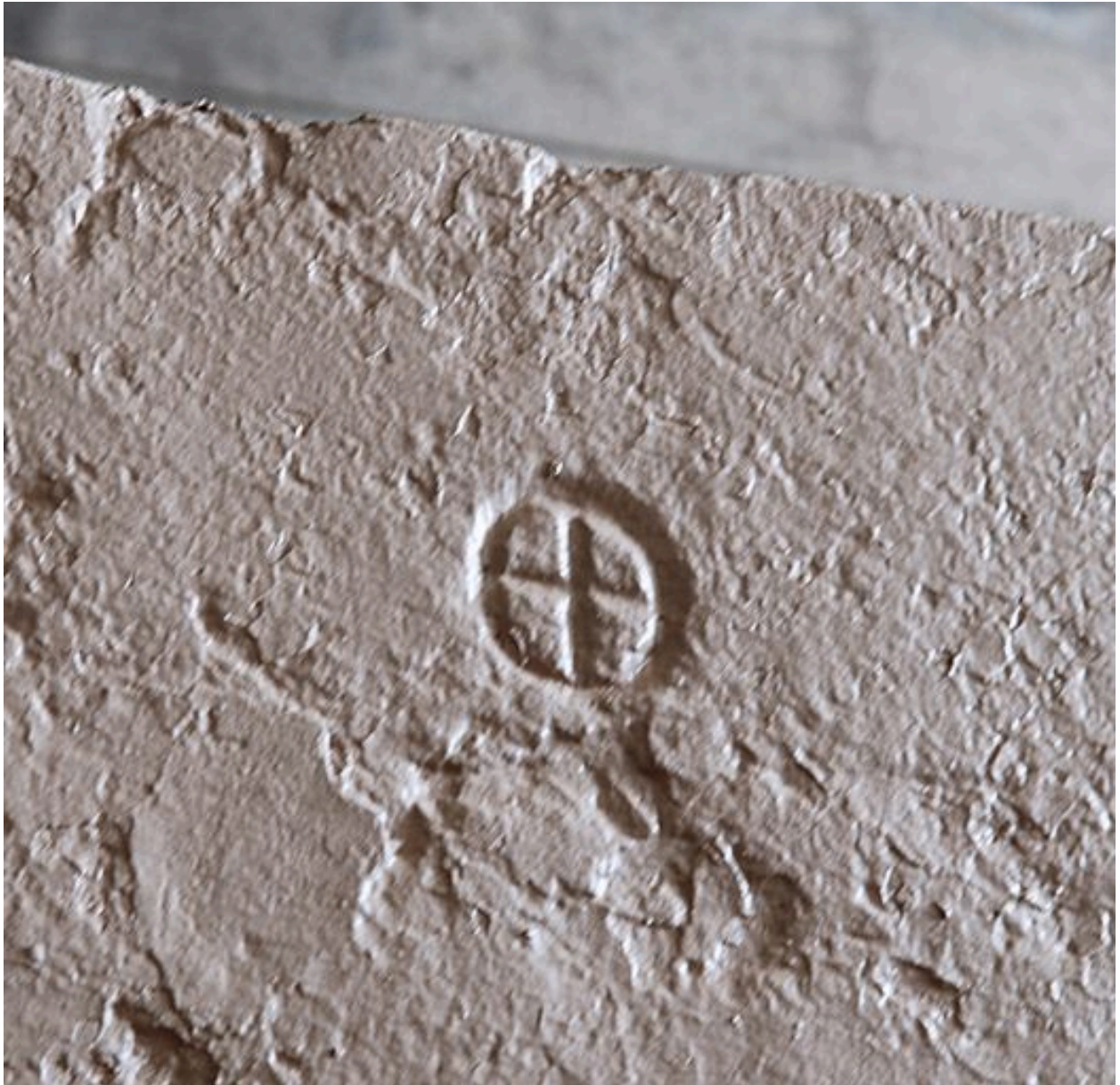
Cage d'escalier, marque de tâcheron.
