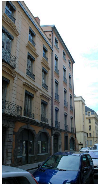
Elévation antérieure depuis nord-ouest Phot. Catherine Guégan IVR82_20096900577NUCA
