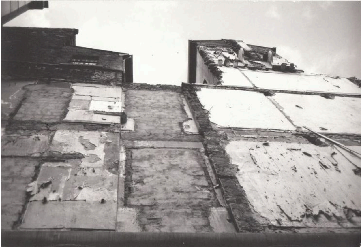
Elévation postérieure avec immeuble adjacent lors des travaux du Bâtiment ISARA (2nd phase), photographie ancienne, 1972
