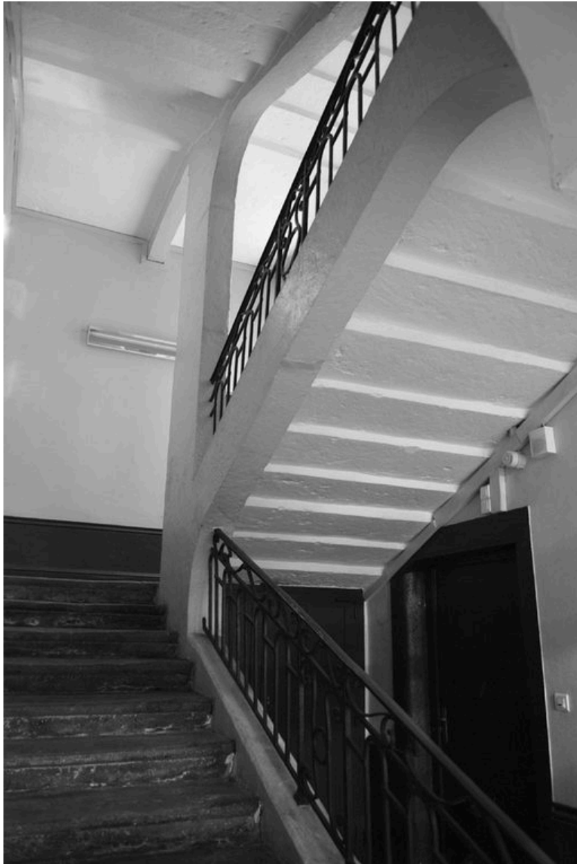
Escalier, vue depuis le rez-de-chaussée.
