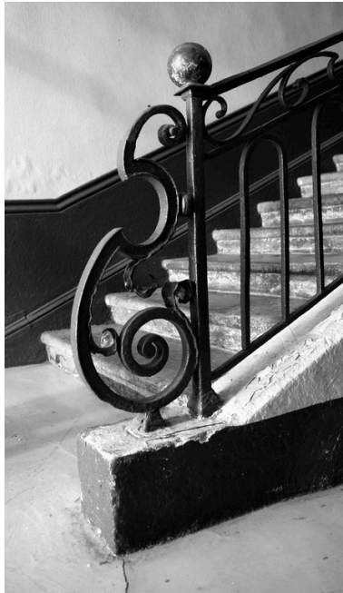
Escalier, détail du départ de rampe. Phot. Catherine Guégan IVR82_20096900584NUC
