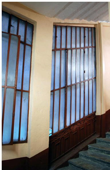
Cage d'escalier, baies sur cour entre le premier et le deuxième étage. Phot. Catherine Guégan IVR82_20096900590NUCA
