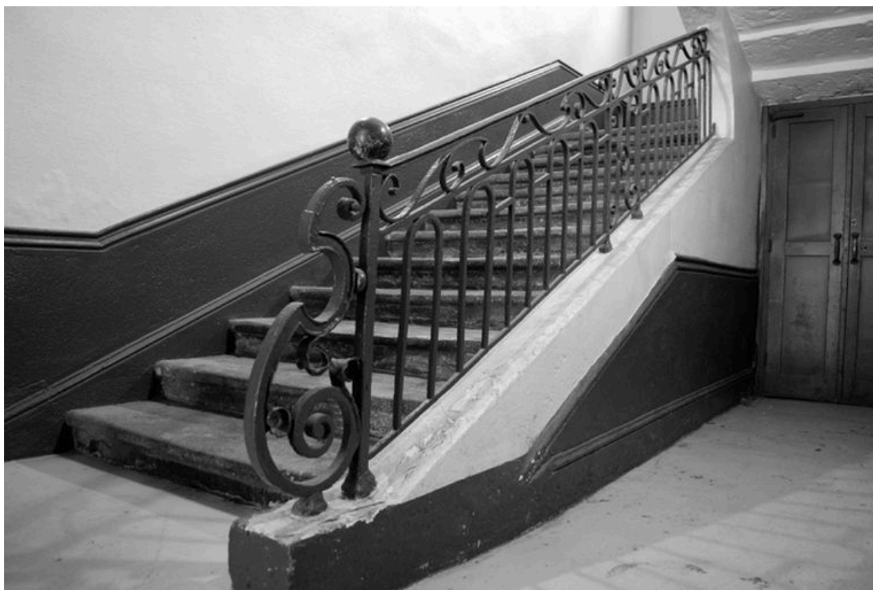
Vue de la première volée de l'escalier
