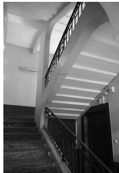
Escalier, vue depuis le rez-de-chaussée. Phot. Catherine Guégan IVR82_20096900589NUC
