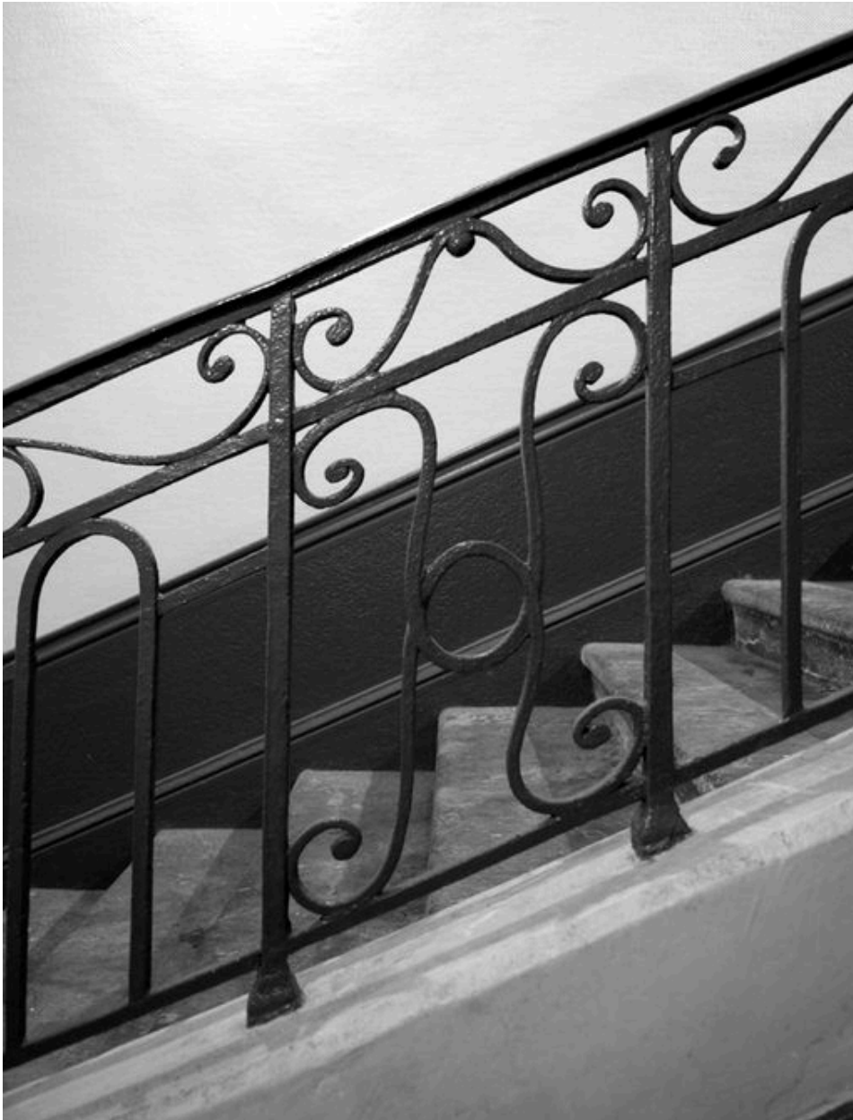
Escalier, détail de la rampe.
