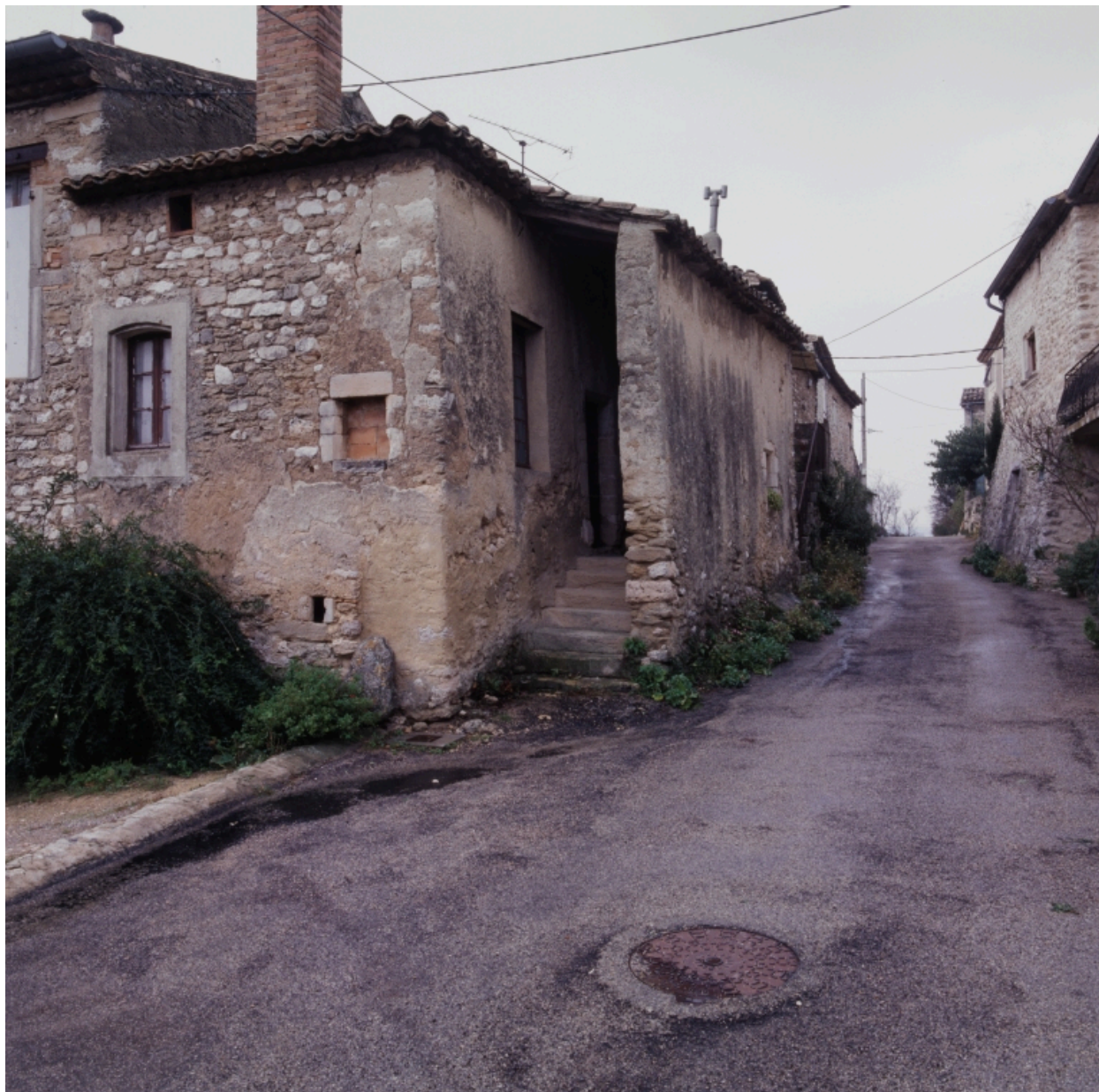
Vue partielle de la maison (F2 688). L'entrée du logis est protégée par un mur coupe-vent contre le mistral, typique de Réauville.
