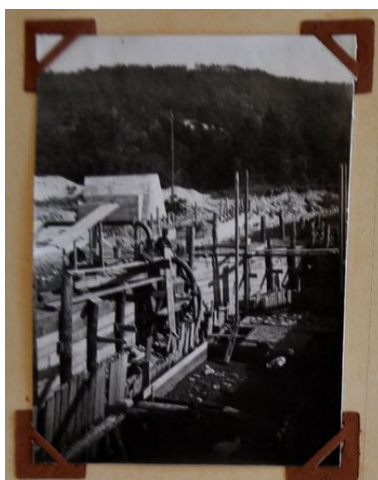
construction de la pile centrale du barrage. Photo. Archives départementales de la Haute- Savoie © Archives départementales de la Haute-Savoie. 7 S 43 Phot. Samir Mahfoudi, Autr. Société des Forces du Fier IVR82_20107400460NUCA
