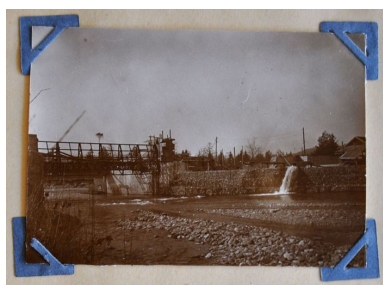
autre vue de la construction du barrage. Photo. Archives départementales de la Haute-Savoie © Archives départementales de la Haute-Savoie. 7 S 43 Phot. Samir Mahfoudi, Autr. Société des Forces du Fier IVR82_20107400462NUCA
