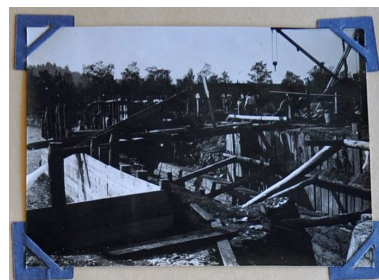
construction du barrage. Photo. Archives départementales de la Haute-Savoie © Archives départementales de la Haute-Savoie. 7 S 43 Phot. Samir Mahfoudi, Autr. Société des Forces du Fier IVR82_20107400458NUCA
