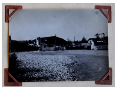
construction du barrage. Photo. Archives départementales de la Haute-Savoie © Archives départementales de la Haute-Savoie. 7 S 43 Phot. Samir Mahfoudi, Autr. Société des Forces du Fier IVR82_20107400459NUCA
