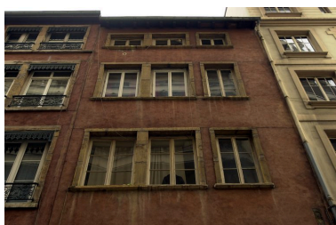
Elévation antérieure : partie supérieure Phot. Véronique Belle IVR82_20076901218NUCA
