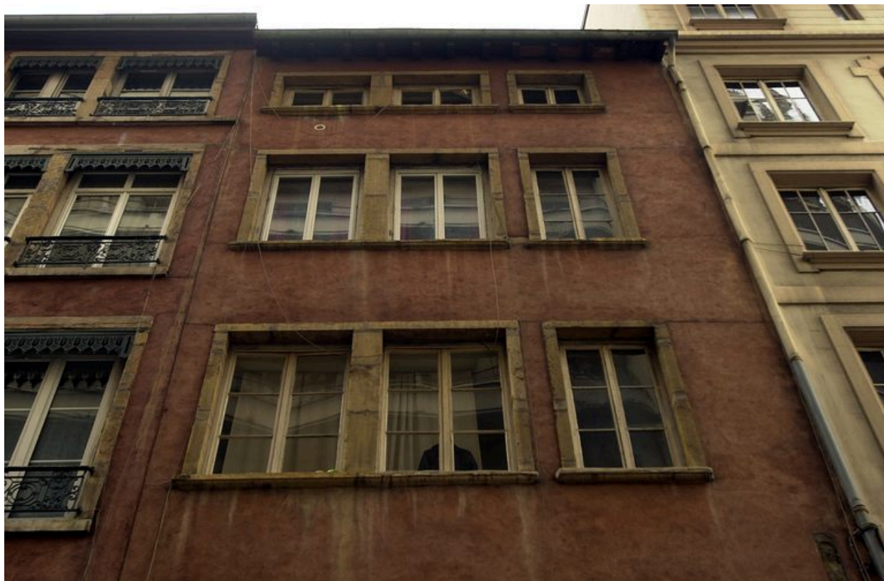
Élévation antérieure : partie supérieure
