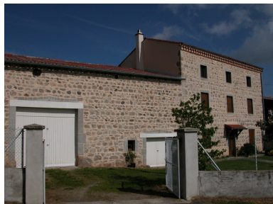
Vue générale. Phot. Thierry Monnet IVR82_20124200244NUCA
