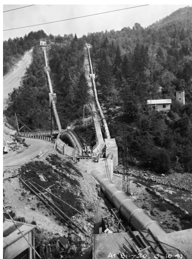
Montage sur le site des conduites forcées soudées à l'arc. octobre 1949 Phot. Samir Mahfoudi, Autr. Electricité de France IVR82_20117401173NUCA
