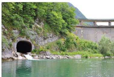
Vue de la galerie de dérivation Phot. Samir Mahfoudi, Autr. Samir Mahfoudi IVR82_20117401199NUCA
