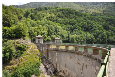
Vue de la crête du barrage du Jotty Phot. Samir Mahfoudi, Autr. Samir Mahfoudi IVR82_20117401200NUCA
