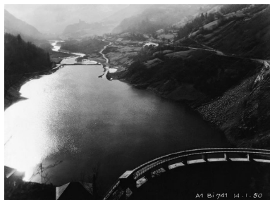
Le barrage mis en eau, janvier 1950 Phot. Samir Mahfoudi, Autr. Electricité de France IVR82_20117401182NUCA
