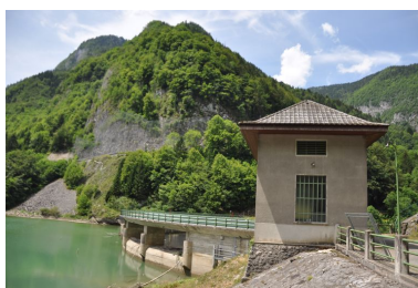
Bâtiment des vannes Phot. Samir Mahfoudi, Autr. Samir Mahfoudi IVR82_20117401202NUCA
