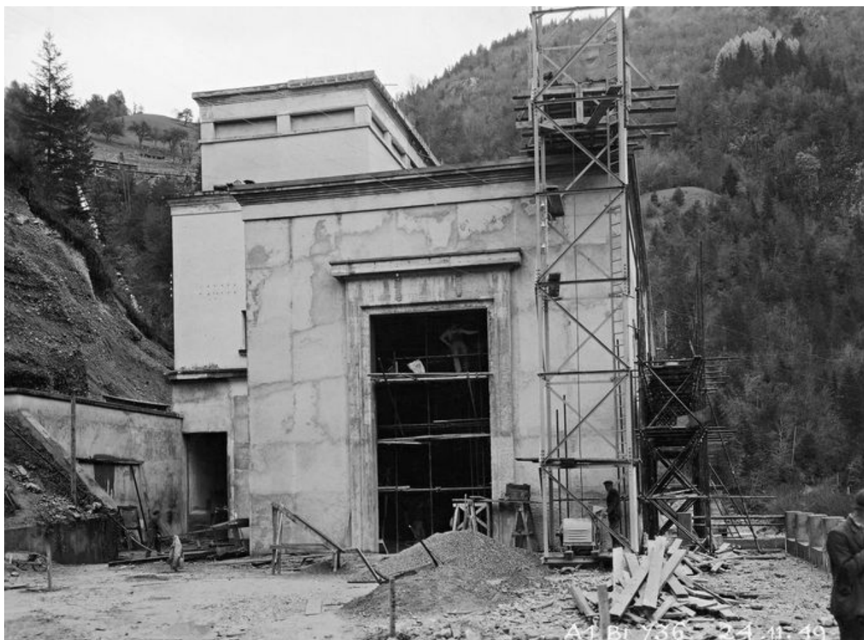
Extension de la centrale hydroélectrique de Bioge. novembre 1949
