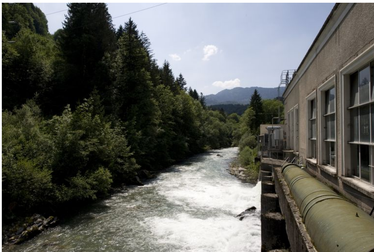
Vue de la façade postérieure donnant sur la Dranse
