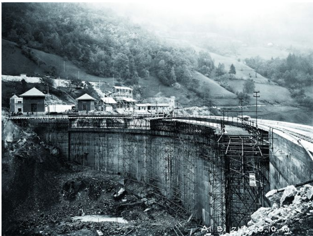
Construction du barrage voûte du Jotty, octobre 1949
