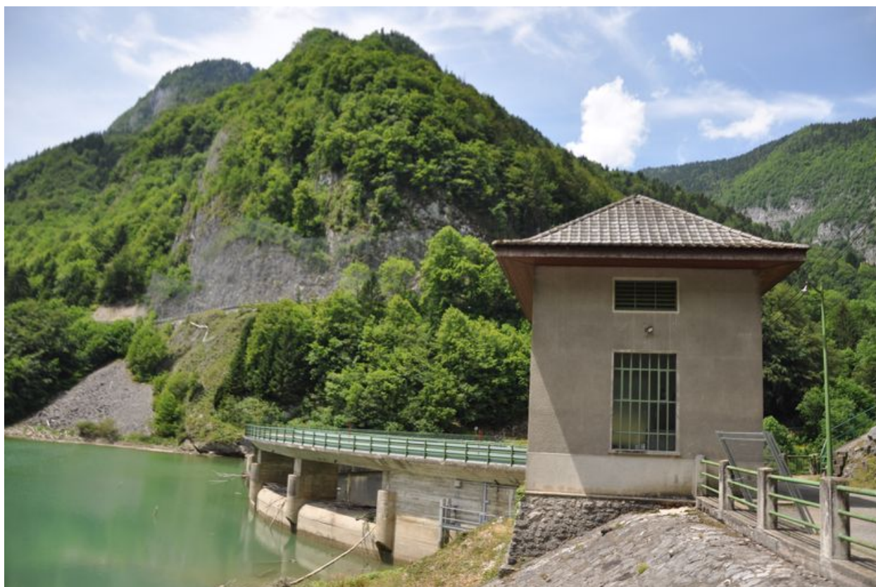
Bâtiment des vannes
