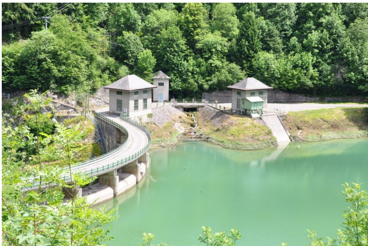
Autre vue du barrage sur la Dranse d'Abondance
