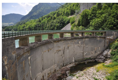
Vue de la crête du barrage du Jotty Phot. Samir Mahfoudi, Autr. Samir Mahfoudi IVR82_20117401201NUCA
