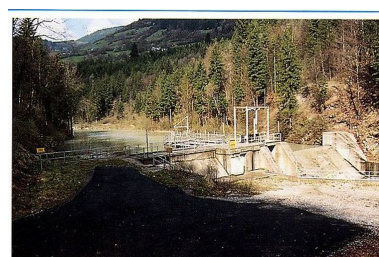
Prise d'eau du Brevon, 1982 Phot. Samir Mahfoudi, Autr. Electricité de France IVR82_20117401188NUCA
