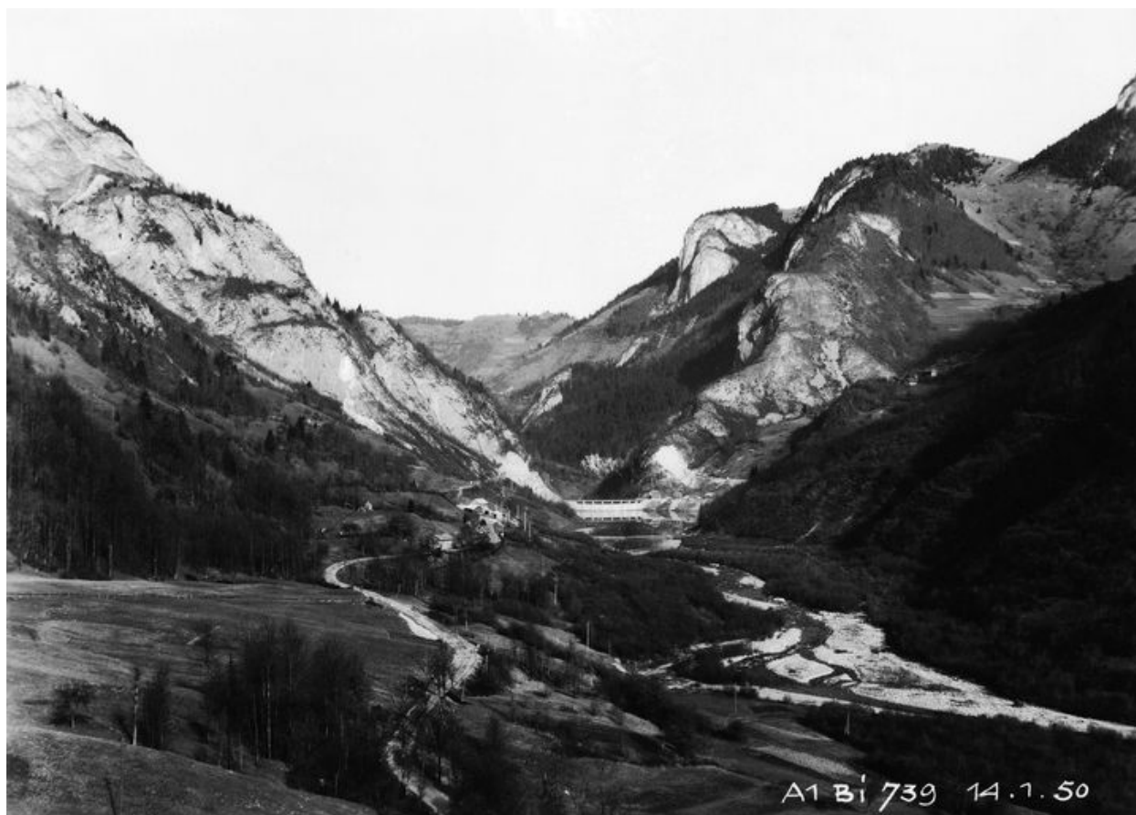
Vue de la Dranse de Morzine en aval du chantier du barrage du Jotty. janvier 1950
