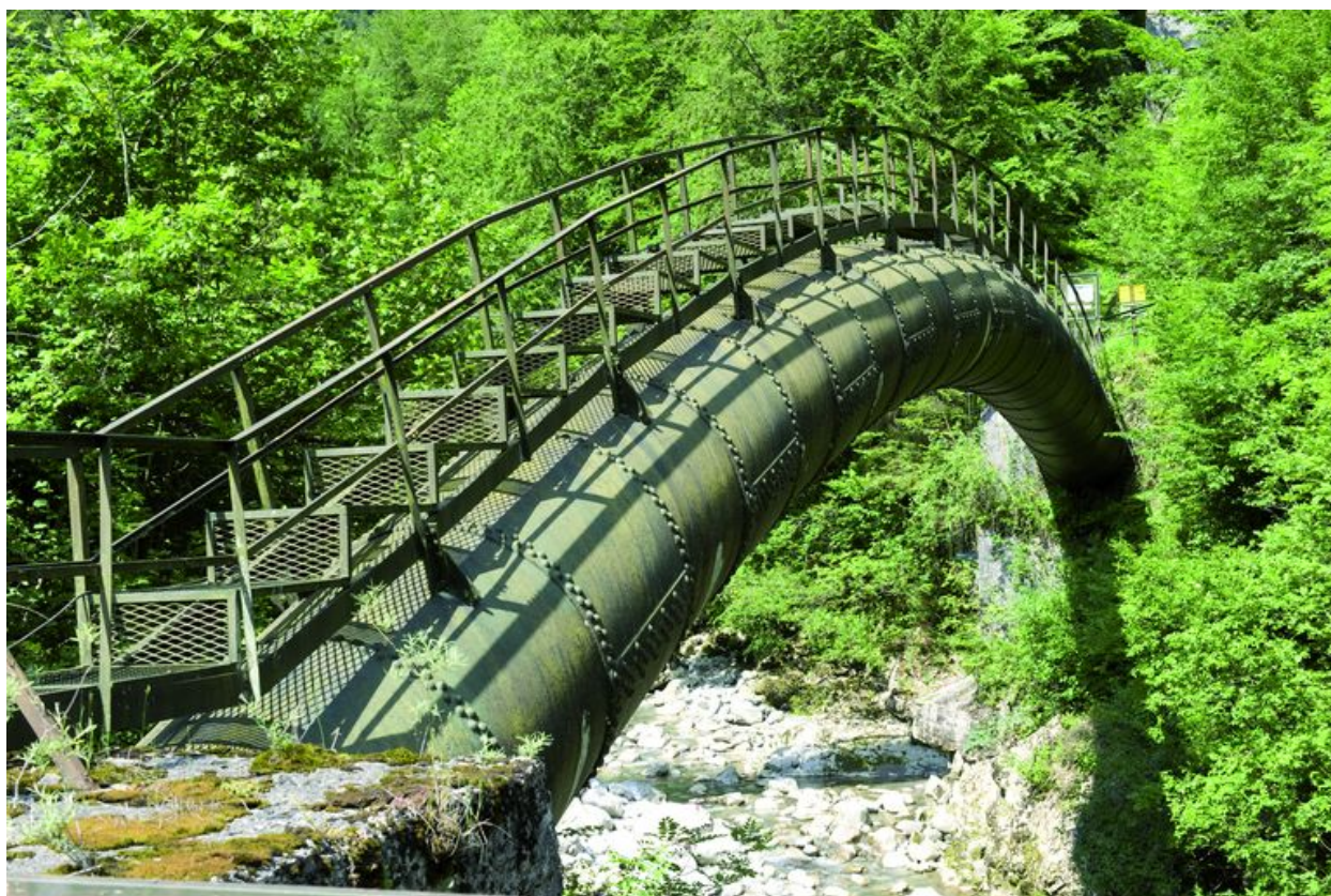
Tronçon coudé de la première conduite forcée rivetée
