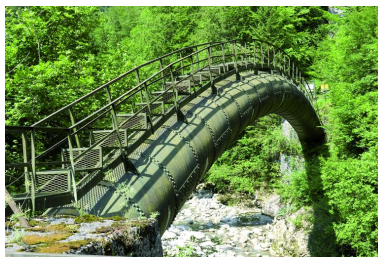
Tronçon coudé de la première conduite forcée rivetée Phot. Samir Mahfoudi, Autr. Samir Mahfoudi IVR82_20117401205NUCA
