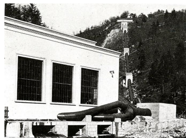
Centrale, Collecteur et Chambres de restitution, 1932 Phot. Samir Mahfoudi, Autr. Société hydro-électrique des Dranses IVR82_20117401169NUCA
