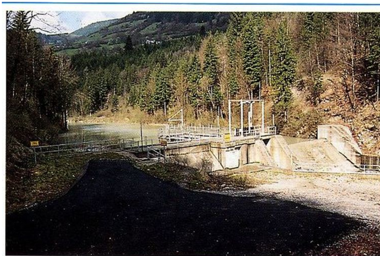
Prise d'eau du Brevon, 1982
