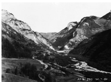
Vue de la Dranse de Morzine en aval du chantier du barrage du Jotty. janvier 1950 Phot. Samir Mahfoudi, Autr. Electricité de France IVR82_20117401177NUCA
