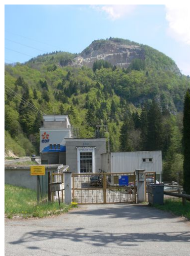
Vue d'ensemble du domaine de Bioge Phot. Samir Mahfoudi, Autr. Samir Mahfoudi IVR82_20117401203NUCA
