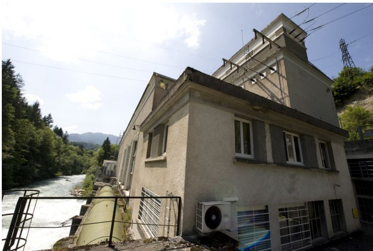
Elévation sud-est de la centrale hydroélectrique de Bioge
