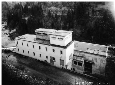
Vue d'ensemble de l'usine, novembre 1949 Phot. Samir Mahfoudi, Autr. Electricité de France IVR82_20117401180NUCA
