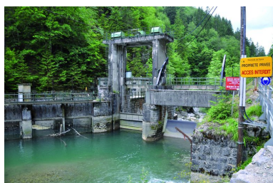
Barrage sur la Dranse d'Abondance Phot. Samir Mahfoudi, Autr. Samir Mahfoudi IVR82_20117401196NUCA
