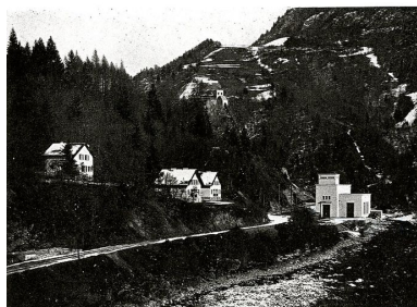
L'usine et les maisons ouvrières, 1932 Phot. Samir Mahfoudi, Autr. Société hydro-électrique des Dranses IVR82_20117401170NUCA
