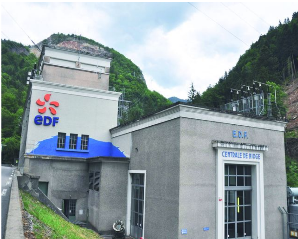
Elévation nord-ouest de la centrale hydroélectrique de Bioge
