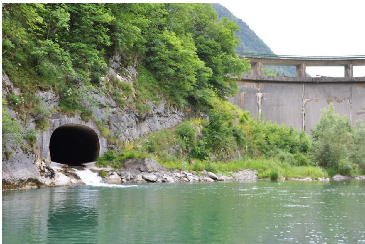
Vue de la galerie de dérivation
