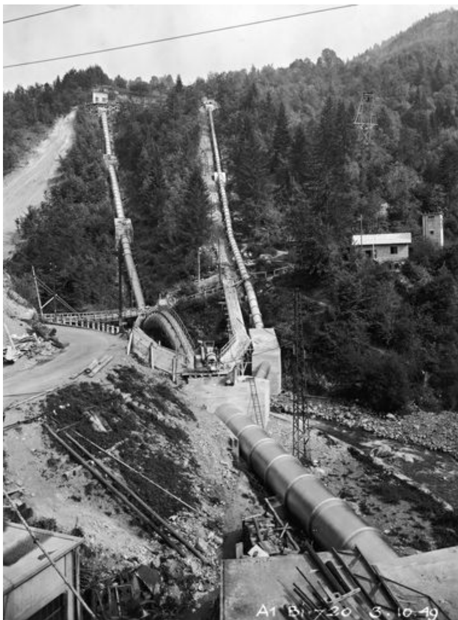
Montage sur le site des conduites forcées soudées à l'arc. octobre 1949
