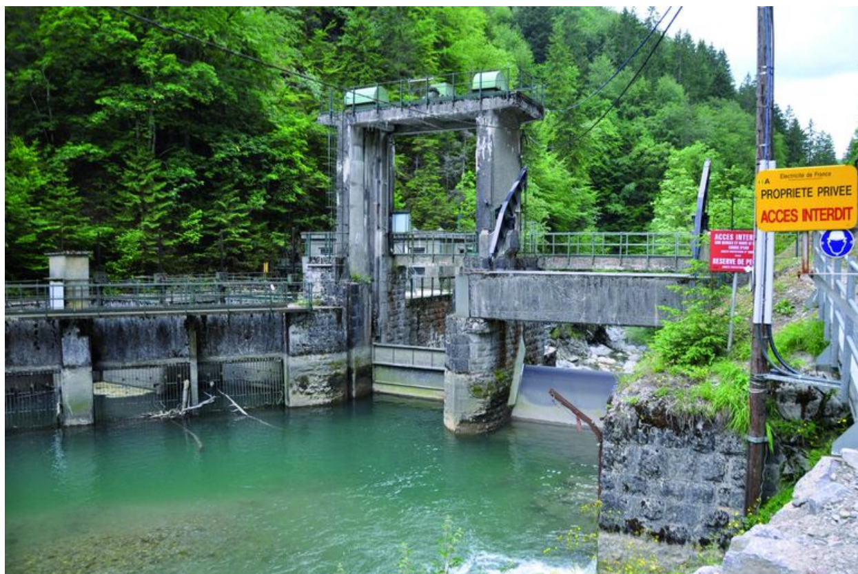
Barrage sur la Dranse d'Abondance
