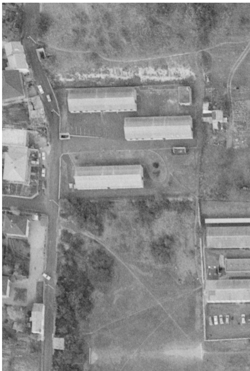
Vue aérienne des trois bâtiments d'habitation et de la chaufferie en 1981.
