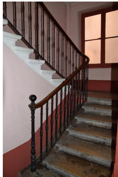
Départ escalier Phot. Noémie Caillat IVR82_20156900272NUCA
