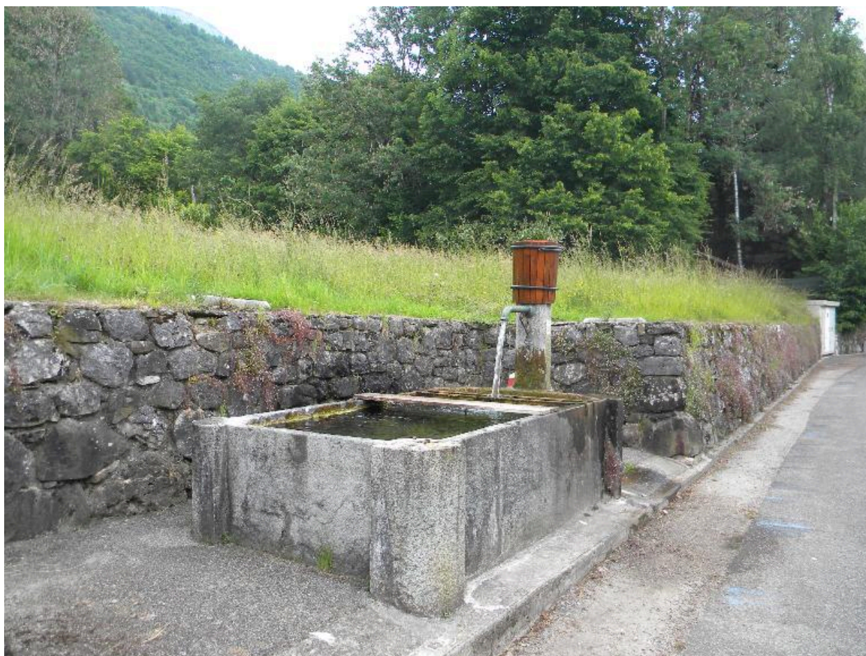
Vue d'ensemble du bassin nord de la route de Marceau.
