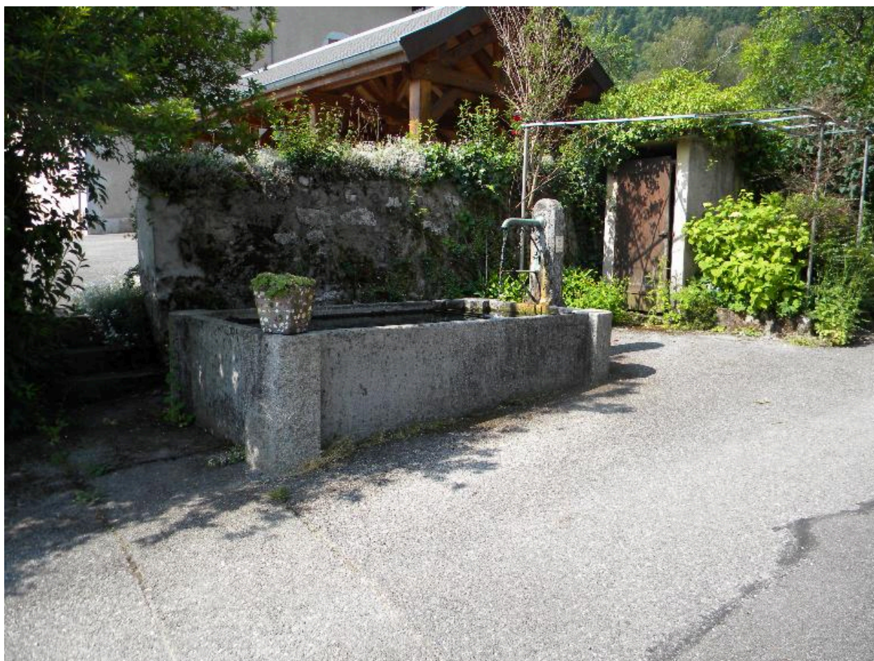
Vue d'ensemble du bassin route de la fruitière.
