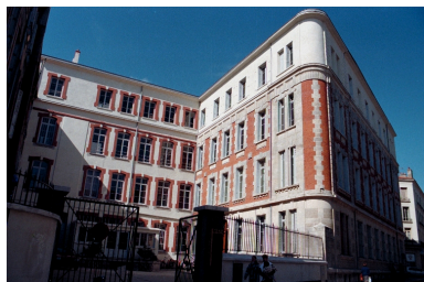
Façade principale Phot. Cendrine Sanquer IVR82_19974201898ZE
