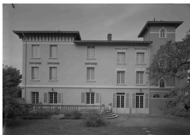
Façade sur jardin. Phot. Eric Dessert IVR82_19920100501P
