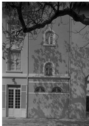
Détail de la tour d'escalier. Phot. Eric Dessert IVR82_19920100502P
