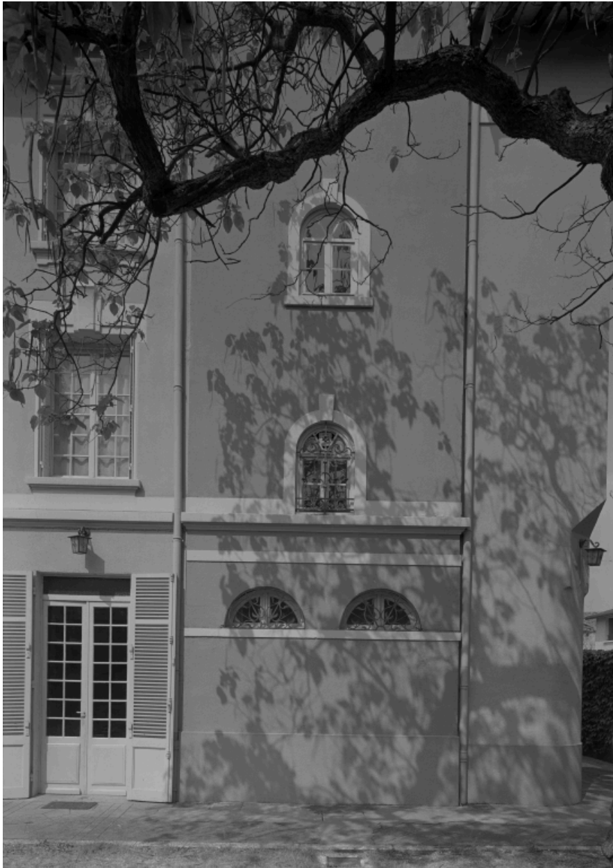
Détail de la tour d'escalier.
