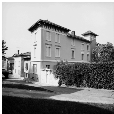
Vue générale, prise depuis la rue. Phot. Jean-Marie Refflé IVR82_19870100279X
