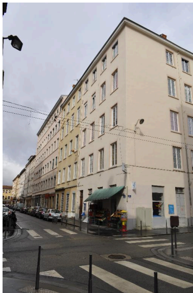
Vue d'ensemble du n°13 rue Dumenge avec immeuble mitoyen n°15 depuis l'est Phot. Nadine Halitim-Dubois IVR82_20136900403NUCA
