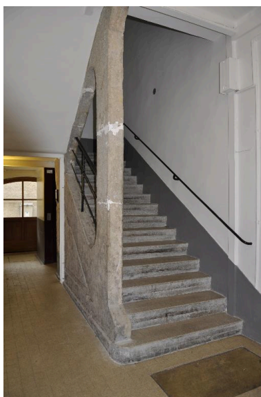
Vue de l'escalier et de l'ascenseur depuis l'allée du n°13 rue Dumenge Phot. Nadine Halitim-Dubois IVR82_20136900437NUCA
