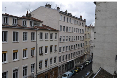
Vue d'ensemble du n°13 rue Dumenge depuis l'ouest Phot. Nadine Halitim-Dubois IVR82_20136900410NUCA
