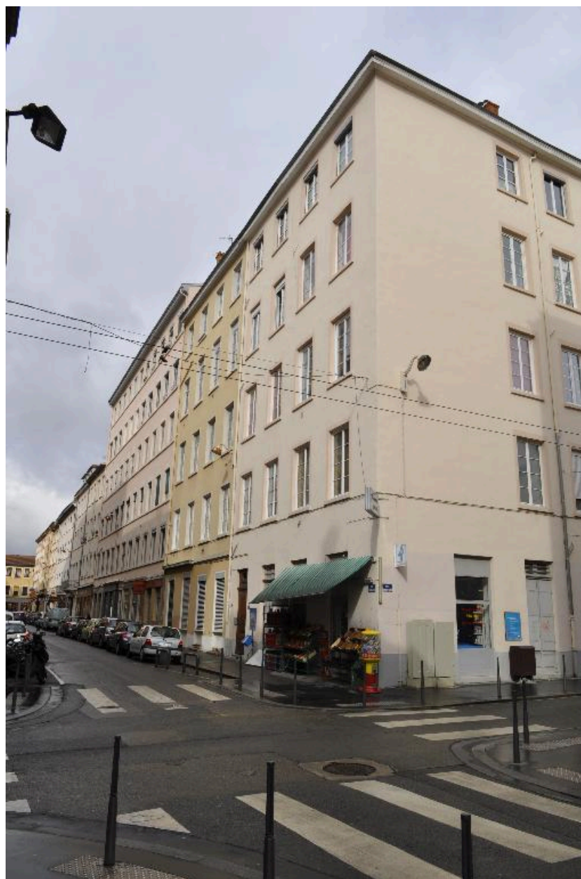
Vue d'ensemble du n°13 rue Dumenge avec immeuble mitoyen n°15 depuis l'est
