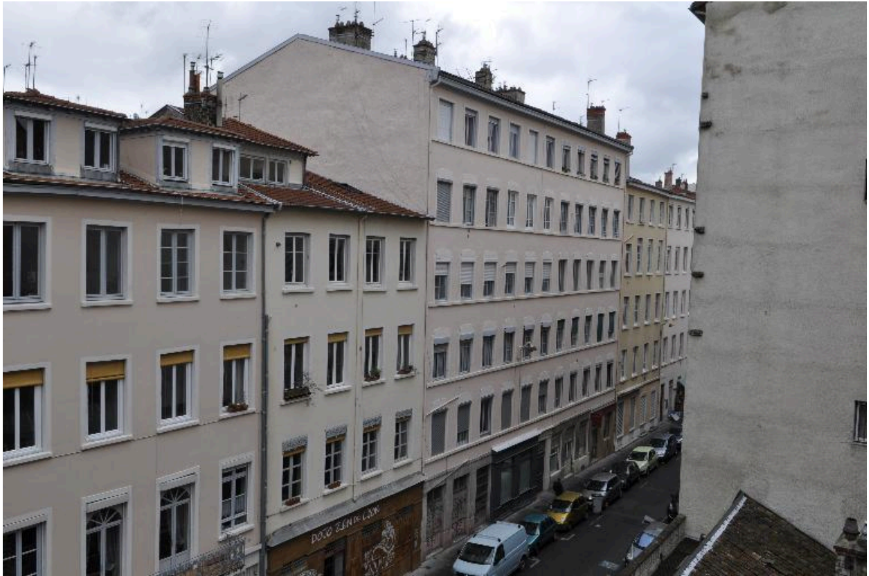
Vue d'ensemble du n°13 rue Dumenge depuis l'ouest
