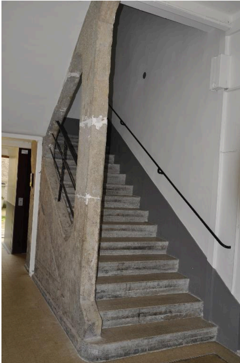
Départ de l'escalier de l'immeuble n°13 rue Dumenge
