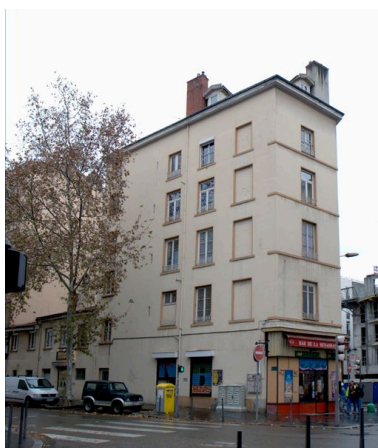
Elévation postérieure Phot. Maryannick Chalabi IVR82_20116901757NUCA
