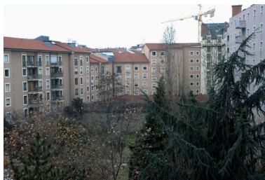
Elévations postérieures depuis le nord-ouest Phot. Maryannick Chalabi IVR82_20086900751NUCA
