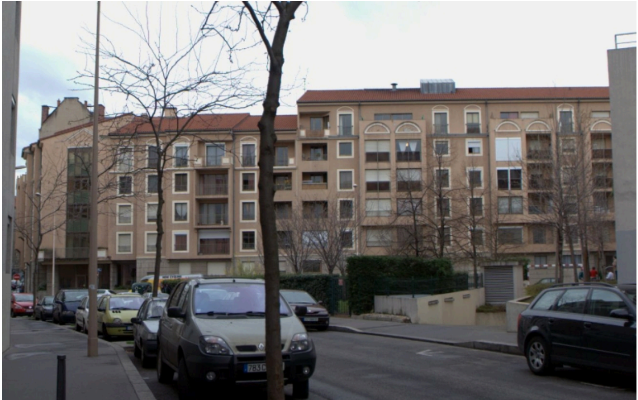
Vue générale depuis l'est
