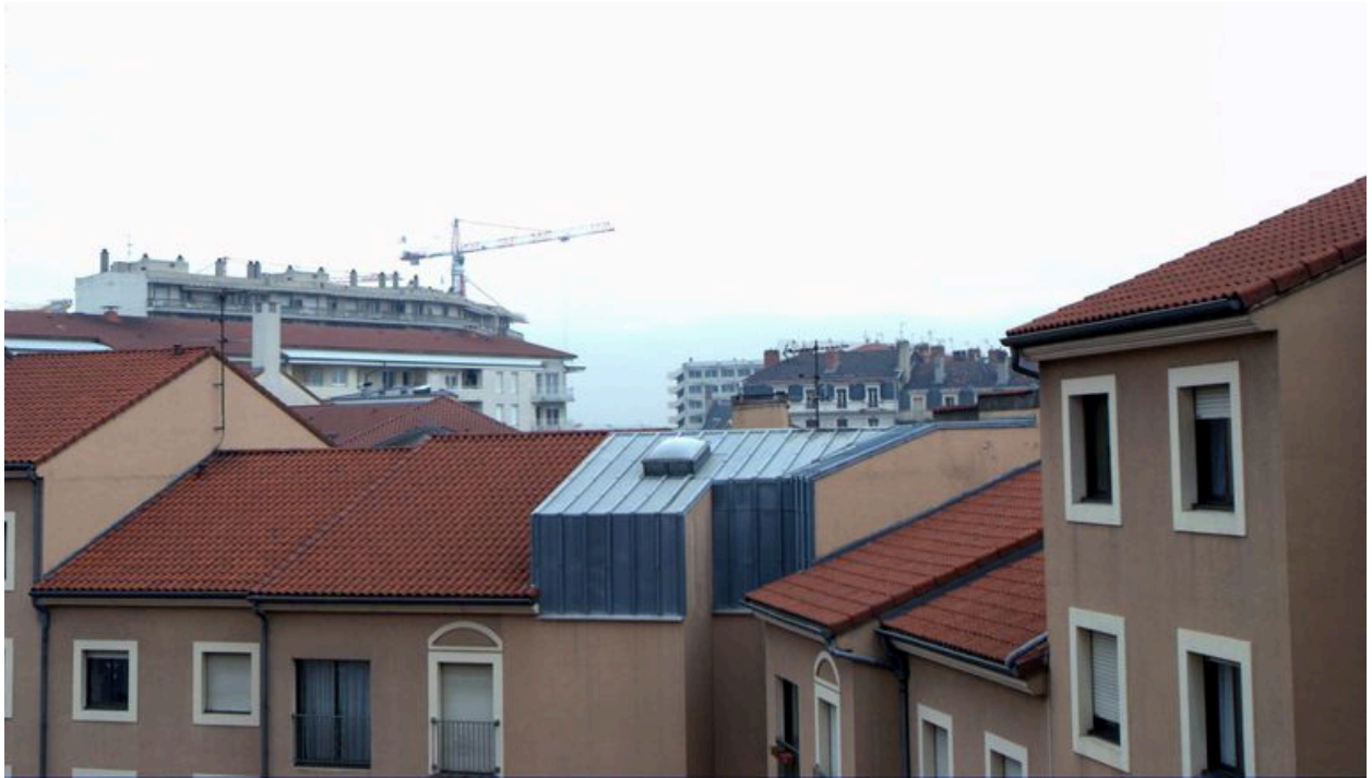
Détail des toitures depuis l'ouest
