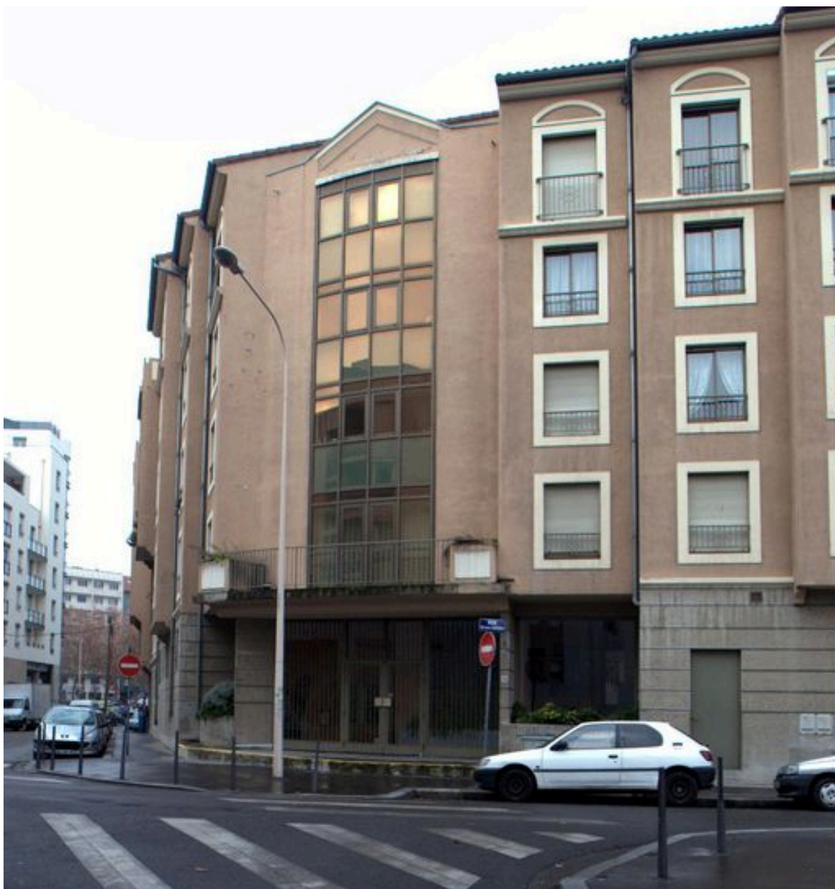
Vue générale de l'entrée, à l'angle des rues Victorien-Sardou (n° 14) et de l'Abbé-Boisard
