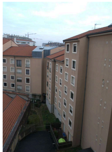
Elévation postérieure du corps de bâtiment 13 rue de l'Abbé- Boisard, depuis le nord-ouest Phot. Maryannick Chalabi IVR82_20086900752NUCA
