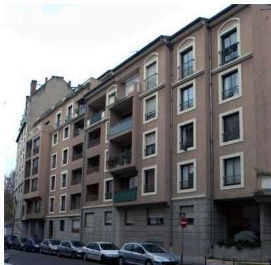
Elévation rue de l'Abbé- Boisard depuis l'est Phot. Maryannick Chalabi IVR82_20086900750NUCA
