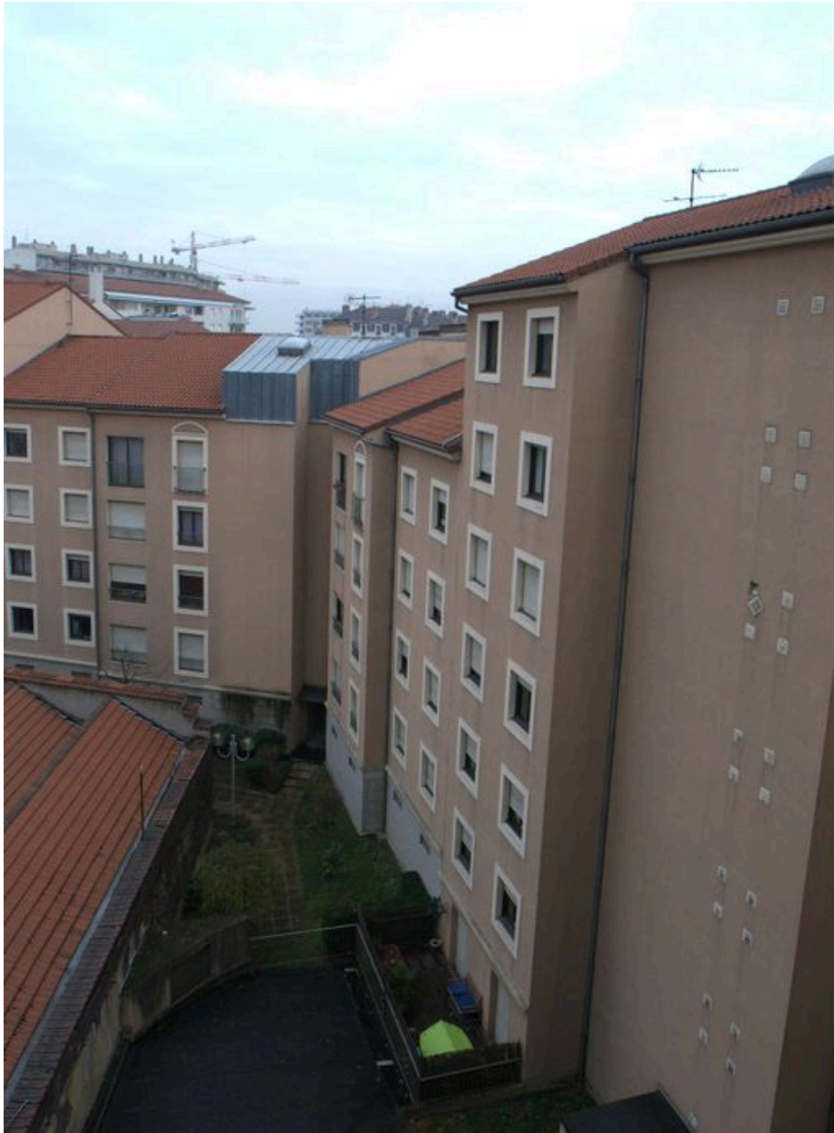
Elévation postérieure du corps de bâtiment 13 rue de l'Abbé-Boisard, depuis le nord-ouest
