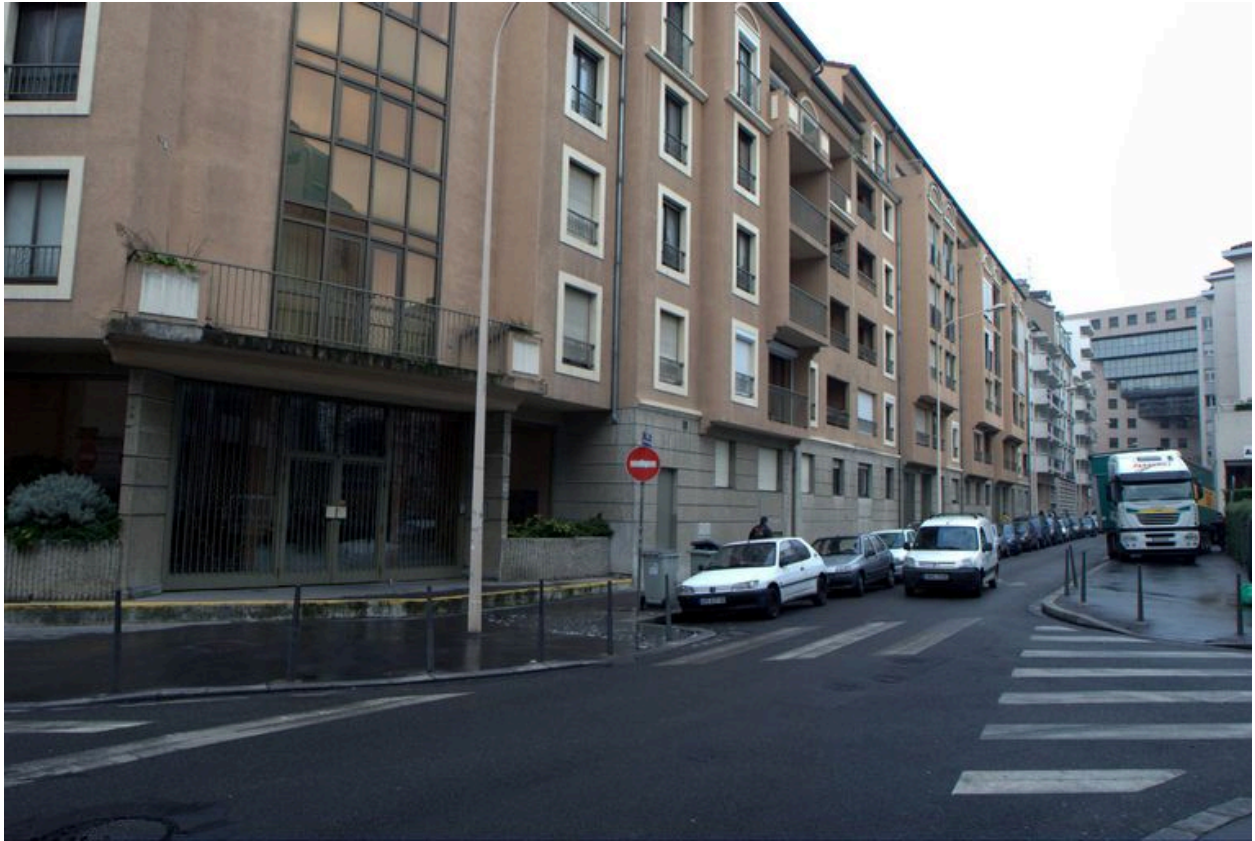
Elévation rue Victorien-Sardou depuis le sud
