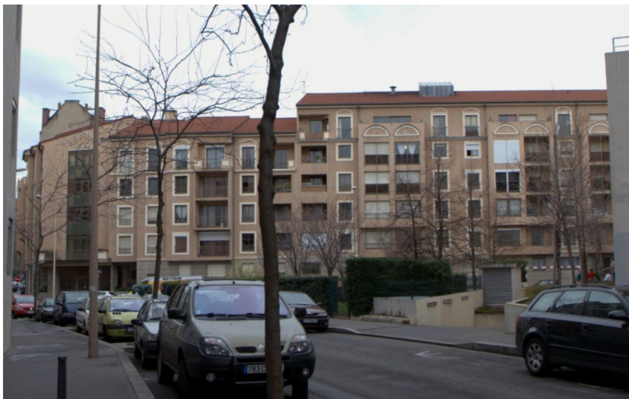
Vue générale depuis l'est
