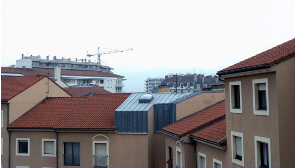
Détail des toitures depuis l'ouest
