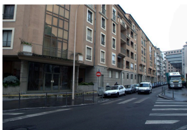
Elévation rue Victorien-Sardou depuis le sud Phot. Maryannick Chalabi IVR82_20086900749NUCA
