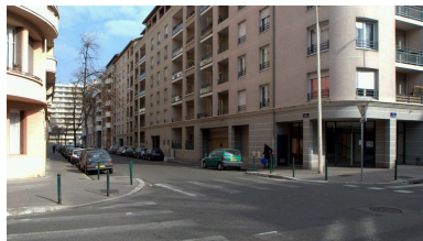
Vue de la rue Nicolai, côté est, depuis le sud-ouest Phot. Maryannick Chalabi IVR82_20116905138NUCA
