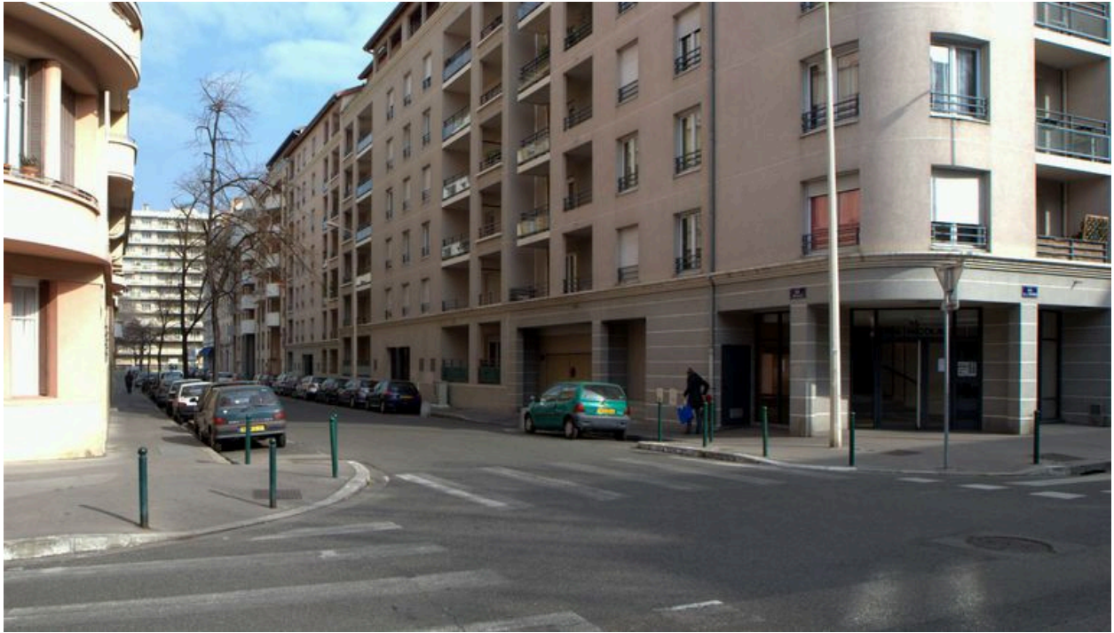
Vue de la rue Nicolai, côté est, depuis le sud-ouest
