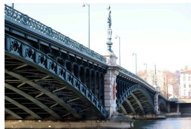
Vue partielle, de côté, face amont (depuis la rive gauche) Phot. G. Gellert IVR82_20106907266NUCA
