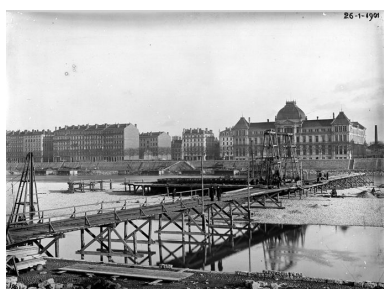
[La construction de la passerelle provisoire]. [26/01/1901]. 1 photogr. nég. (sur verre) : n. et b. (AM Lyon. 15 Ph 1/697) Phot. AM Lyon IVR82_20106902506NUCAB
