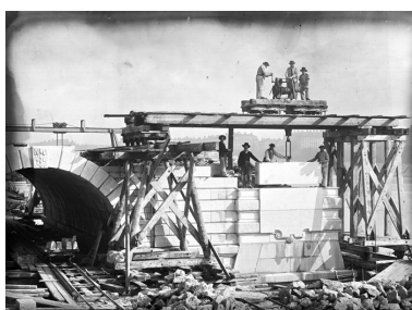
[La construction de l'arche de rive en maçonnerie et de la pile adjacente]. [1901]. 1 fotogr. nég. (sur verre) : n. et b. (AM Lyon. 15 Ph 1/731)
