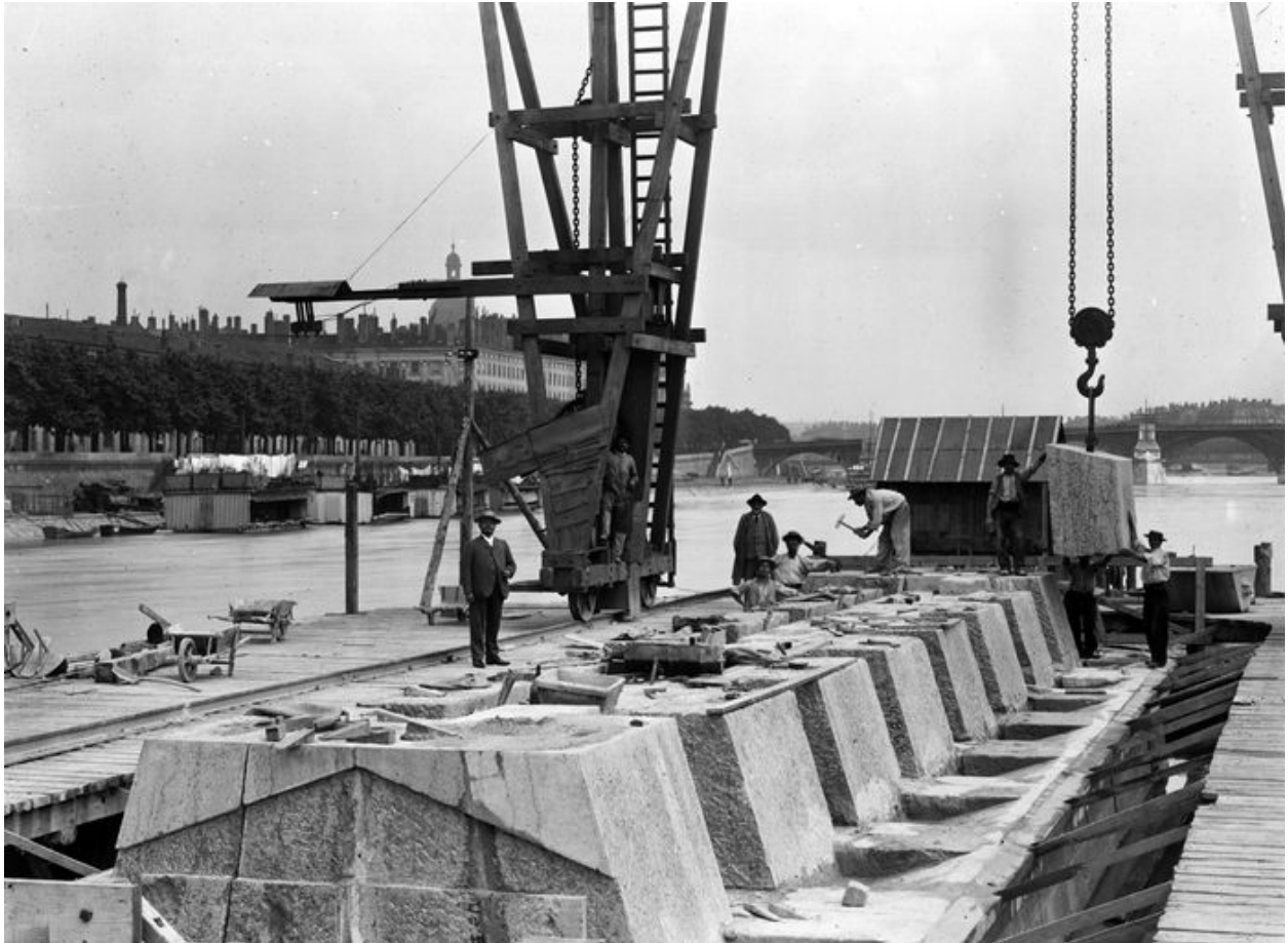
[La construction d'une pile en maçonnerie]. [1901]. 1 fotogr. nég. (sur verre) : n. et b. (AM Lyon. 15 Ph 1/713)
