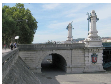
Travée et pile de rive, face amont, vue générale (depuis la rive gauche)
