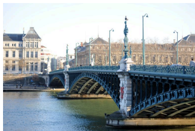
Vue partielle, de côté, face amont (depuis la rive droite) Phot. G. Gellert IVR82_20106907261NUCA
