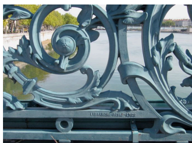
Balustrade, face amont, vue de détail : inscription, nom du sculpteur (depuis la chaussée)
