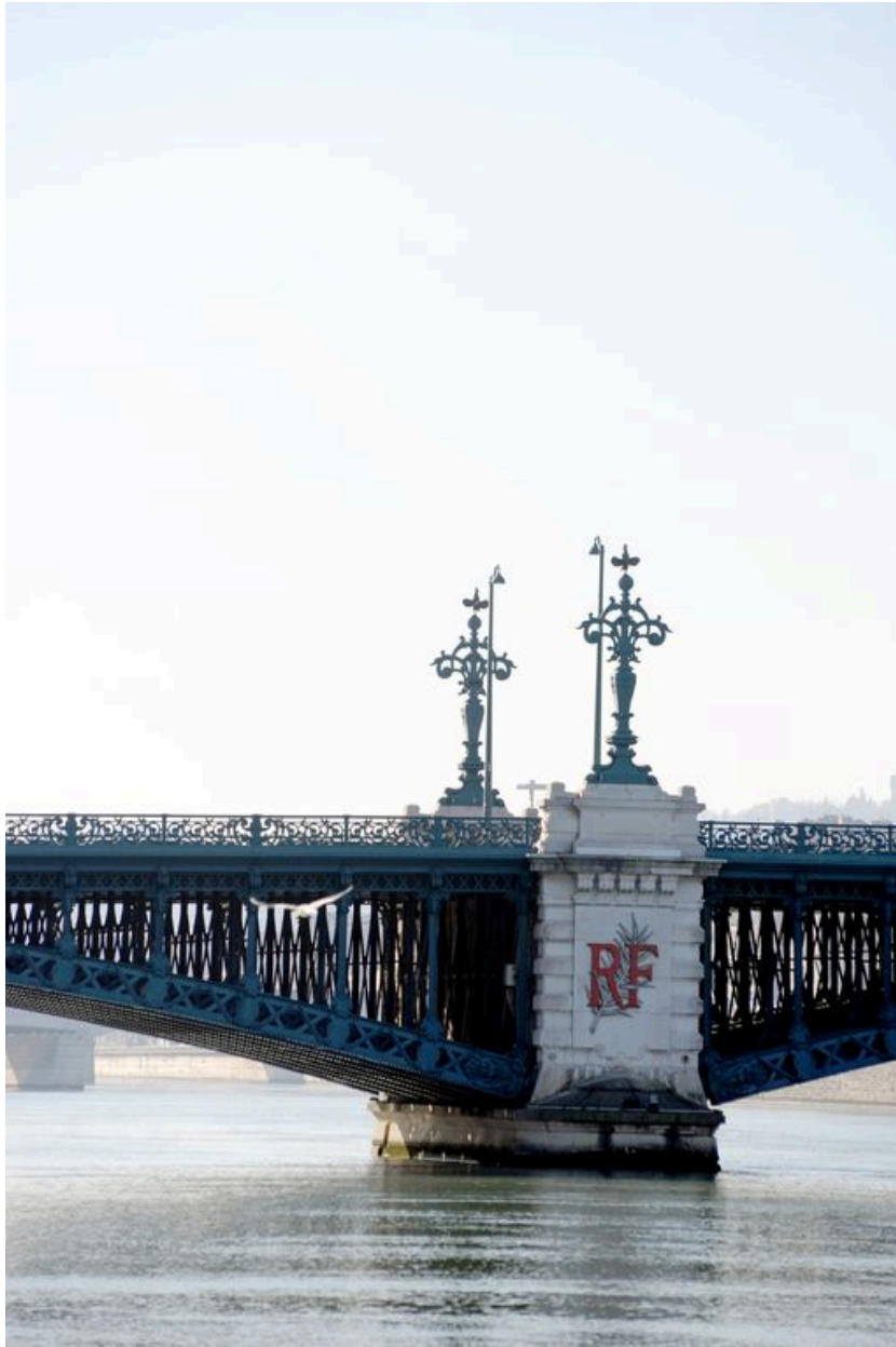
Pile, face amont, vue générale (depuis la rive gauche)
