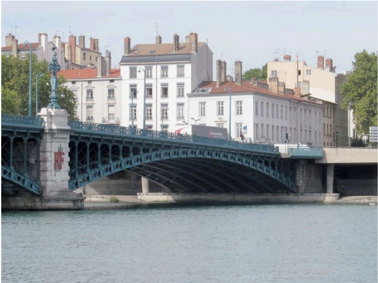
Vue partielle, travée droite, face amont (depuis la rive gauche)
