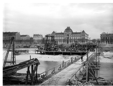
[La construction de la passerelle provisoire]. [14/03/1901]. 1 photogr. nég. (sur verre) : n. et b. (AM Lyon. 15 Ph 1/701) Phot. AM Lyon IVR82_20106902508NUCAB
