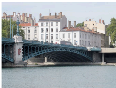
Vue partielle, travée droite, face amont (depuis la rive gauche) Phot. I. Havard IVR82_20106907264NUCA
