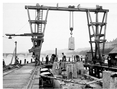
[La construction d'une pile]. [1901]. 1 fotogr. nég. (sur verre) : n. et b. (AM Lyon. 15 Ph 1/716) Phot. AM Lyon IVR82_20106902510NUCAB
