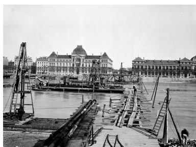
[La construction de la passerelle provisoire]. [1901]. 1 fotogr. nég. (sur verre) : n. et b. (AM Lyon. 15 Ph 1/708) Phot. AM Lyon IVR82_20106902509NUCAB
