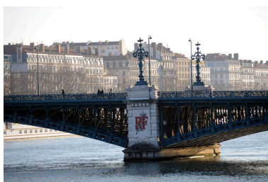
Pile, face amont, vue générale (depuis la rive droite) Phot. G. Gellert IVR82_20106907268NUCA
