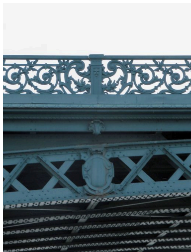
Arche, face amont, vue de détail : décors de la partie centrale et balustrade (depuis la rive gauche)
