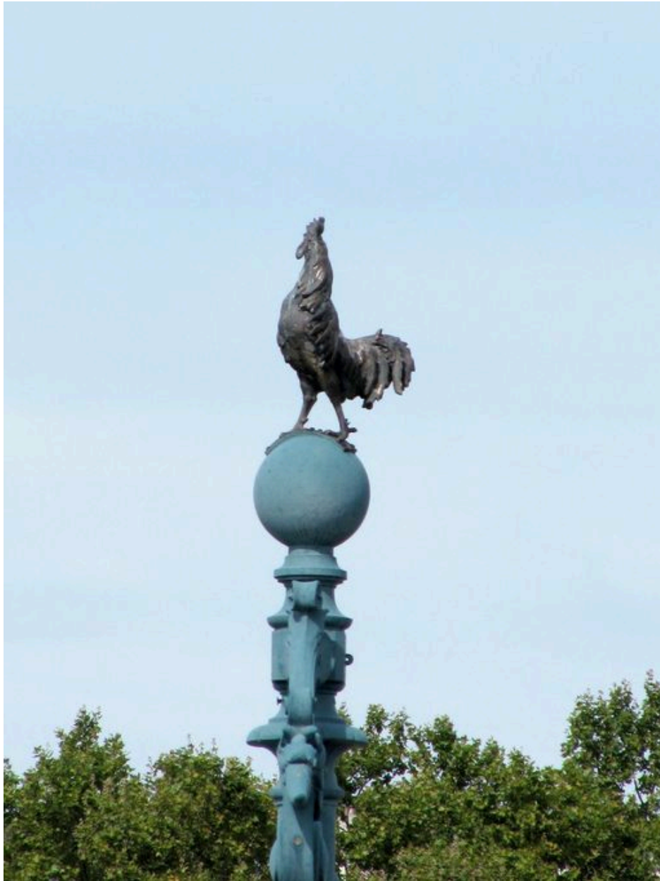
Pile, vue de détail : sommet du décor au-dessus du tablier, coq (depuis la chaussée)
