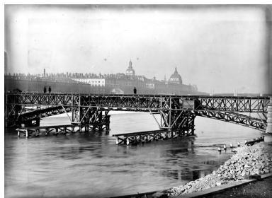
[La construction de l'arche latérale en métal]. [1901]. 1 photogr. nég. (sur verre) : n. et b. (AM Lyon. 15 Ph 1/734)
