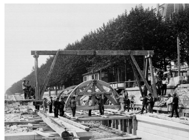
[La construction du cintre de l'arche de rive]. [1901]. 1 fotogr. nég. (sur verre) : n. et b. (AM Lyon. 15 Ph 1/726) Phot. AM Lyon IVR82_20106902516NUCAB
