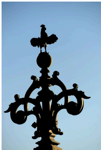
Pile, vue de détail : sommet du décor au-dessus du tablier, coq aux ailes déployées (depuis la chaussée)
