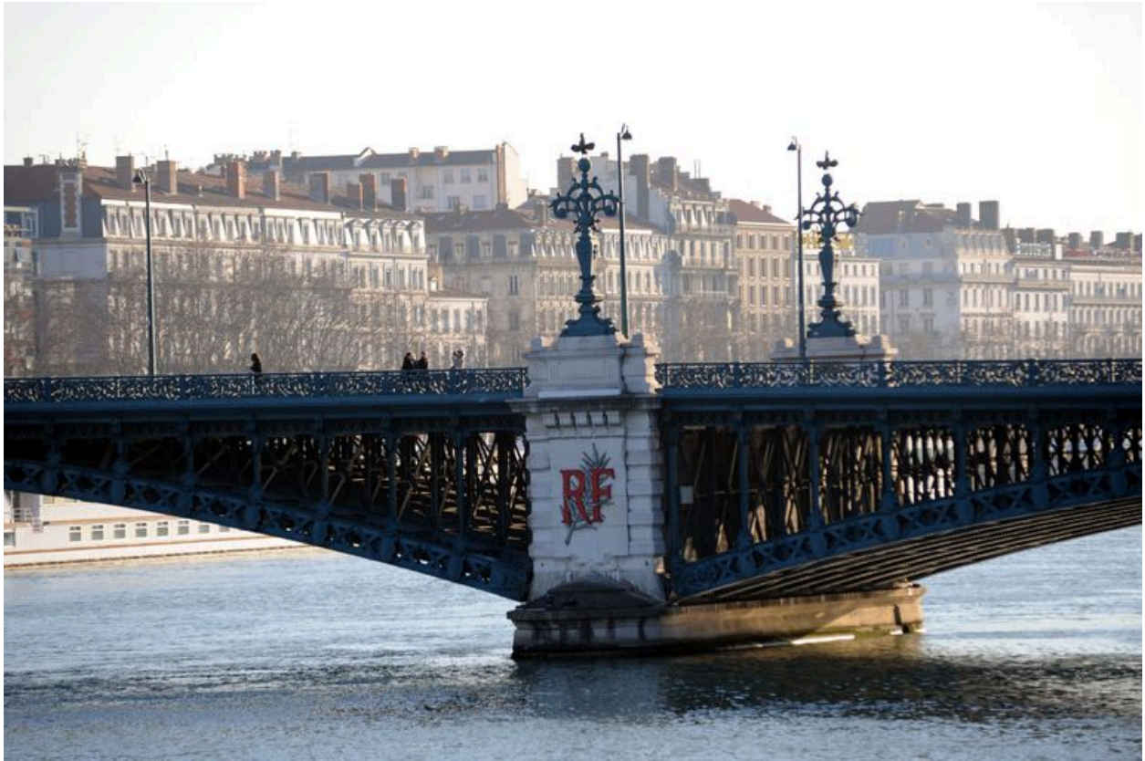
Pile, face amont, vue générale (depuis la rive droite)
