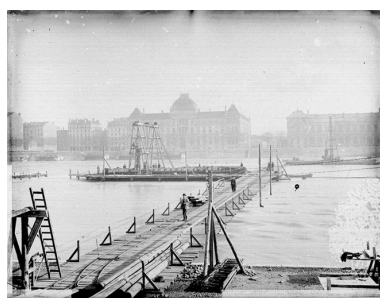
[La construction de la passerelle provisoire]. [1901]. 1 fotogr. nég. (sur verre) : n. et b. (AM Lyon. 15 Ph 1/698) Phot. AM Lyon IVR82_20106902507NUCAB
