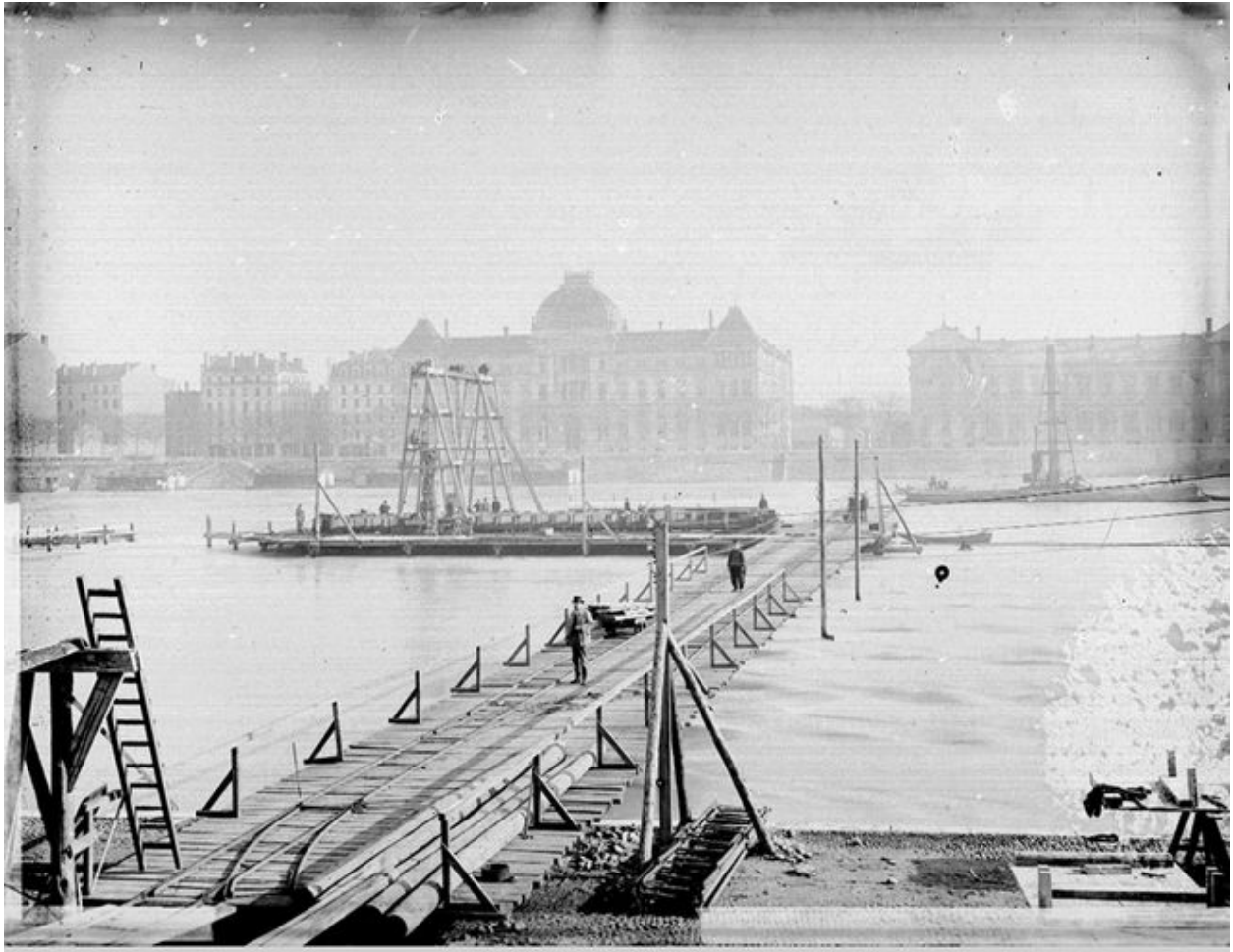
[La construction de la passerelle provisoire]. [1901]. 1 fotogr. nég. (sur verre) : n. et b. (AM Lyon. 15 Ph 1/698)
