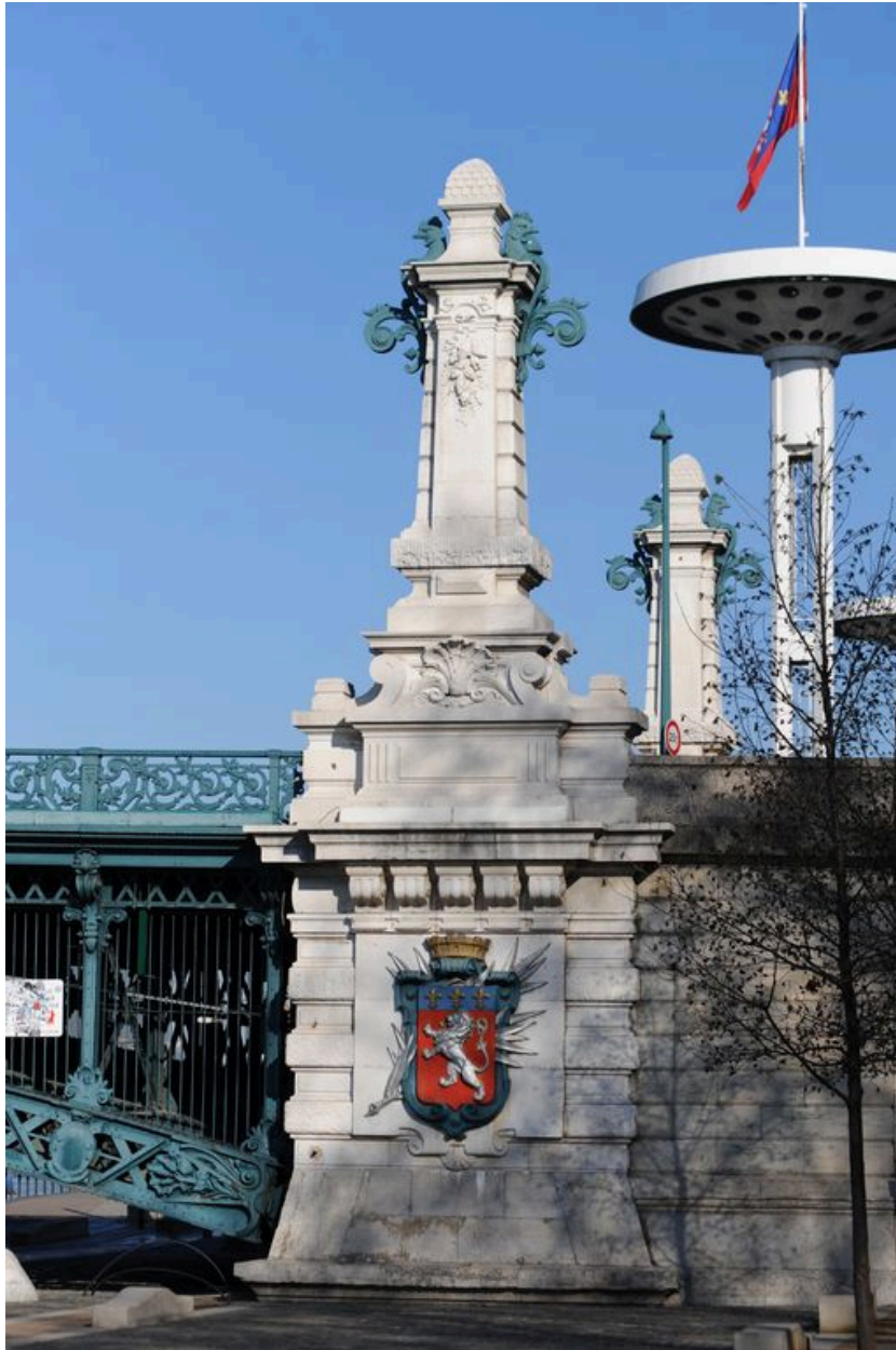
Pile de rive, face aval, vue générale (depuis la rive gauche)
