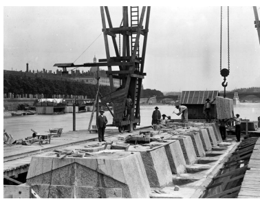
[La construction d'une pile en maçonnerie]. [1901]. 1 fotogr. nég. (sur verre) : n. et b. (AM Lyon. 15 Ph 1/713) Phot. AM Lyon IVR82_20106902505NUCAB
