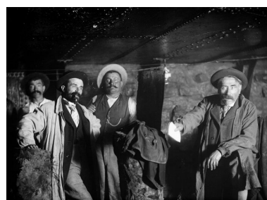
[La construction du pont. A l'intérieur du caisson pneumatique]. [1901]. 1 fotogr. nég. (sur verre) : n. et b. (AM Lyon. 15 Ph 1/722) Phot. AM Lyon IVR82_20106902513NUCAB
