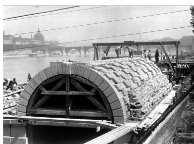
[La construction de l'arche de rive en maçonnerie]. [1901]. 1 fotogr. nég. (sur verre) : n. et b. (AM Lyon. 15 Ph 1/728)
