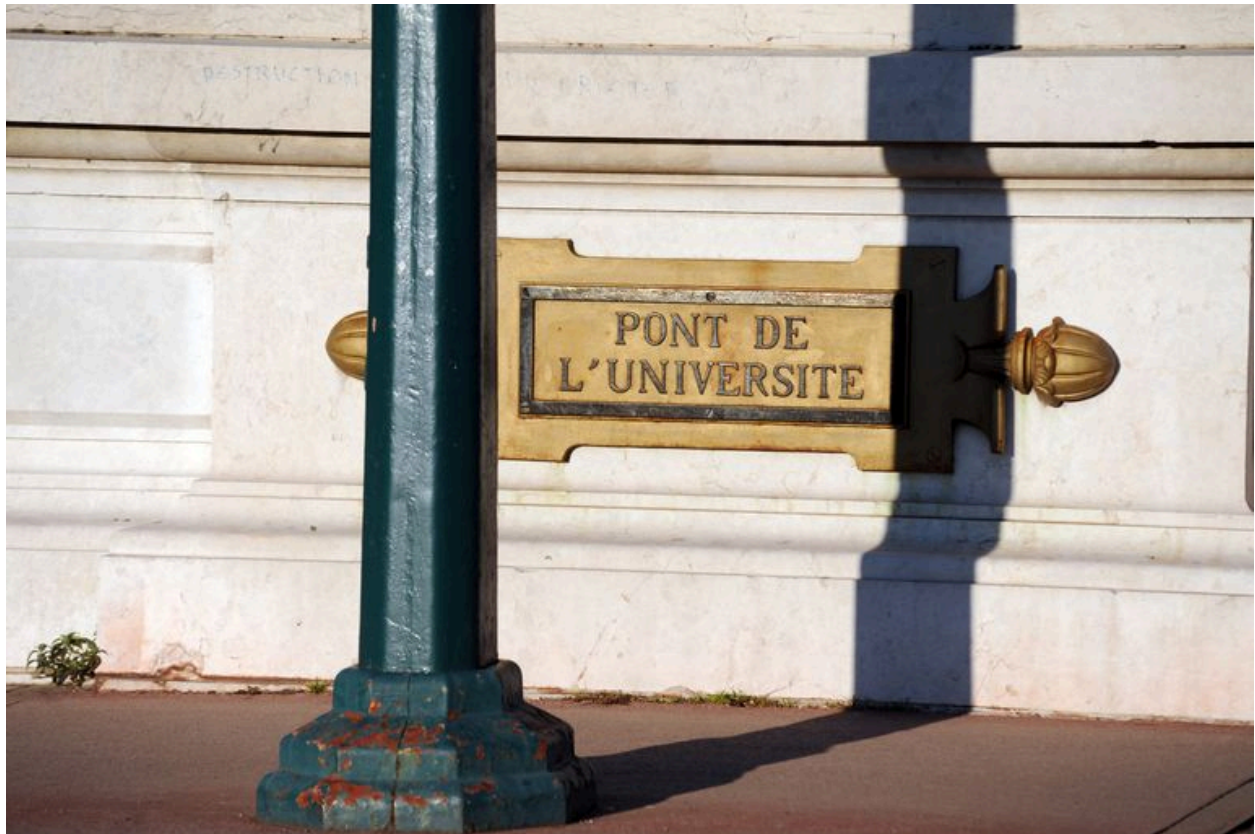
Pile, face amont, vue de détail : base du décor au-dessus du tablier, cartouche avec inscription (depuis la chaussée)
