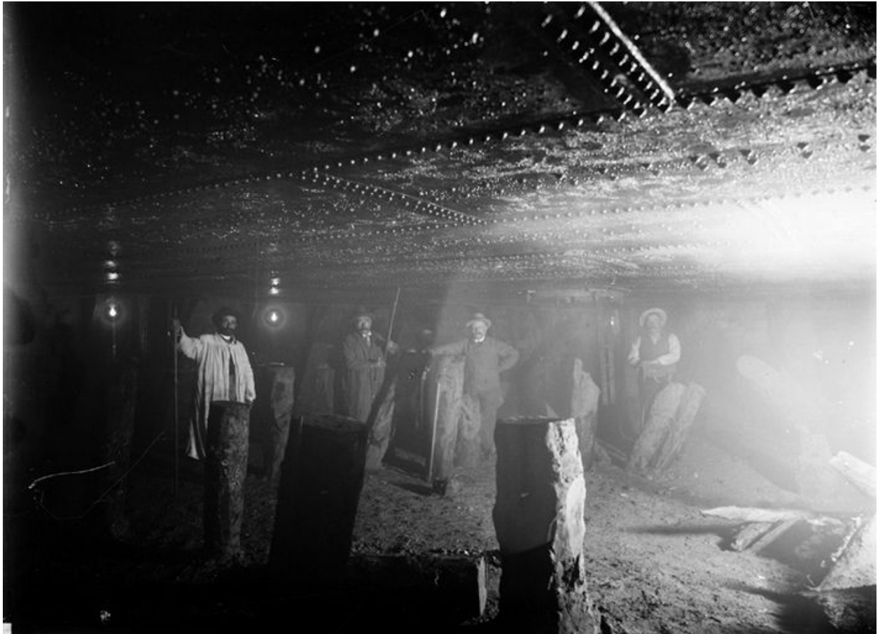
[La construction du pont. A l'intérieur du caisson pneumatique]. [1901]. 1 fotogr. nég. (sur verre) : n. et b. (AM Lyon. 15 Ph 1/721)
