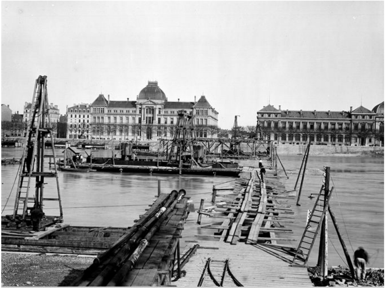
[La construction de la passerelle provisoire]. [1901]. 1 fotogr. nég. (sur verre) : n. et b. (AM Lyon. 15 Ph 1/708)
