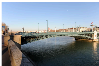
Vue partielle, travée droite, face aval (depuis la rive droite) Phot. G. Gellert IVR82_20106907263NUCA
