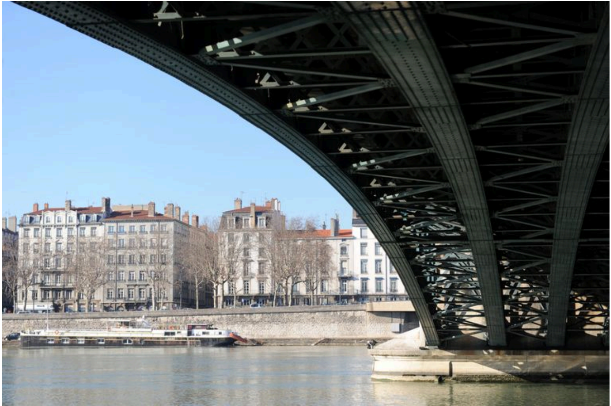
Vue partielle, de dessous, moitiés senestres de la structure de l'arche et de la pile (depuis la rive gauche)
