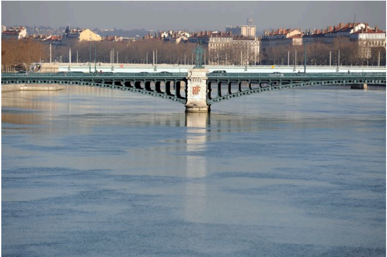
Vue partielle, pile, face aval (depuis le pont Galliéni)
