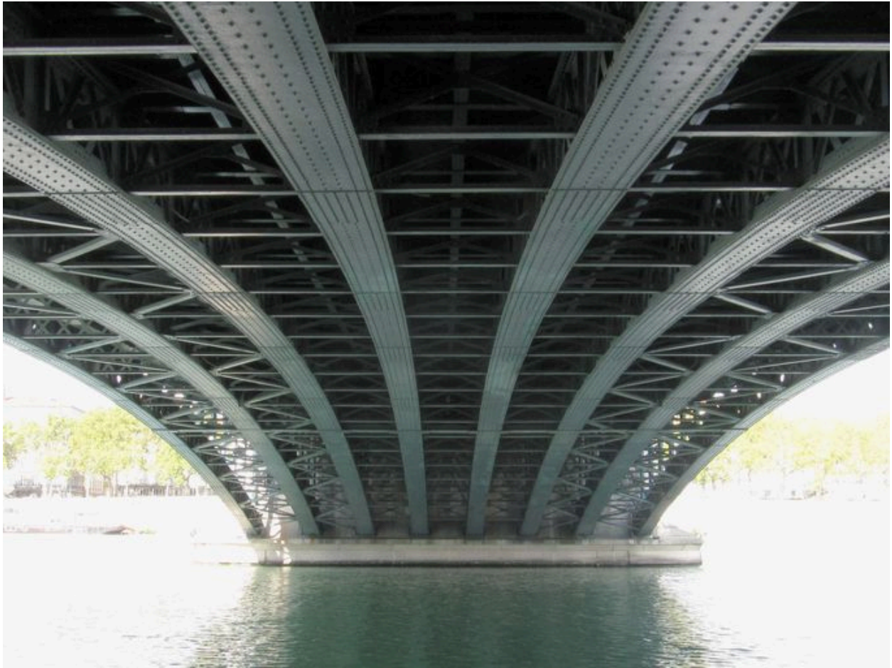
Vue partielle, de dessous, structure de l'arche et pile (depuis la rive gauche)
