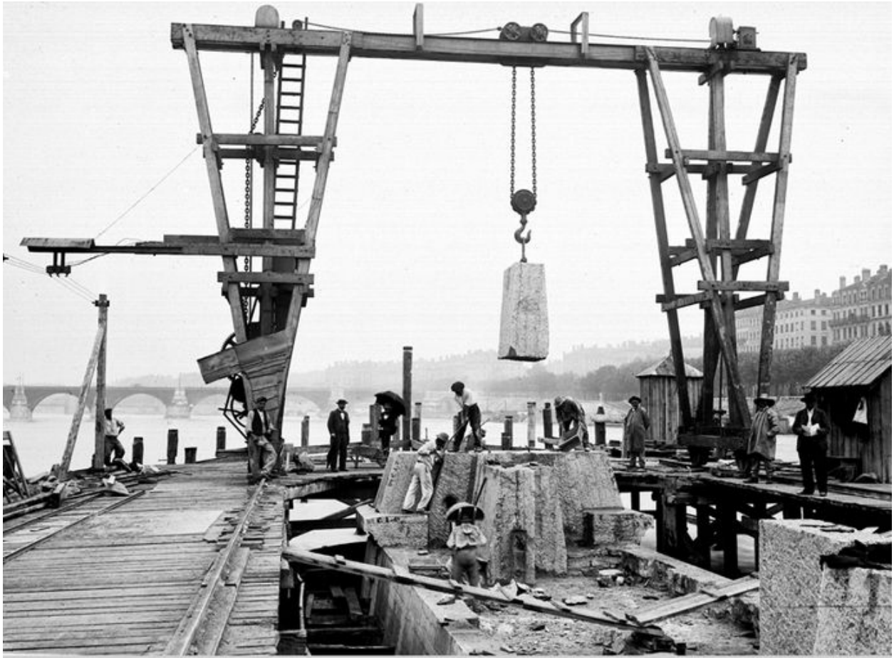
[La construction d'une pile]. [1901]. 1 fotogr. nég. (sur verre) : n. et b. (AM Lyon. 15 Ph 1/716)
