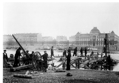
[La mise en place de la passerelle provisoire]. [1901]. 1 fotogr. nég. (sur verre) : n. et b. (AM Lyon. 15 Ph 1/695) Phot. AM Lyon IVR82_20106902504NUCAB
