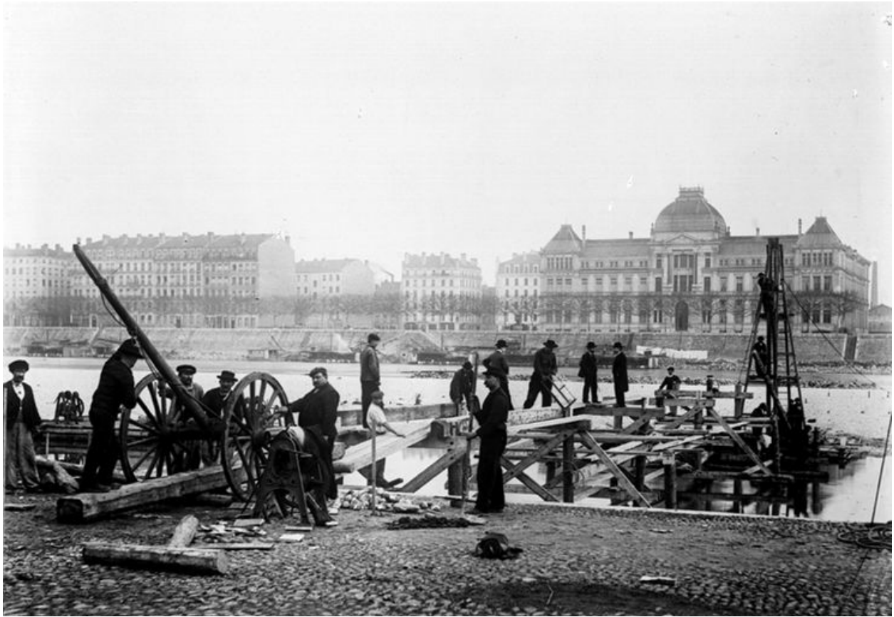
[La mise en place de la passerelle provisoire]. [1901]. 1 fotogr. nég. (sur verre) : n. et b. (AM Lyon. 15 Ph 1/695)
