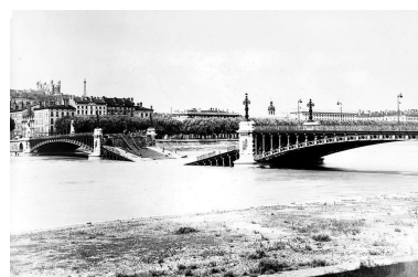
[Pont de l'Université, l'arche dynamitée]. [Septembre 1944]. 1 fotogr. pos. : n. et b. (AM Lyon. 3 Ph 170) Phot. AM Lyon IVR82_20106902525NUCAB
