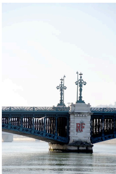
Pile, face amont, vue générale (depuis la rive gauche) Phot. G. Gellert IVR82_20106907267NUCA
