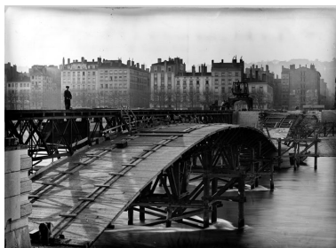
[La construction des cintres des arches métalliques]. [1901]. 1 photogr. nég. (sur verre) : n. et b. (AM Lyon. 15 Ph 1/735)
