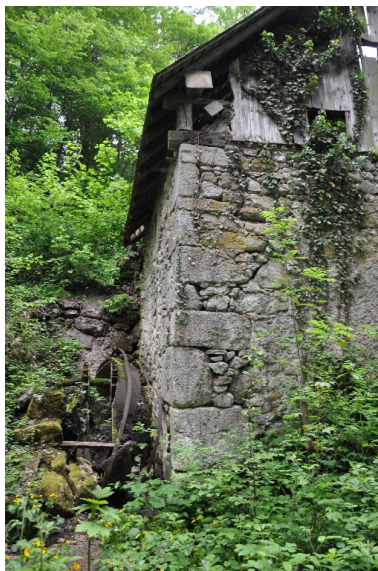
Vue de la partie ouest et nord, avec l'ancien emplacement de la roue verticale Phot. Yannick Milleret IVR82_20127301521NUCA
