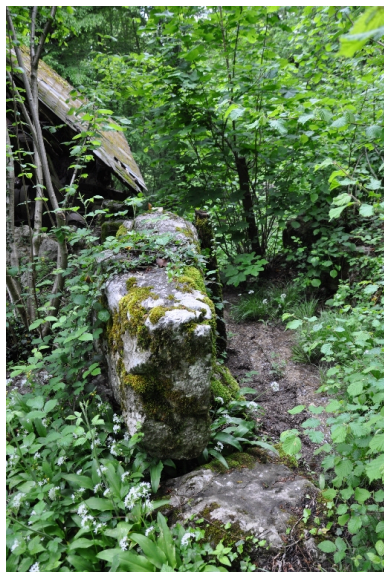
Canal d'amenée en pierre maçonnée au nord du moulin Phot. Yannick Milleret IVR82_20127301526NUCA
