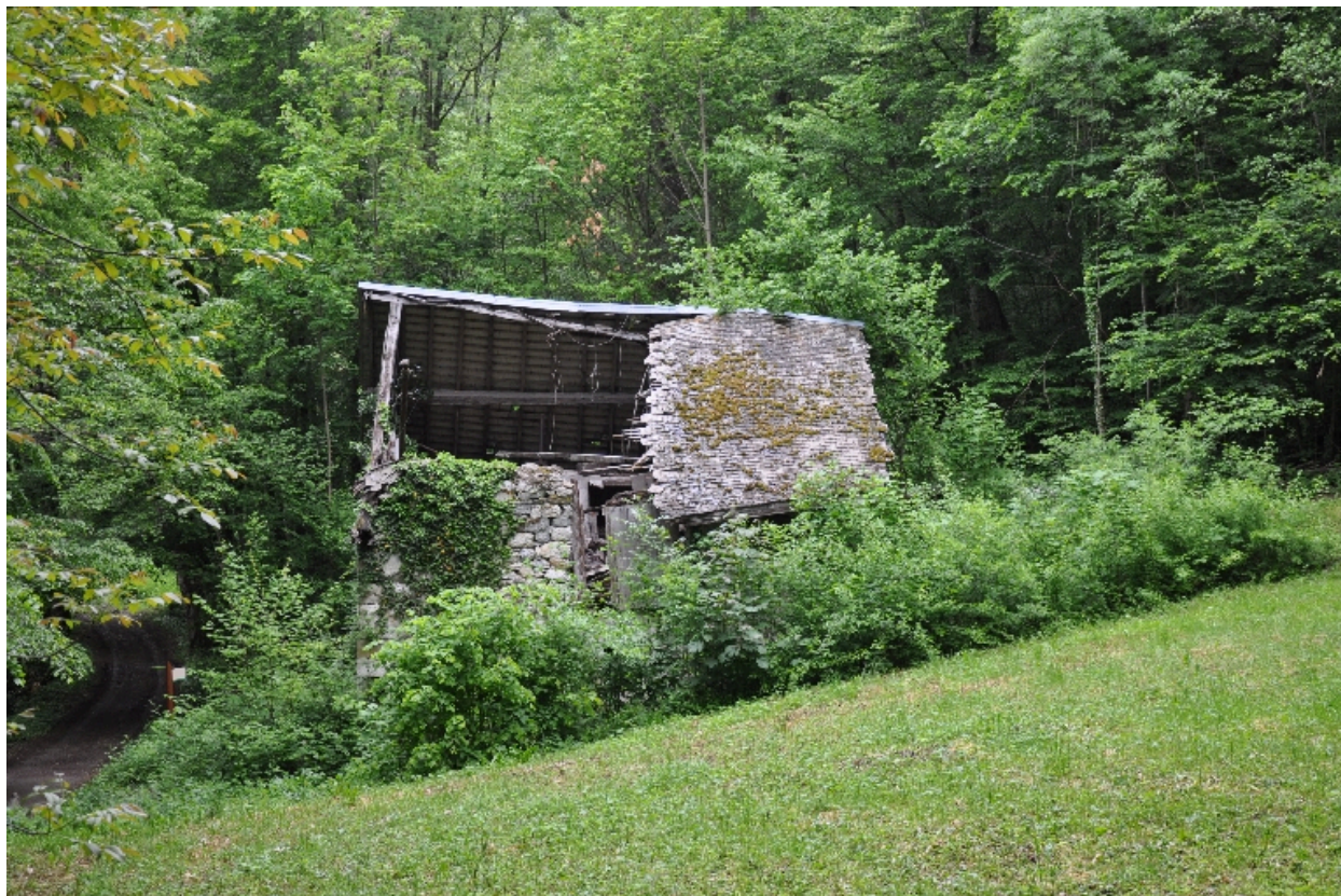
Vue sud du moulin envahi par la végétation
