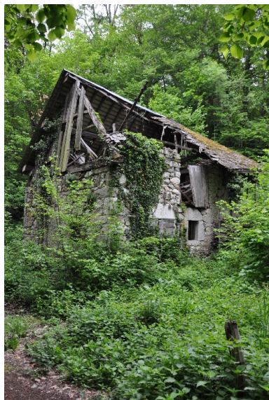
Vue générale du moulin Exertier, vue ouest Phot. Yannick Milleret IVR82_20127301520NUCA
