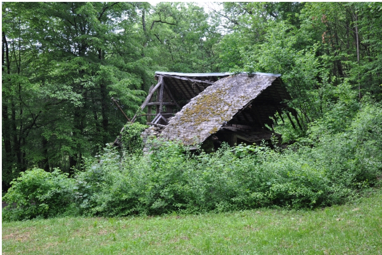
Vue nord du moulin
