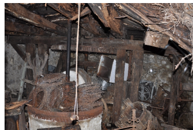
Vue intérieure du moulin avec la meule du battoir Phot. Yannick Milleret IVR82_20127301528NUCA
