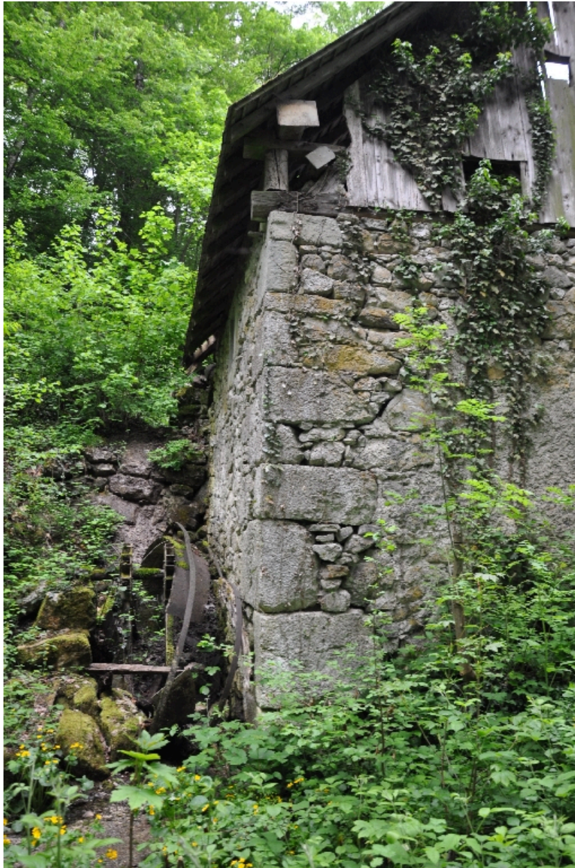
Vue de la partie ouest et nord, avec l'ancien emplacement de la roue verticale
