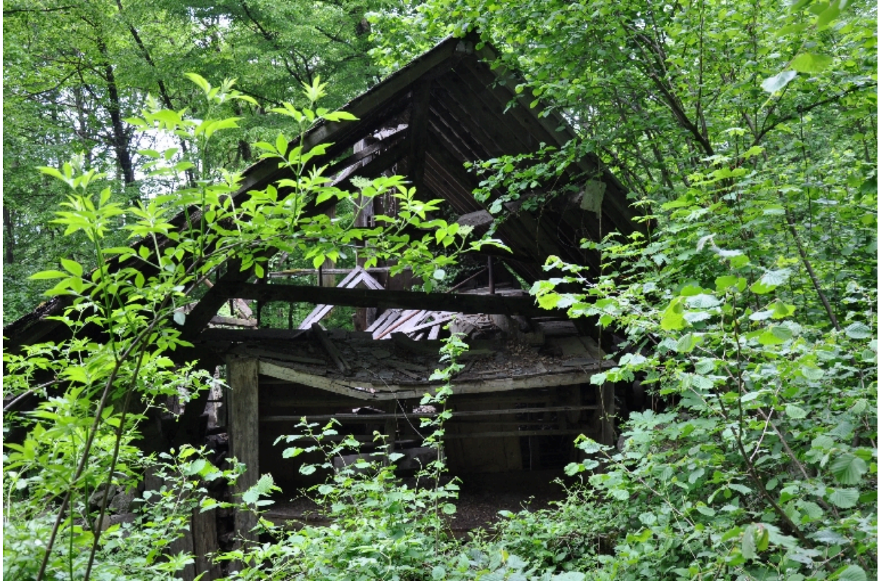
Vue de la façade nord du moulin avec des éléments de la bluterie
