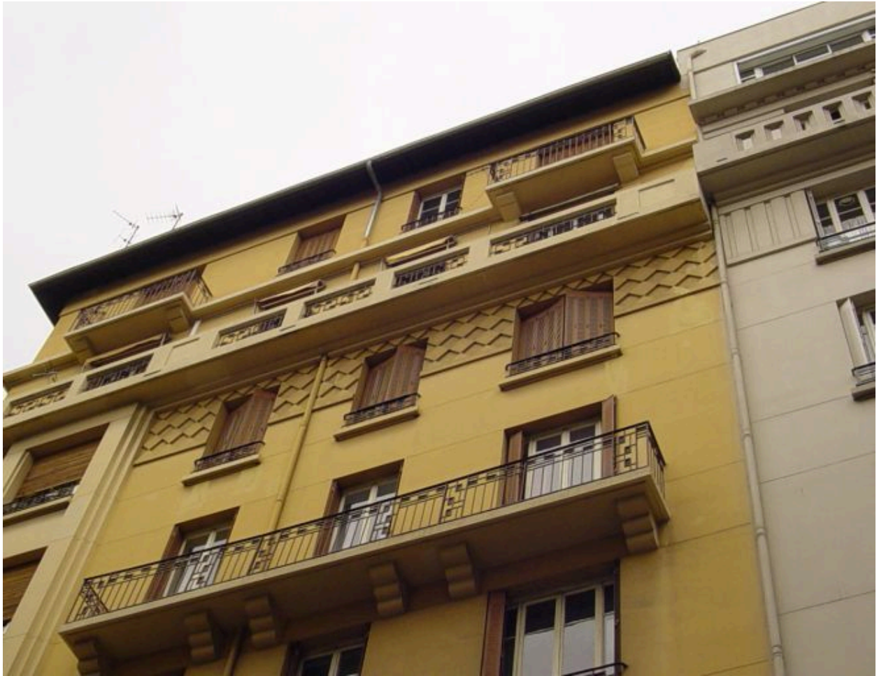
Vue du sommet de l'élévation rue Crillon
