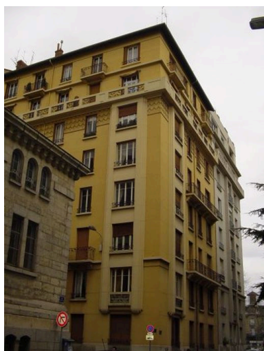
Vue générale de l'élévation depuis le sud-ouest Phot. Anaïs Beccaria IVR82_20046903336NUCA
