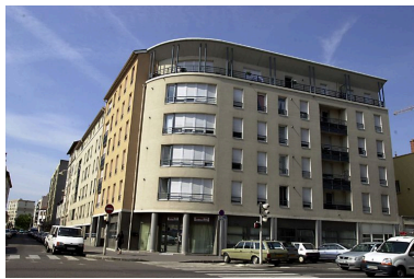
Vue générale Phot. Lore Derail IVR82_20036900453NUCA
