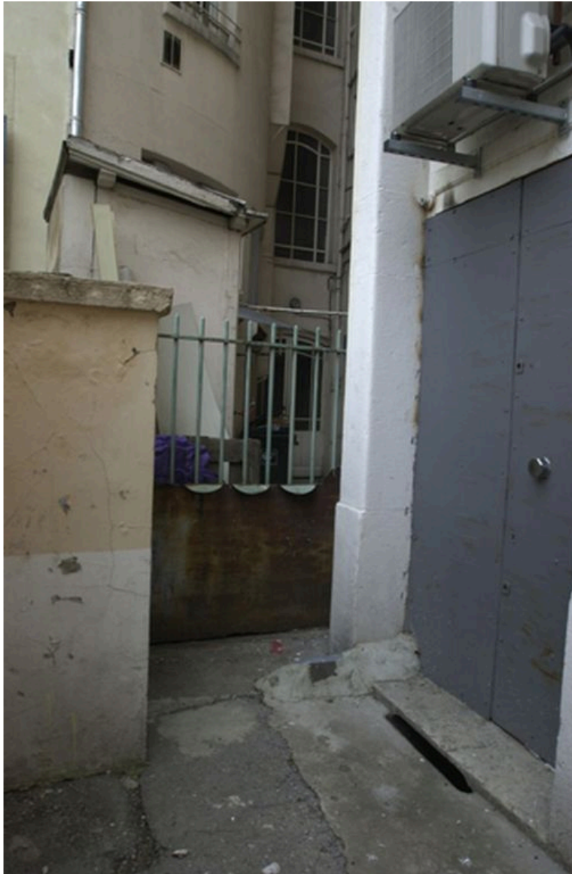
Vue du passage entre les cours du 56 et du 54, cours Gambetta
