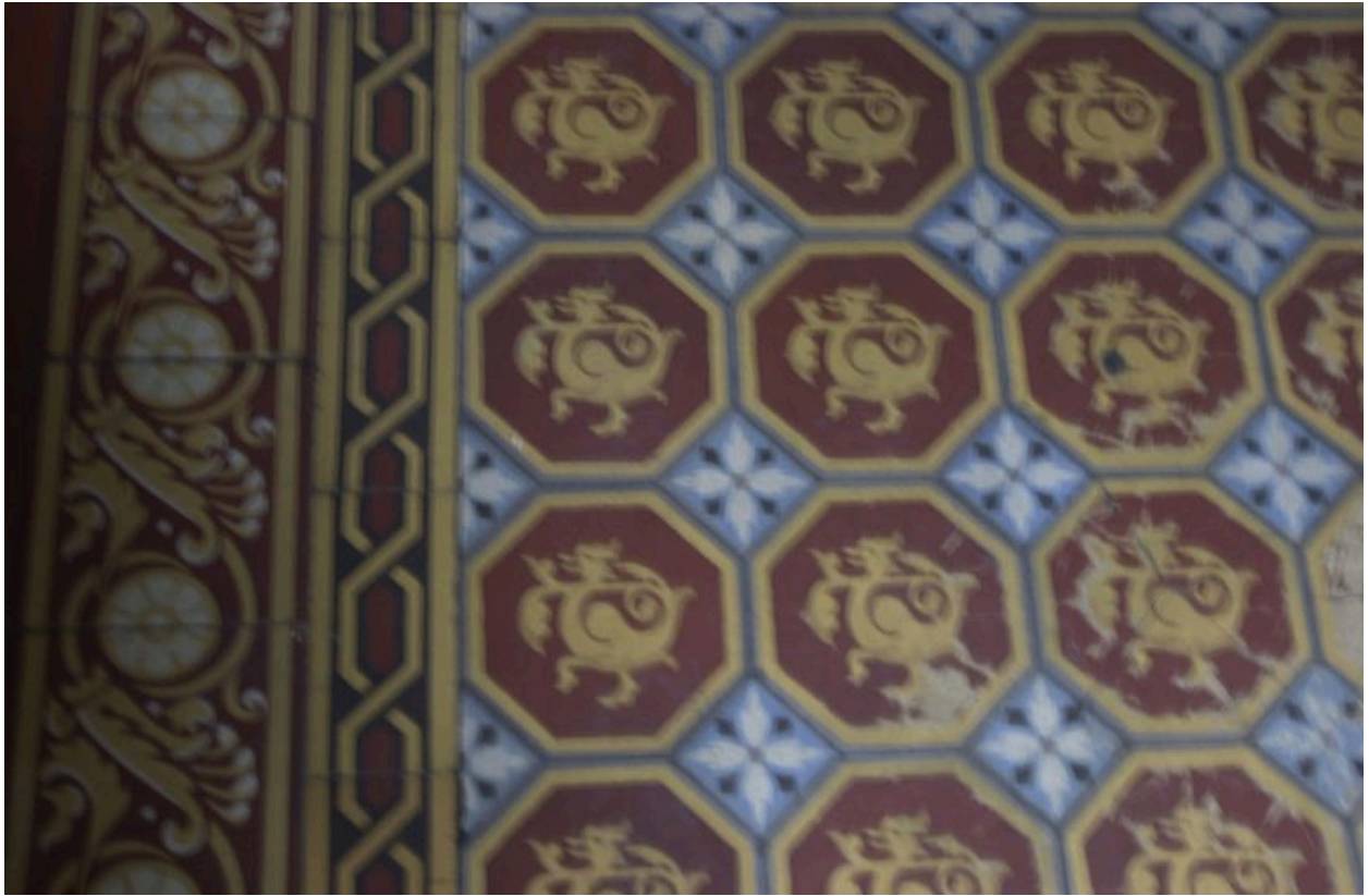
Carrelage à motifs de griffons du vestibule
