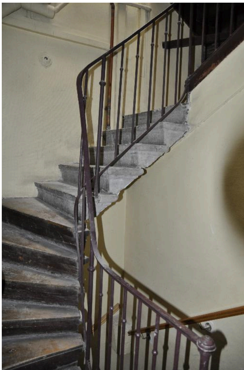
Vue de la deuxième volée de l'escalier
