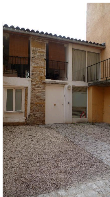
Vue de l'habitation sur cour Phot. Nadine Halitim-Dubois IVR82_20146900426NUCA
