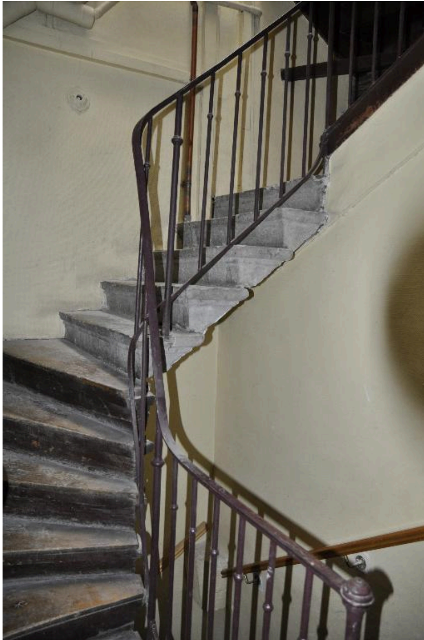
Vue de la deuxième volée de l'escalier
