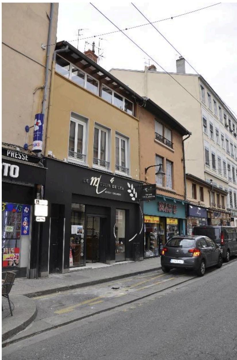
Vue d'ensemble nord ouest de l'immeuble avec une verrière
