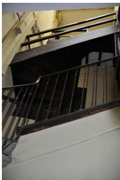
Vue des deux derniers niveaux de l'escalier Phot. Nadine Halitim-Dubois IVR82_20146900240NUCA
