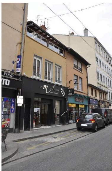
Vue d'ensemble nord ouest de l'immeuble avec une verrière Phot. Nadine Halitim-Dubois IVR82_20146900241NUCA
