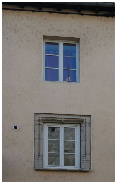
Fenêtre à encadrement de grès mouluré sur bases prismatiques Phot. Simone Hartmann-Nussbaum IVR82_20114202314NUCA
