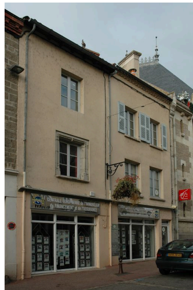
Vue générale (1ère maison). Phot. Simone Hartmann-Nussbaum IVR82_20114202307NUCA
