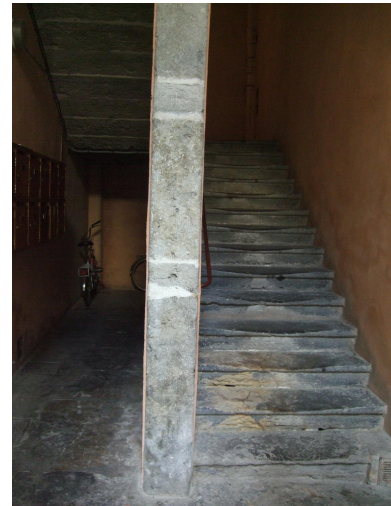
Escalier à mur noyau plein, rampe sur rampe Phot. Nadine Halitim-Dubois IVR84_20186901320NUCA
