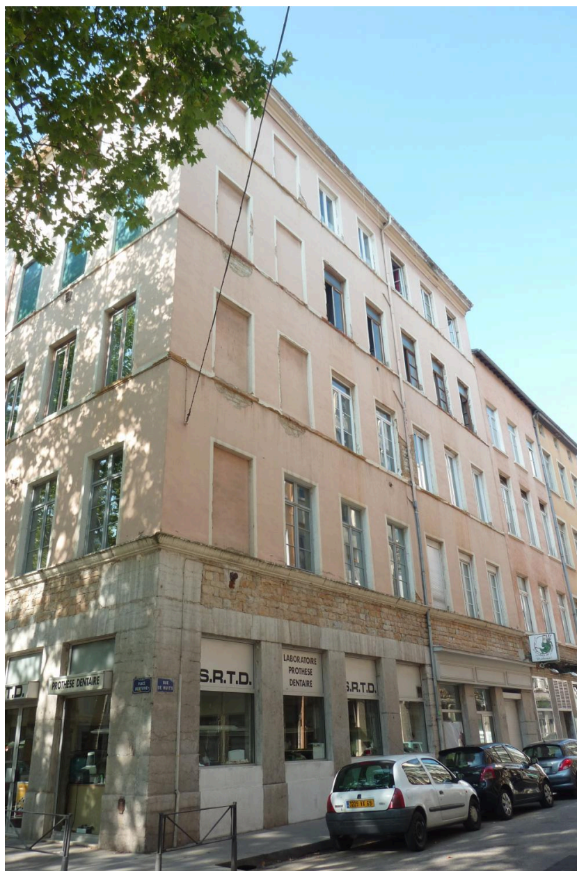
Vue d'ensemble de la longue façade 4, 6 rue de Nuits
