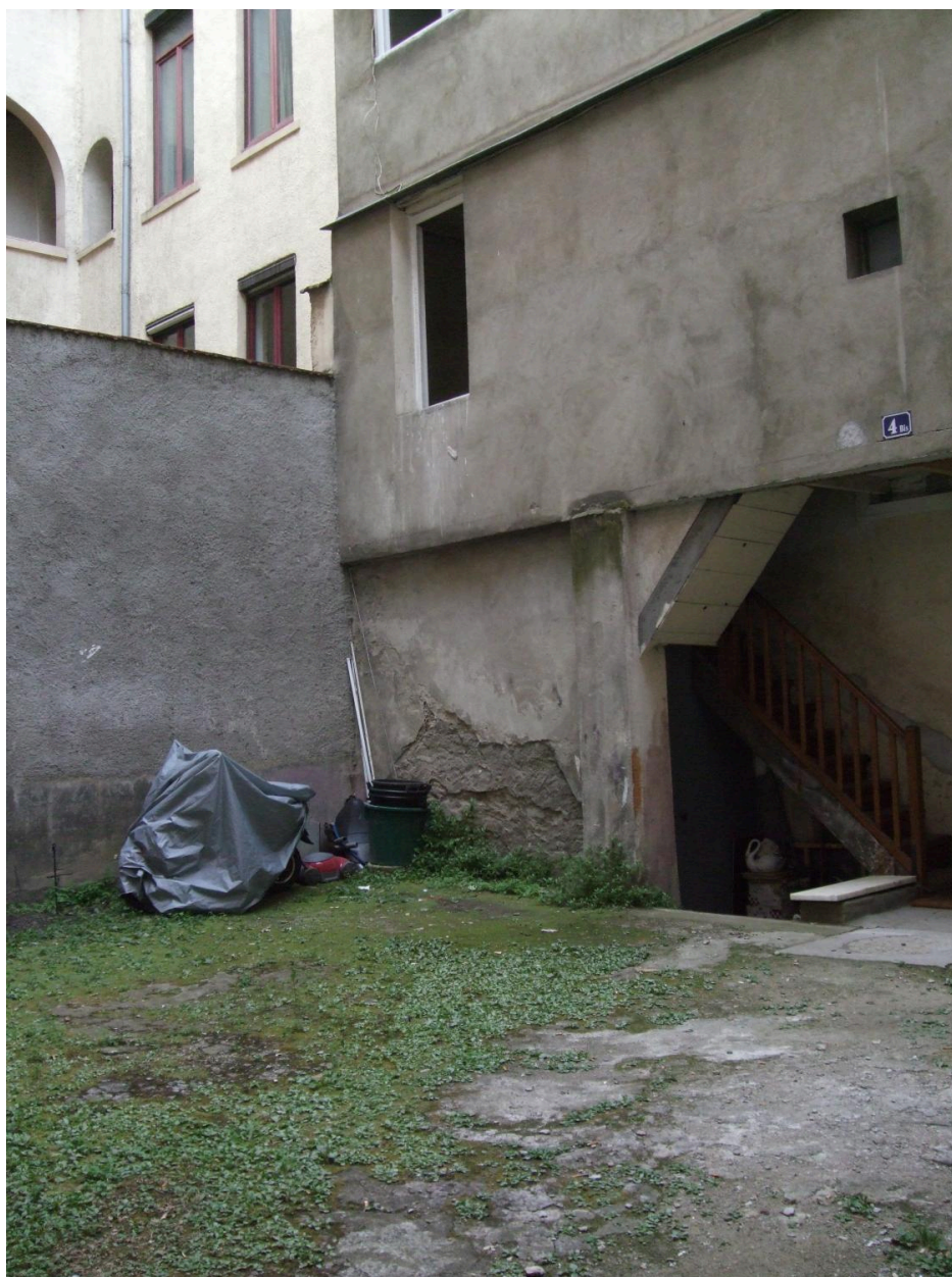
Vue de la cour (parcelle AW 9)
