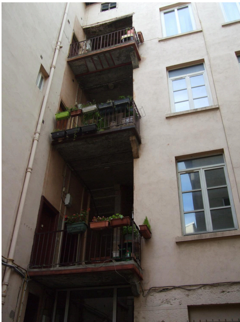
Façade sur cour ouverte avec galerie type balcon
