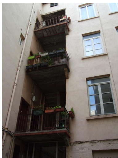
Façade sur cour ouverte avec galerie type balcon Phot. Nadine Halitim-Dubois IVR84_20186901321NUCA
