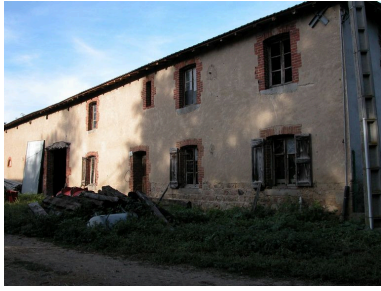
Vue générale, côté ouest (logis, grange-remise). Phot. Caroline Guibaud IVR82_20124202492NUCA
