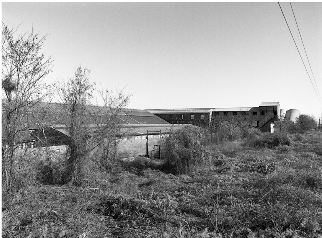
Bâtiments industriels en 2005, avant destruction.
