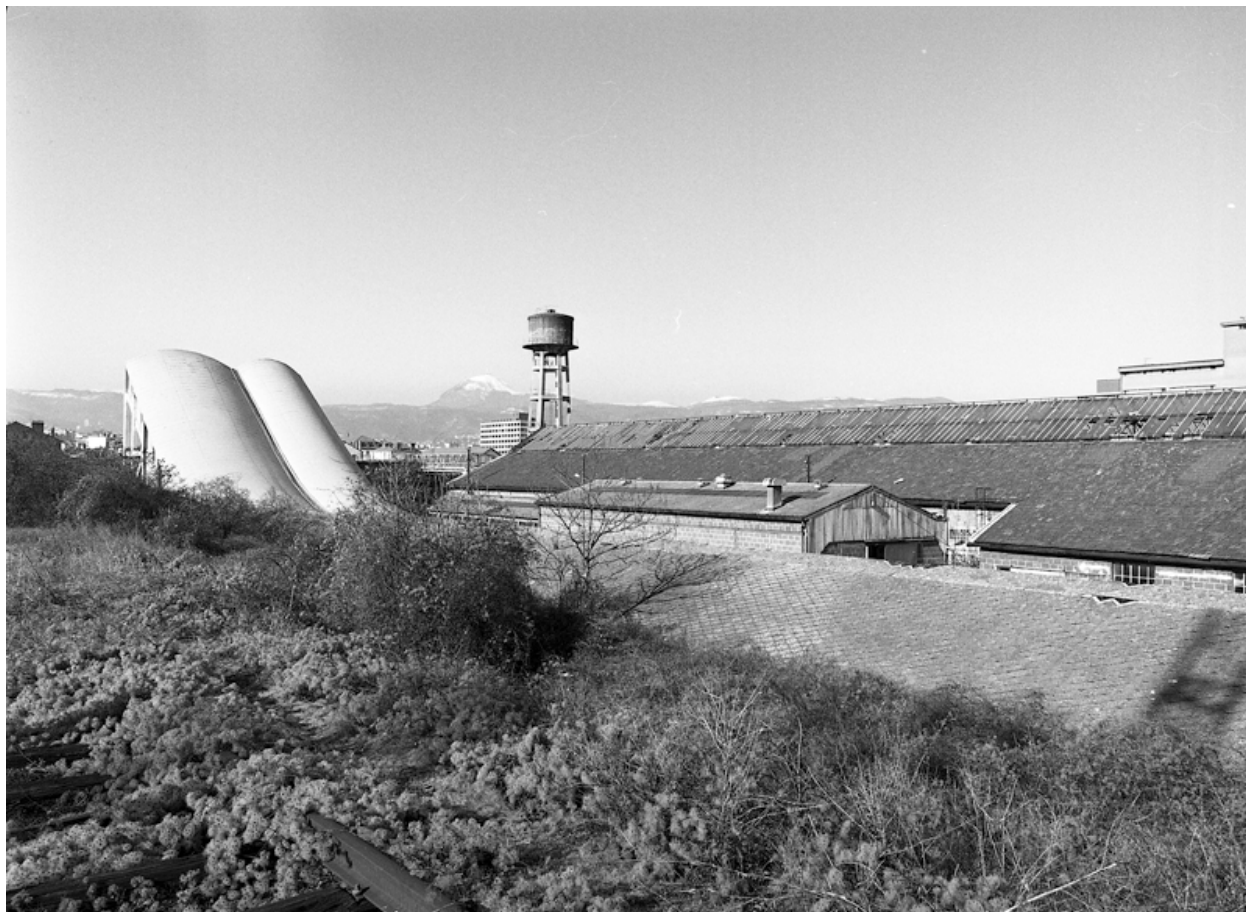
Bâtiments industriels et pistes d'essais en 2005, avant destruction.
