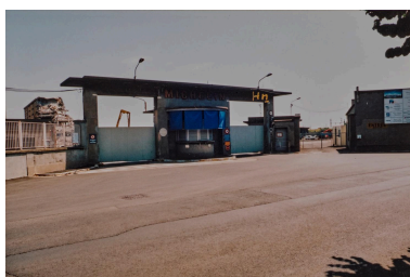
Vue de l'entrée du site, rue d'Estaing, lors du chantier de démolition, vers 2005. Repro. Christian Parisey, Autr. Hubert Merle IVR84_20246302385NUC4A
