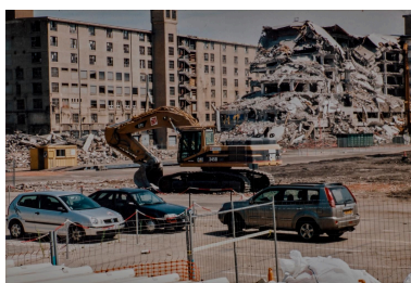
Vue partielle du site en cours de démolition, vers 2005 : destruction du bâtiment T32 (à l'arrière, le bâtiment T31 encore debout). Repro. Christian Parisey, Autr. Hubert Merle IVR84_20246302382NUC4A
