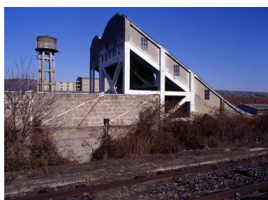
Pistes d'essais et bâtiments industriels en 2005, avant destruction. Phot. Roger Choplain IVR83_20056300019XA
