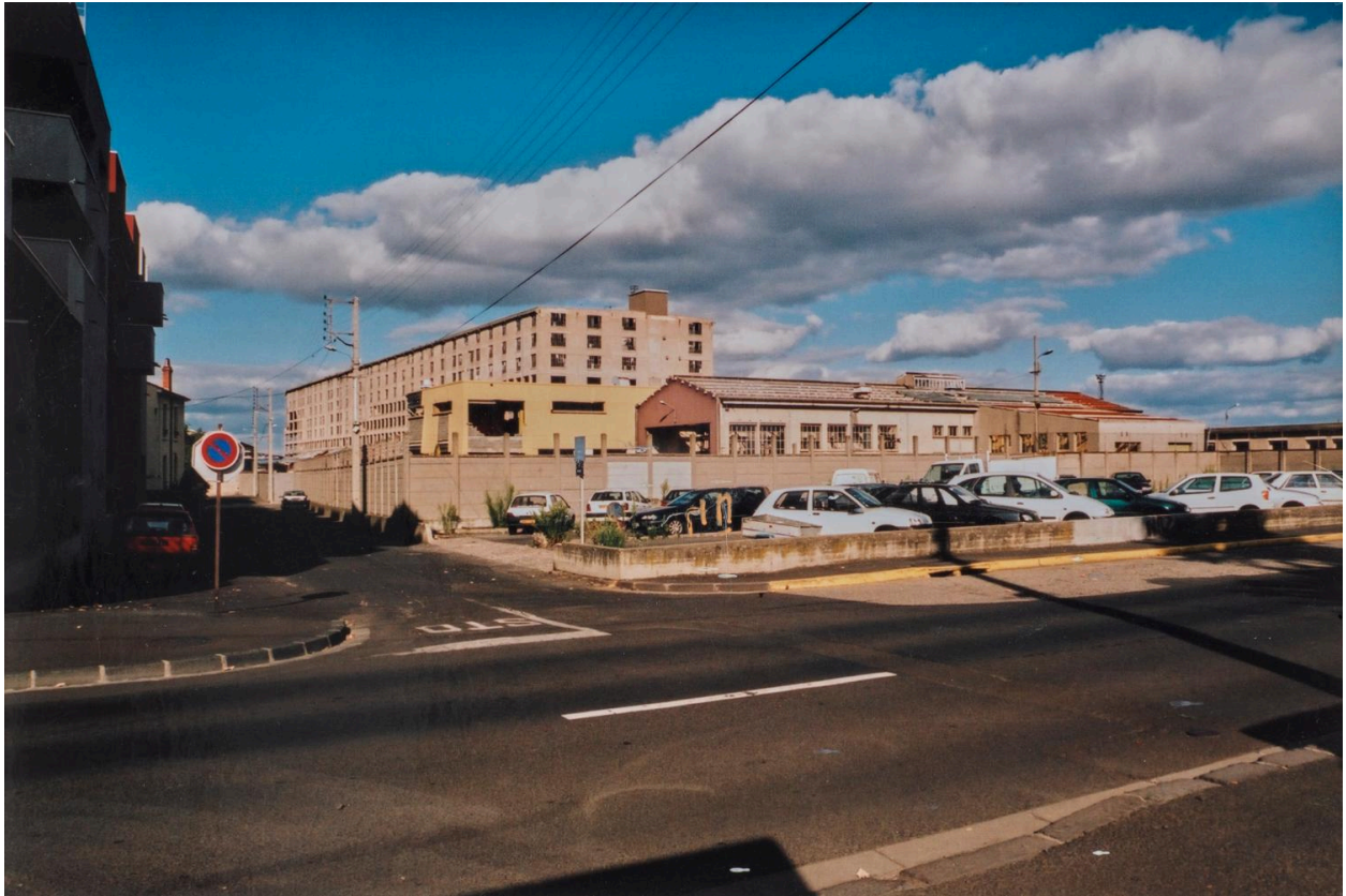
Vue partielle du site avant démolition, vers 2005, depuis l'angle des rues Molière et d'Estaing.
