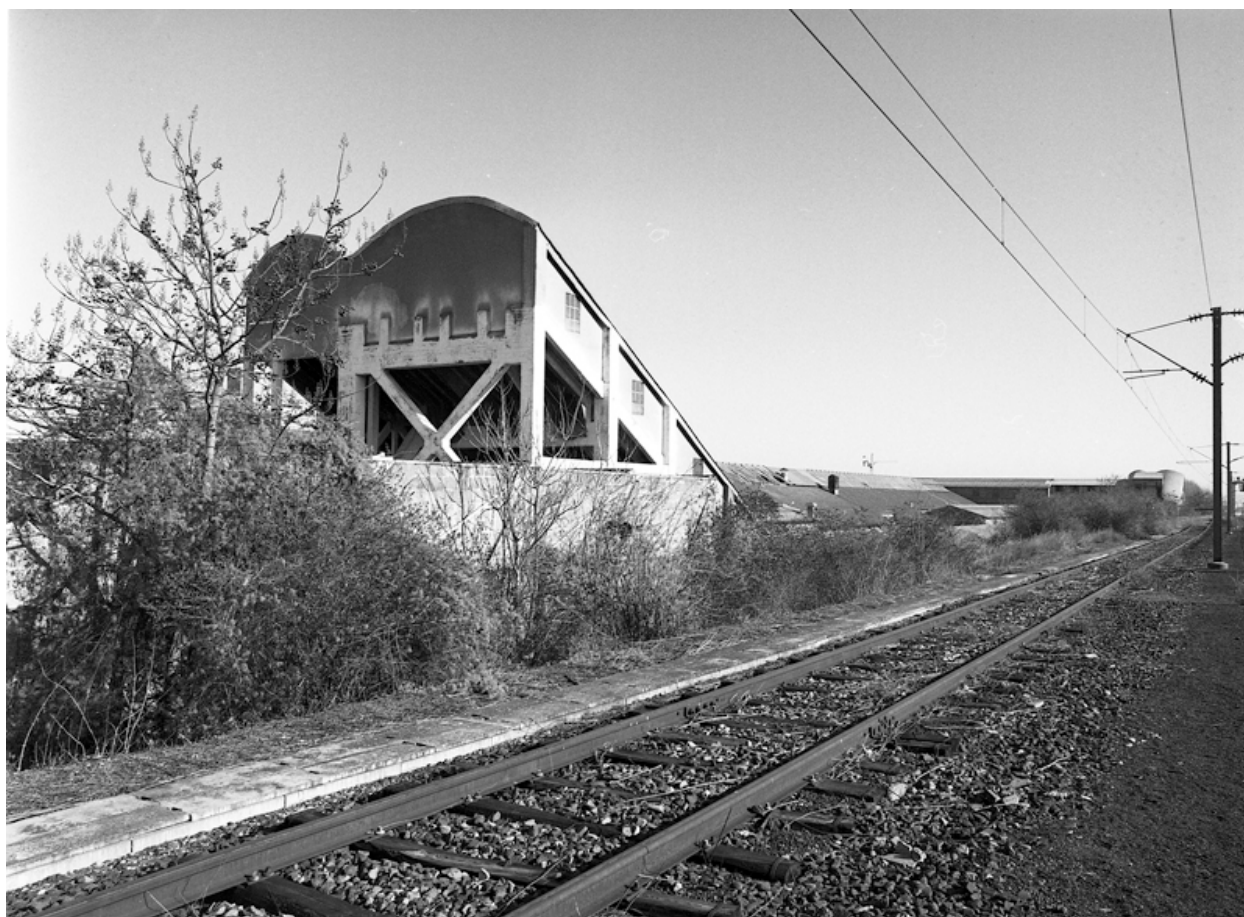
Pistes d'essais en bordure de voie ferrée en 2005, avant destruction.
