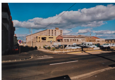
Vue partielle du site avant démolition, vers 2005, depuis l'angle des rues Molière et d'Estaing. Repro. Christian Parisey, Autr. Hubert Merle IVR84_20246302381NUC4A
