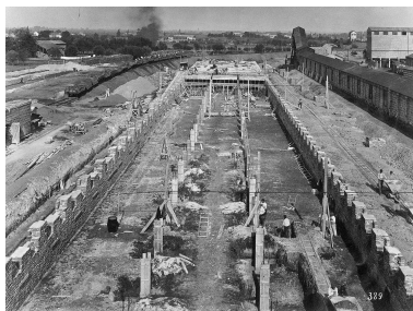
Chantier de construction à proximité des pistes d'essais. Vue prise après 1919, vraisemblablement au début des années 1920. Repro. Service de collecte et de valorisation des collections historiques de la Manufacture française des pneumatiques Michelin., Autr. auteur inconnu IVR84_20236300185NUC
