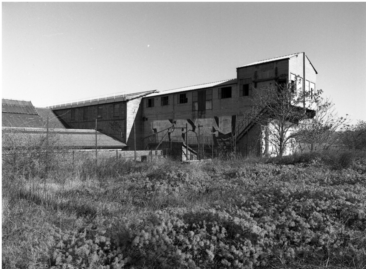
Bâtiments industriels en 2005, avant destruction.
