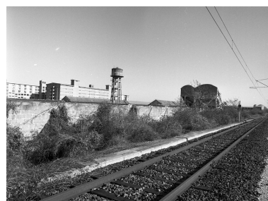
Le site Estaing en bordure de voie ferrée en 2005, avant destruction. Phot. Roger Choplain IVR83_20056300004X
