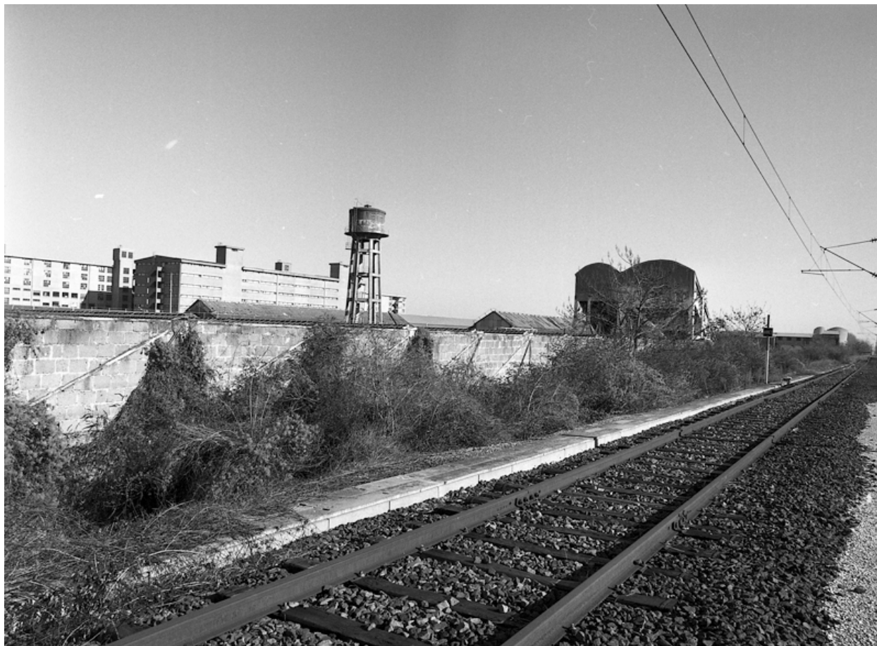
Le site Estaing en bordure de voie ferrée en 2005, avant destruction.
