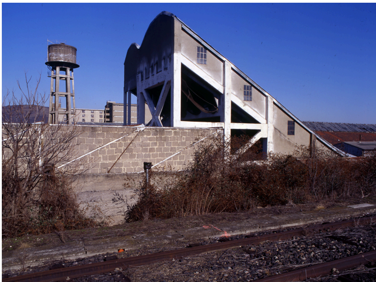
Pistes d'essais et bâtiments industriels en 2005, avant destruction.
