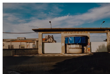
Vue de l'entrée du site, rue d'Estaing, lors du chantier de démolition, vers 2005. Repro. Christian Parisey, Autr. Hubert Merle IVR84_20246302384NUC4A
