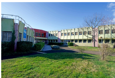
Vue d'ensemble. Phot. Michel Pérès IVR84_20206900502NUCA
