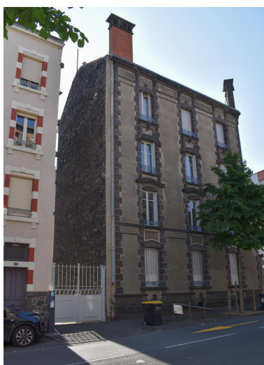
Elévation sur l'avenue d'Italie Phot. Félicie Fougère IVR84_20246300031NUCA
