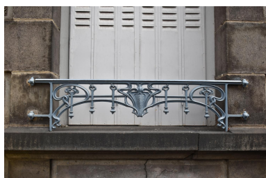
garde-corps des baies, 1 rue d'Alsace Phot. Félicie Fougère IVR84_20246300087NUCA
