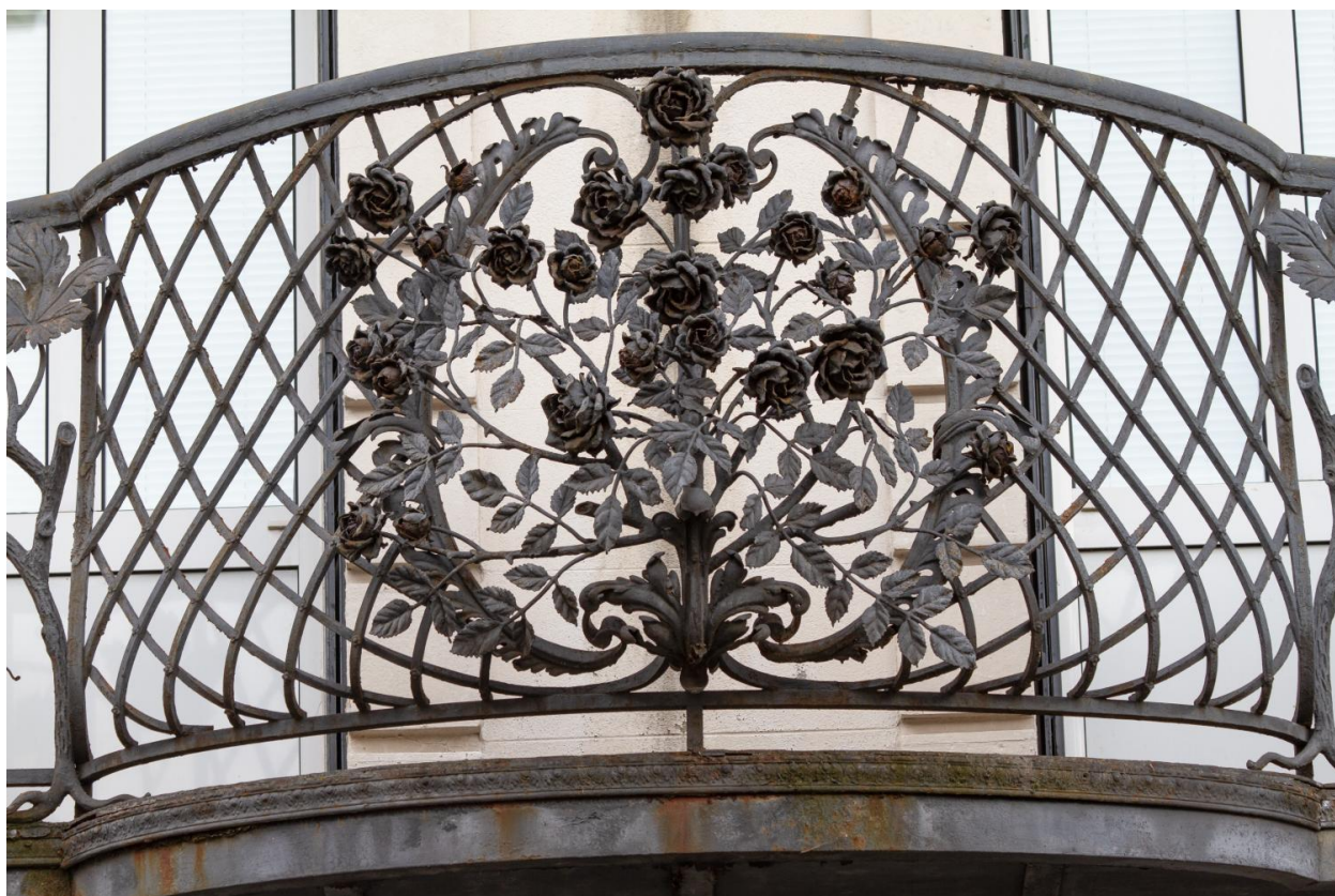
Garde corps en fer forgé, anciens ateliers Bernardin
