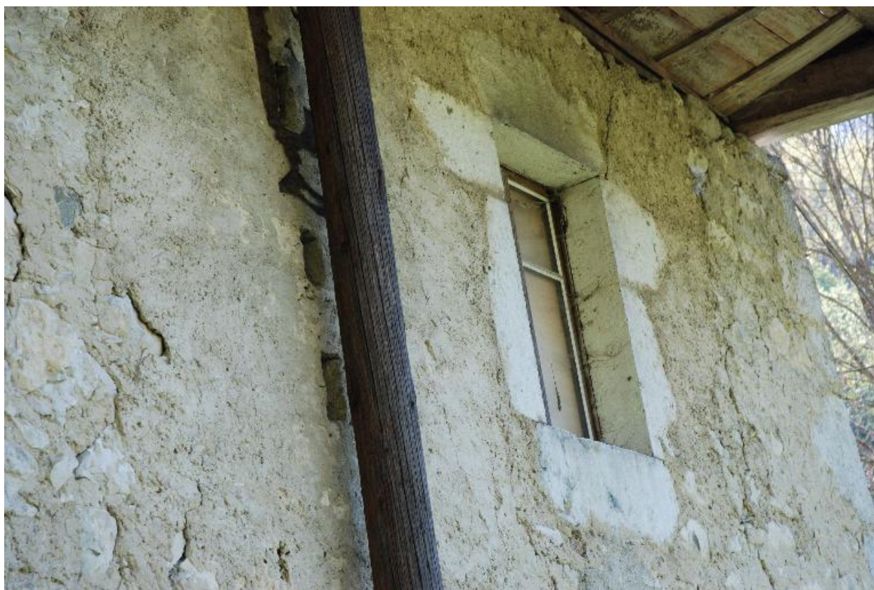
Détail baie étage et jours de placard mural, façade avant.
