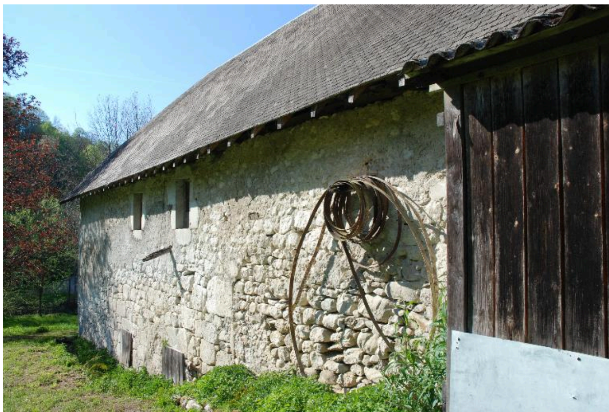
Vue partielle de la façade arrière.
