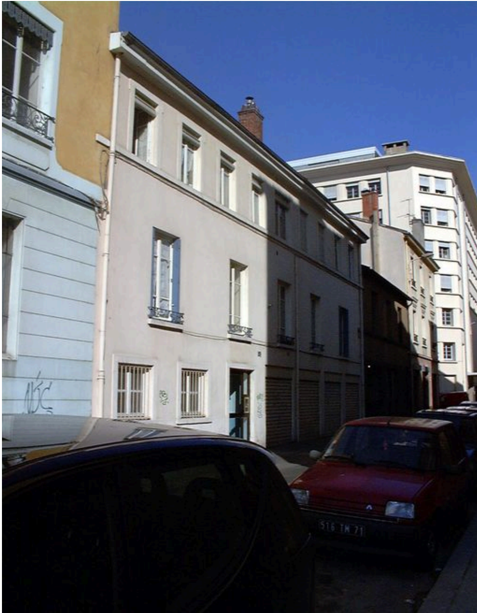
Partie droite de la façade sur la rue de Créqui
