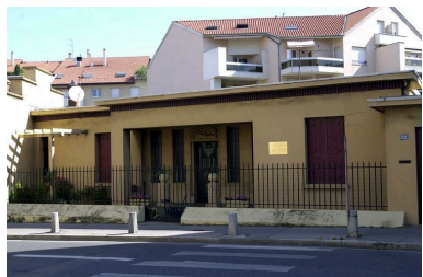
Maison, façade sur la rue de Belfort Phot. Bernard Ducouret IVR82_20026901936NUCA
