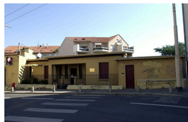
Maison, façade sur la rue de Belfort Phot. Bernard Ducouret
