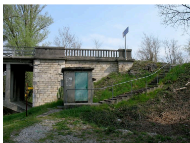
Vue partielle, culée droite et accès à la rive, face amont (depuis la rive droite) Phot. I. Havard IVR82_20107300070NUCA
