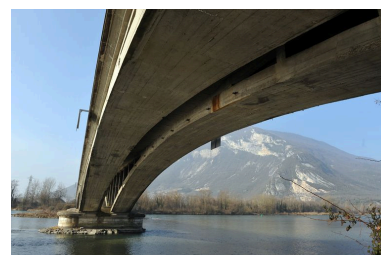
Vue générale, de dessous, face aval (depuis la rive gauche) Phot. G. Gellert IVR82_20107300062NUCA
