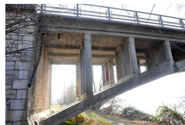
Arche gauche, face amont, vue de détail : structure (depuis la rive gauche) Phot. G. Gellert IVR82_20107300067NUCA
