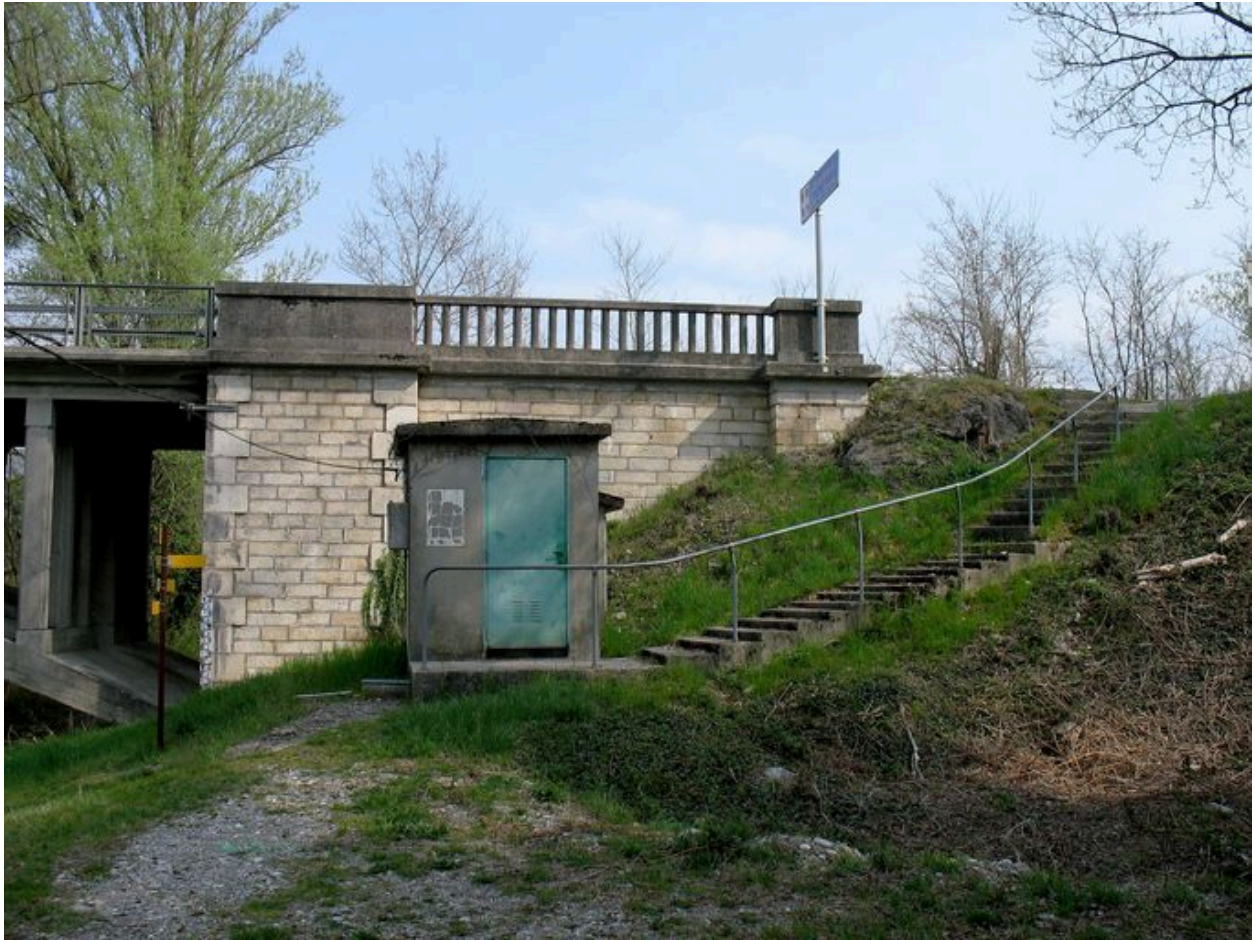
Vue partielle, culée droite et accès à la rive, face amont (depuis la rive droite)
