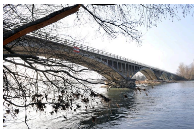
Vue générale, face amont (depuis la rive gauche) Phot. G. Gellert IVR82_20107300066NUCA
