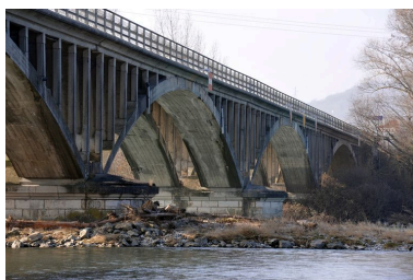
Vue partielle, de côté, face amont (depuis la rive gauche) Phot. G. Gellert IVR82_20107300065NUCA
