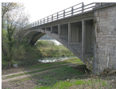
Vue partielle, arche gauche, face aval (depuis la rive gauche) Phot. I. Havard IVR82_20107300069NUCA
