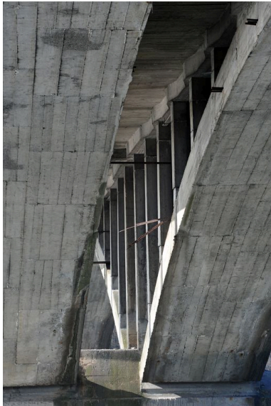
Pile, de dessous, vue partielle (depuis la rive gauche) Phot. G. Gellert IVR82_20107300064NUCA
