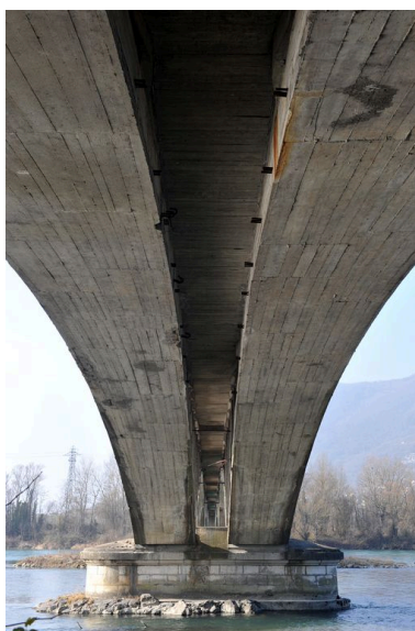
Vue générale, de dessous (depuis la rive gauche) Phot. G. Gellert IVR82_20107300061NUCA
