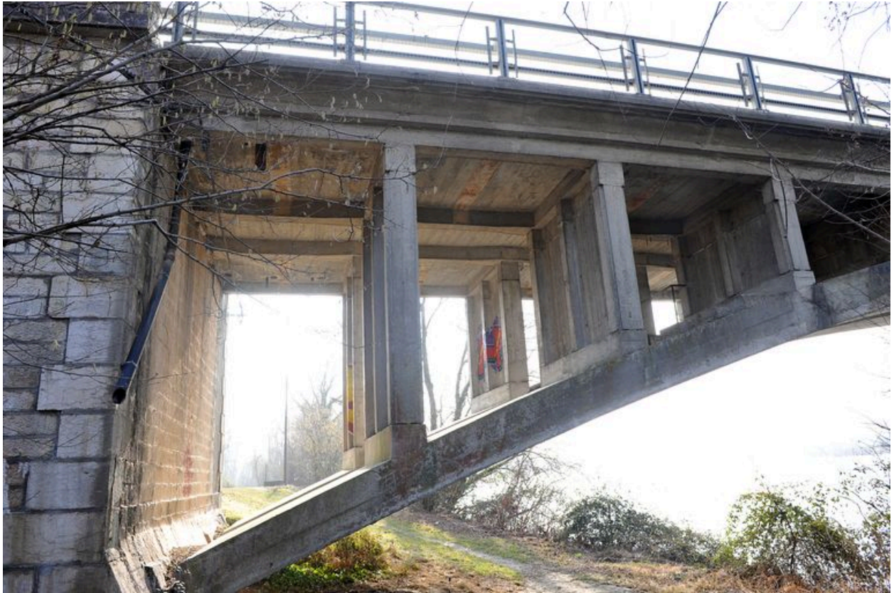
Arche gauche, face amont, vue de détail : structure (depuis la rive gauche)
