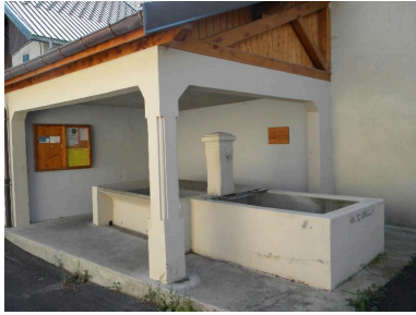
Vue d'ensemble Phot. Jérôme Daviet IVR82_20147400026NUCA
