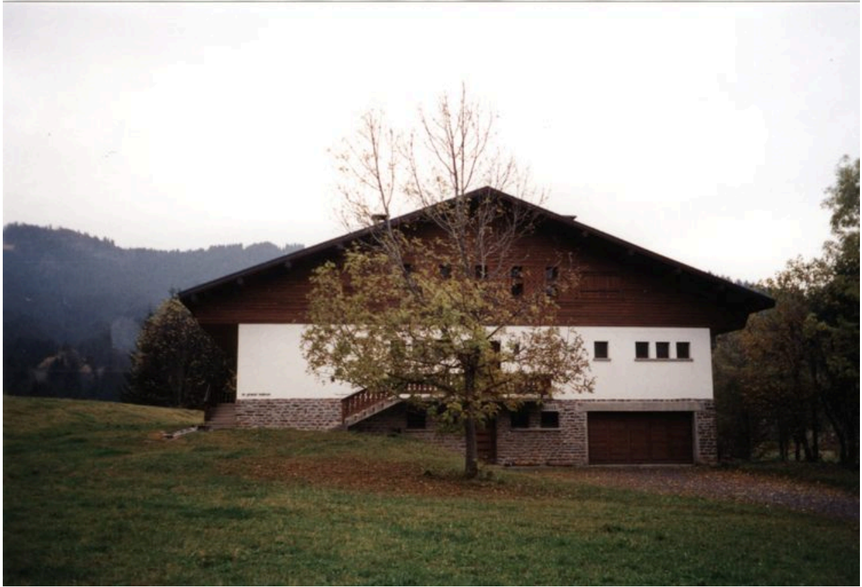
Vue générale depuis le nord-est. Façade antérieure
