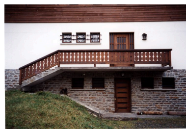
Détail de l'entrée principale Phot. F. Véry IVR82_20127402091NUCA
