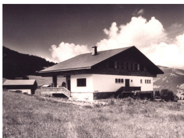
Vue d'ensemble depuis l'est. Photograph., vers 1965 Phot. F. Véry IVR82_20127402082NUCAB
