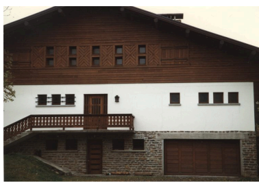
Entrée principale Phot. F. Véry IVR82_20127402088NUCA
