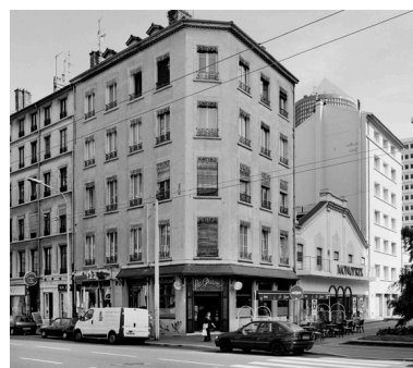
Vue d'ensemble nord-ouest Phot. Didier Gourbin IVR82_20056900101X
