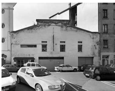
Vue sud Phot. Jean-Marie Refflé IVR82_20026904429V
