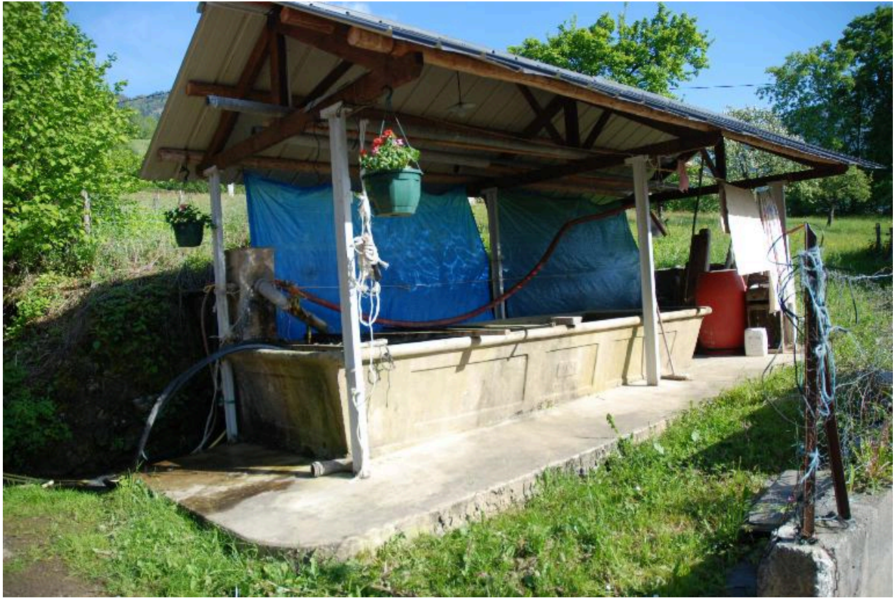
Ferme à la Pierre (2013 A3 436), non repérée. Vue du bassin-abreuvoir.
