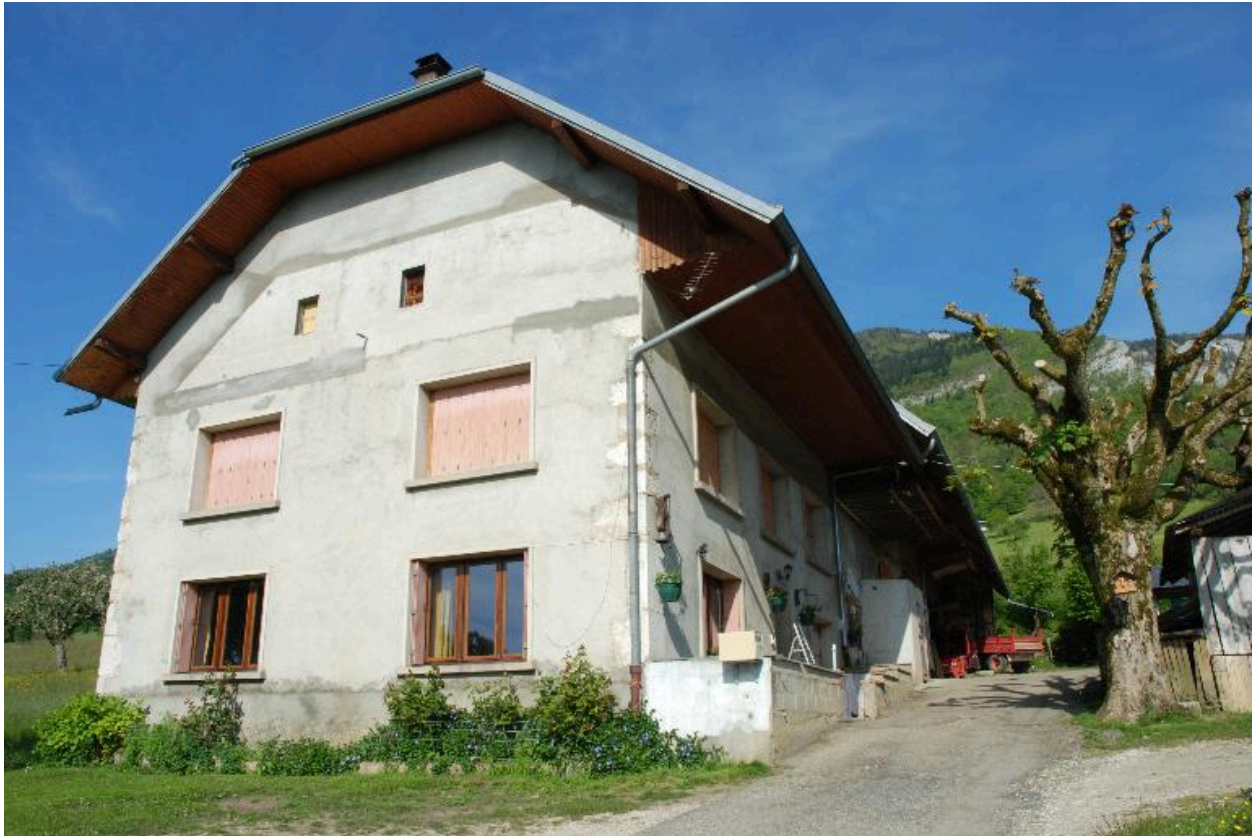
Ferme à la Pierre (2013 A3 436), non repérée. Vue d'ensemble depuis le sud-ouest.
