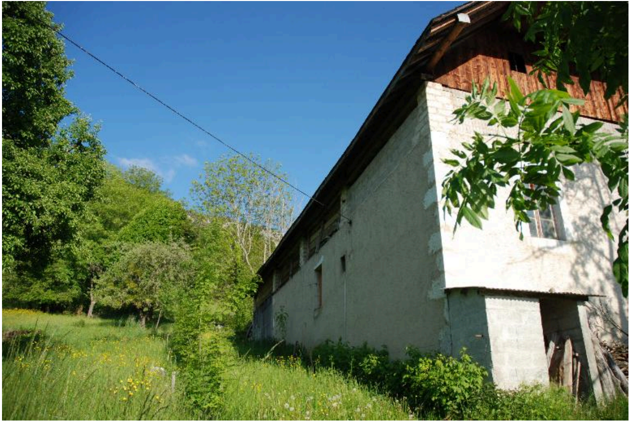
Maison aux Mollières (2013 B1 37), non repérée. Vue d'ensemble depuis le nord-ouest.
