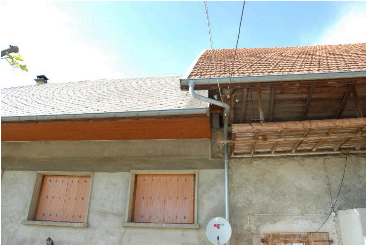
Ferme à la Pierre (2013 A3 436), non repérée. Raccord entre le logis et la grange-étable.
