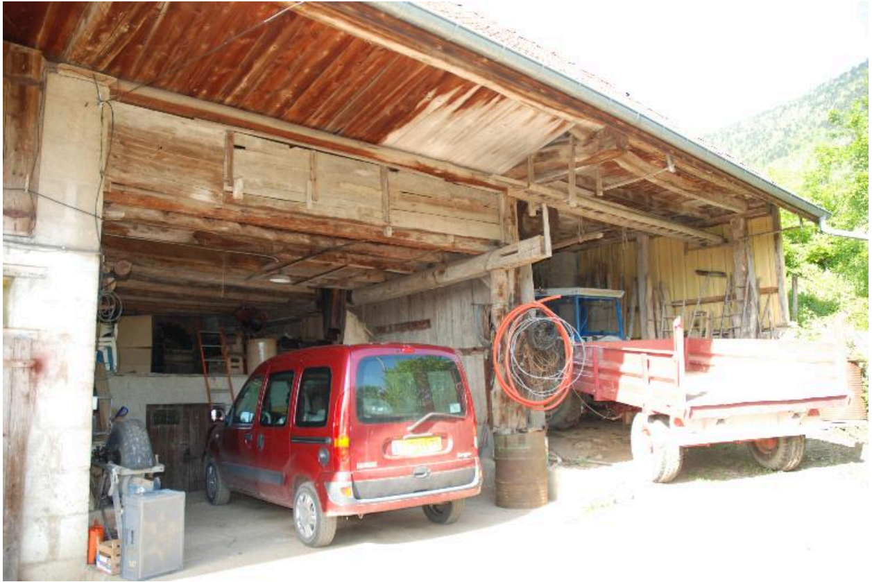
Ferme à la Pierre (2013 A3 436), non repérée. Pressoir à cidre et remise.
