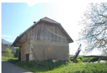
Vue d'une grange-étable (2013 A3 446), non repérée. Phot. Thierry Monnet IVR82_20147302337NUCA
