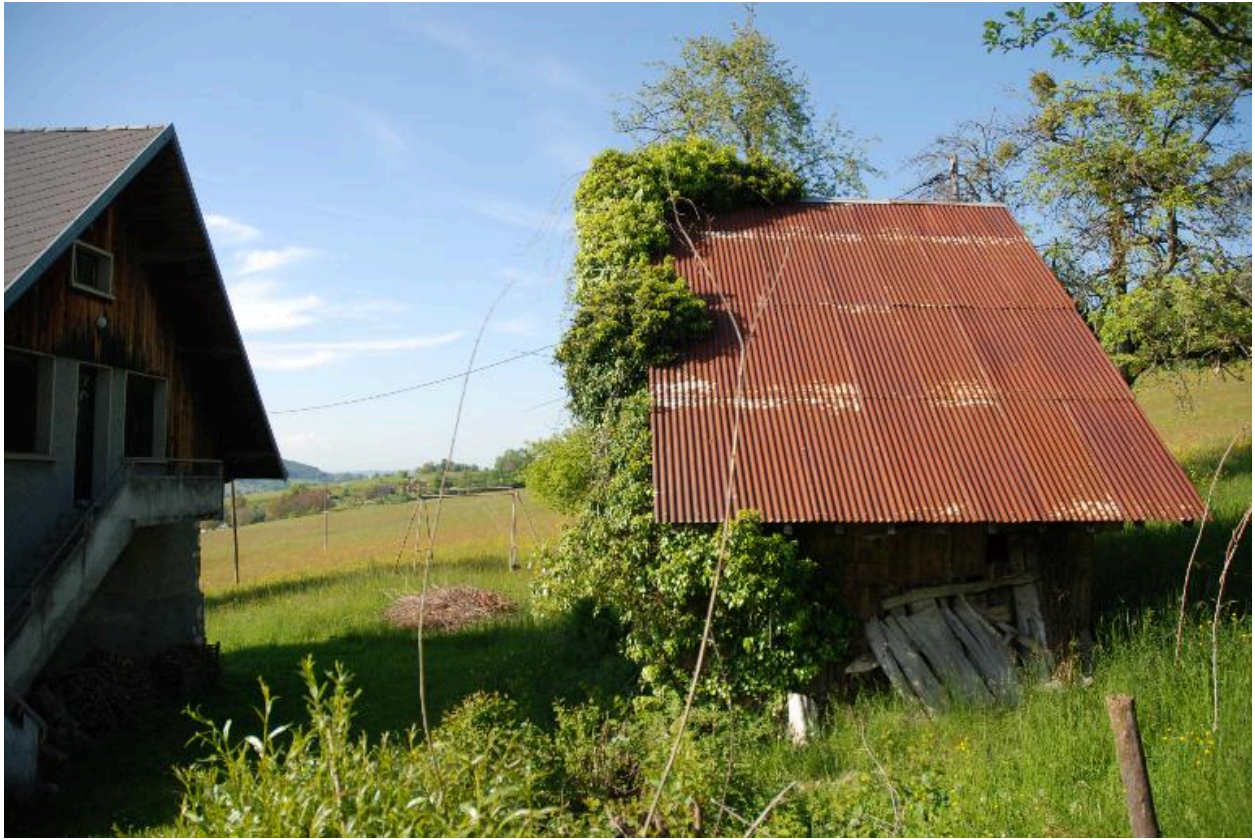
Maison à la Pierre (2013 A3 426, 427), non repérée. Vue de la partie détruite.
