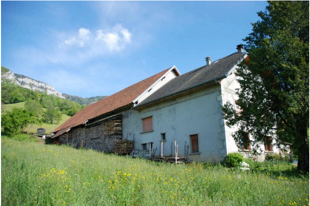
Ferme à la Pierre (2013 A3 436), non repérée. Vue d'ensemble arrière.
