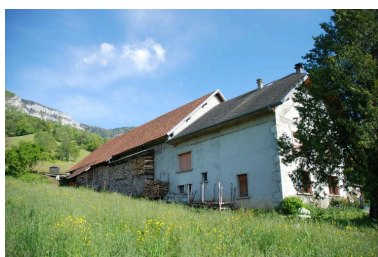
Ferme à la Pierre (2013 A3 436), non repérée. Vue d'ensemble arrière. Phot. Caroline Guibaud IVR82_20147302355NUCA
