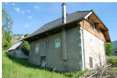
Maison à la Pierre (2013 A3 427), non repérée. Vue arrière. Phot. Caroline Guibaud IVR82_20147302357NUCA
