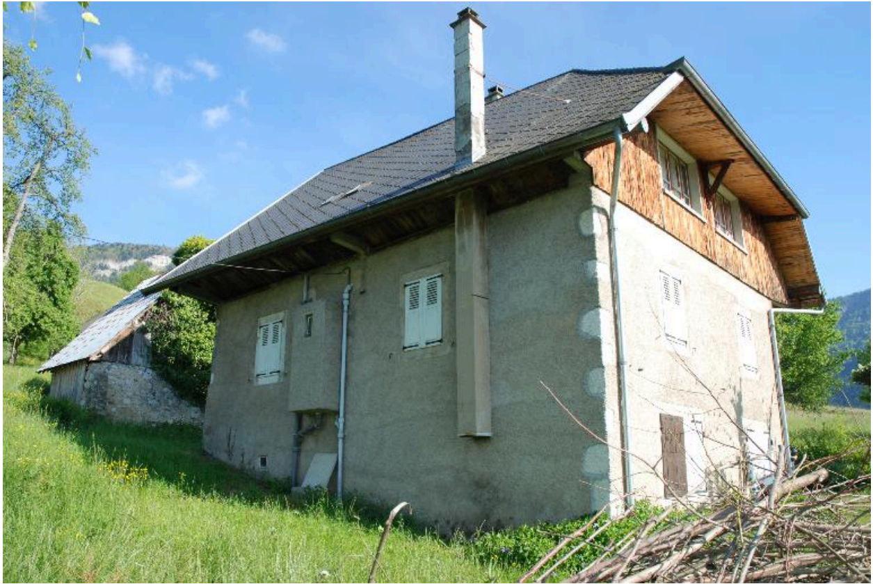
Maison à la Pierre (2013 A3 427), non repérée. Vue arrière.
