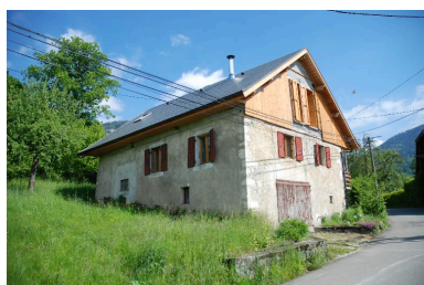
Vue arrière de la ferme 2013 A3 445 (non repérée). Phot. Caroline Guibaud IVR82_20147302340NUCA
