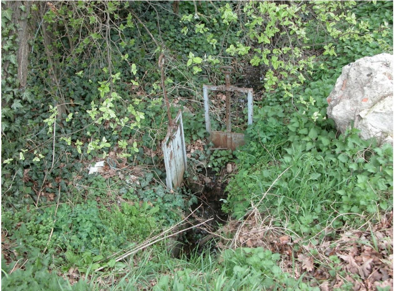
Vannes sur une artériole du canal du Forez au Breuil (1986 E2 203).
